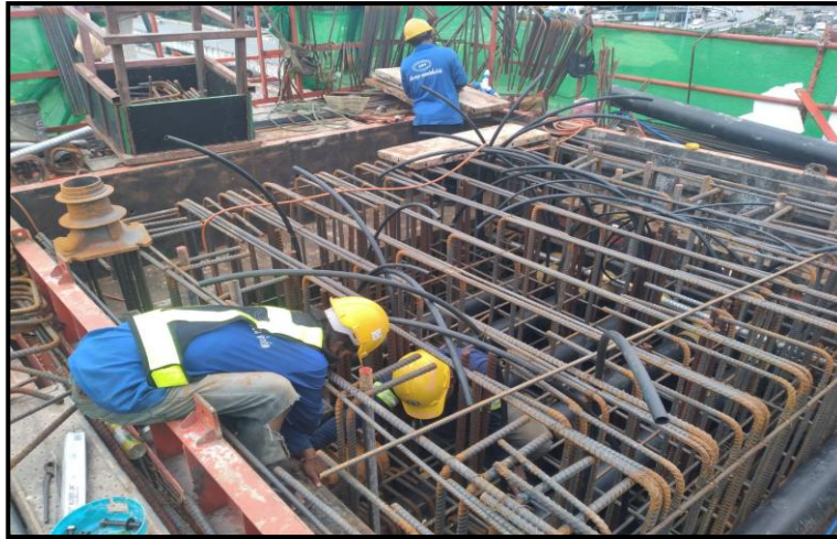
MLP03-03L งานผูกเหล็กเสริม Crossbeam Interface Type PT-44A
