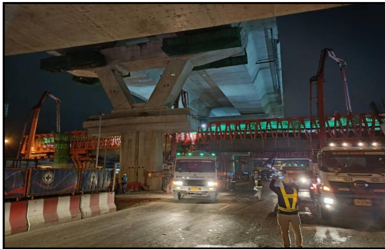
MLP01-08 งานเทคอนกรีต Lower Crossbeam Type PTT-1
