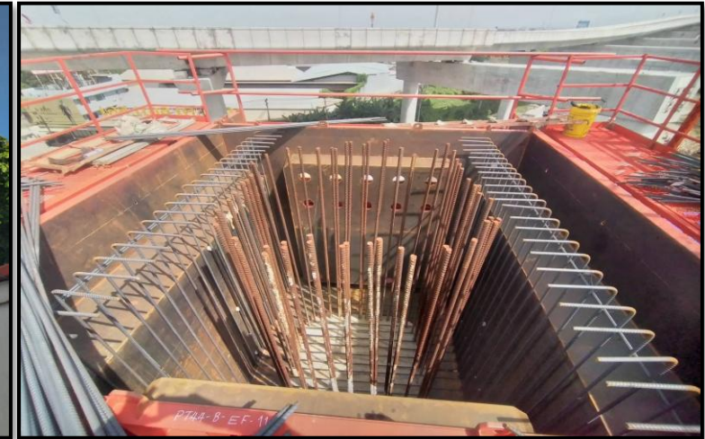
MLP02-27L งานผูกเหล็กเสริม Crossbeam Interface Type PT-44A
