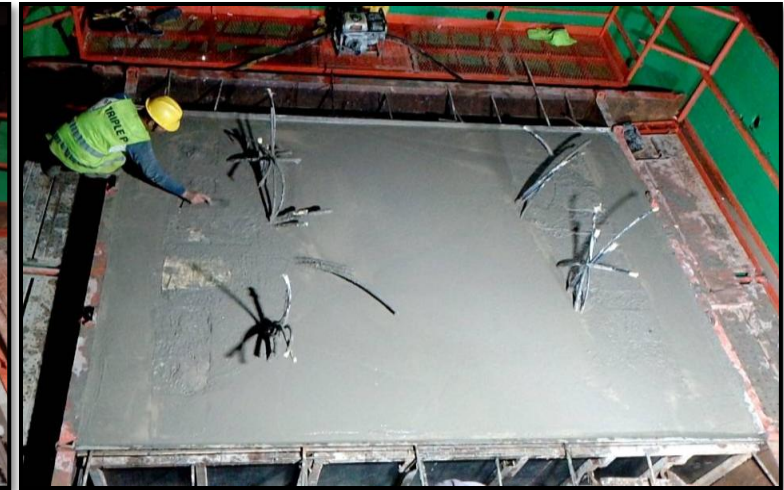
MLP02-27L งานเทคอนกรีต Crossbeam Interface Type PT-44A
