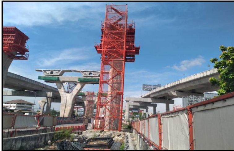
MLP02-27L งานผูกเหล็กเสริม Crossbeam Interface Type PT-44A
