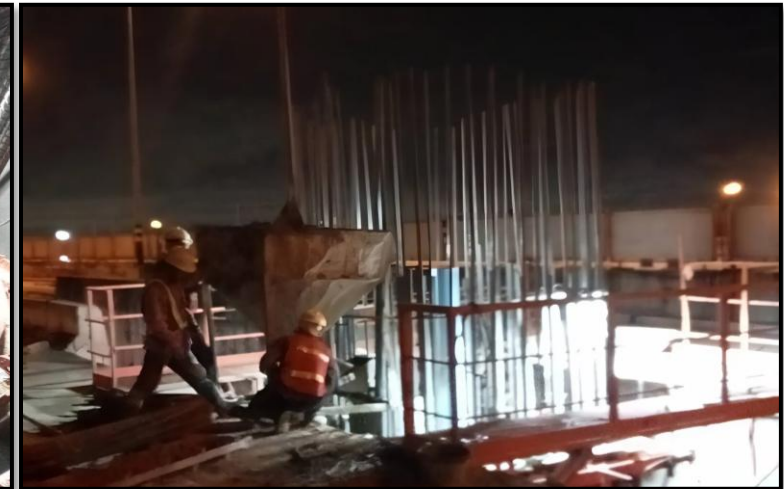
MLP03-06C งานเทคอนกรีต Column Type PT-44 (Modified) Step 1-2
