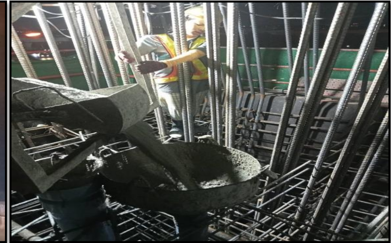
MLP03-08C งานเทคอนกรีต Column Head Type PT-44 (Modified)
