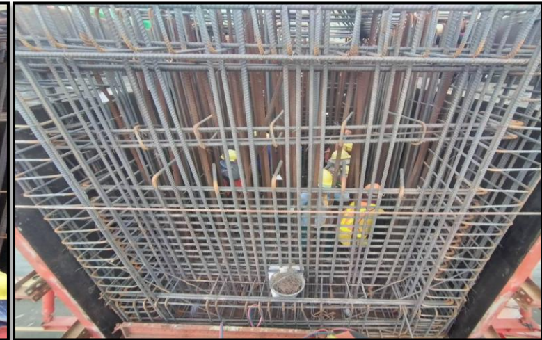
MLP03-05C งานผูกเหล็กเสริม Crossbeam Interface Type PT-44 (Modified)
