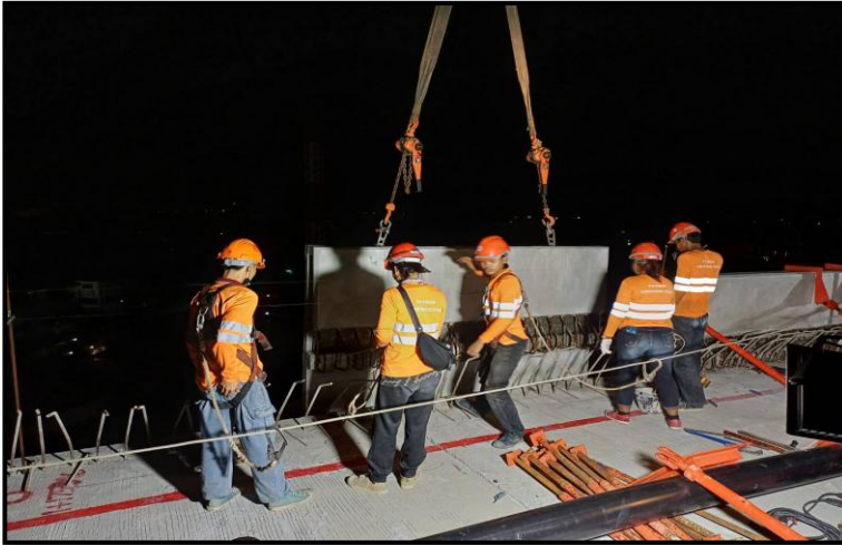
MLP01-07 to MLP01-09 งานติดตั้ง Parapet
