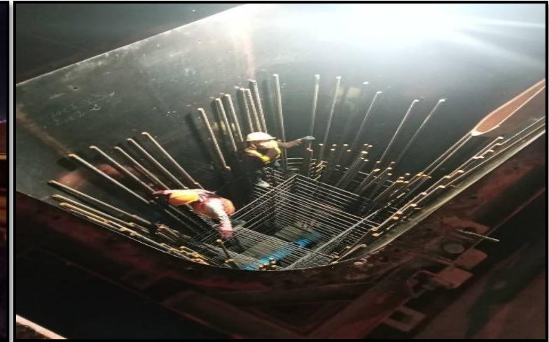
MLP03-06C งานผูกเหล็กเสริม Column Type PT-44 (Modified) Step 1-2
