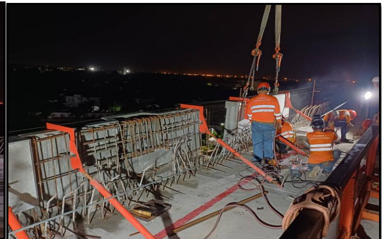
MLP01-09 to MLP01-11 งานติดตั้ง Parapet
