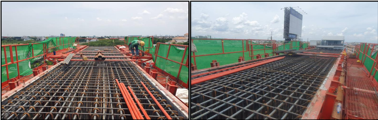
MLP03-25 งานผูกเหล็กเสริม Crossbeam Type YI-2
