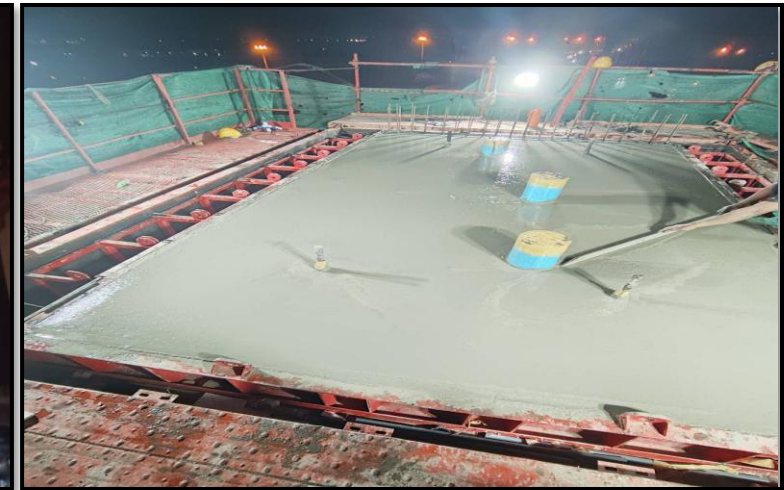
MLP03-03C งานเทคอนกรีต Crossbeam Interface Type PT-44A
