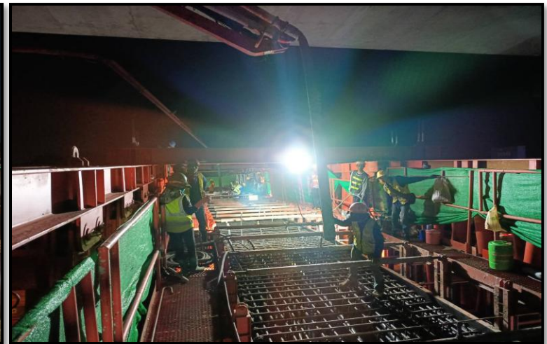
MLP01-08 งานเทคอนกรีต Lower Crossbeam Type PTT-1
