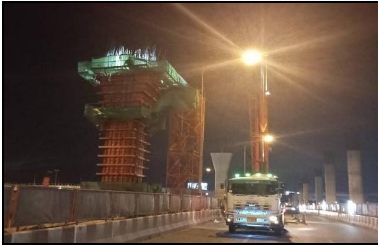
MLP03-08C งานเทคอนกรีต Column Head Type PT-44 (Modified)
