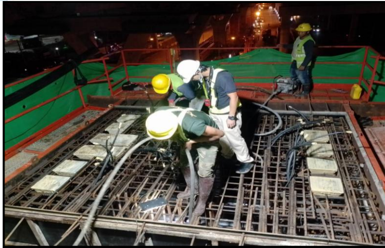
MLP02-27L งานเทคอนกรีต Crossbeam Interface Type PT-44A
