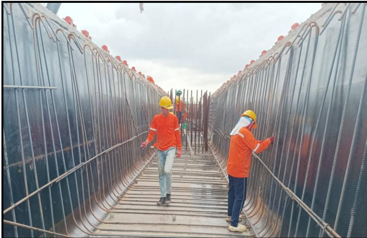
MLP03-23 งานผูกเหล็กเสริมล่าง Crossbeam Type IYI-4
