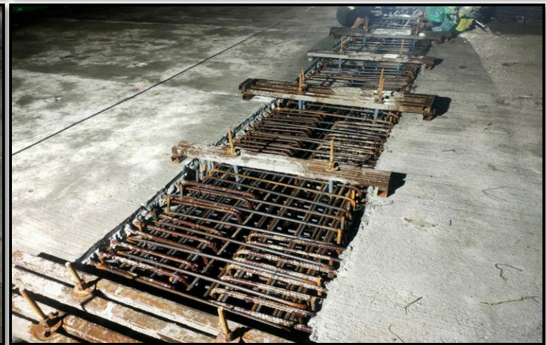
MLP04-04to MLP04-06 งานผูกเหล็กเสริม Connecting Slab
