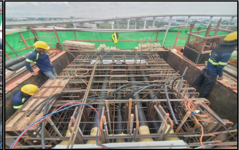
MLP03-03L งานผูกเหล็กเสริม Crossbeam Interface Type PT-44A
