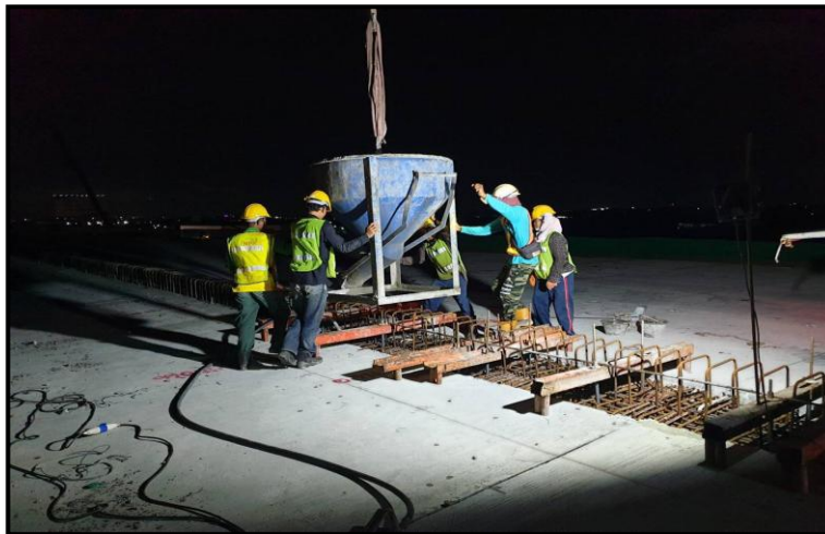
MLP01-16 to MLP01-17 งานเทคอนกรีต Connecting Slab
