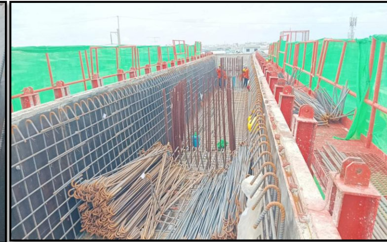
MLP03-23 งานผูกเหล็กเสริมล่าง Crossbeam Type IYI-4
