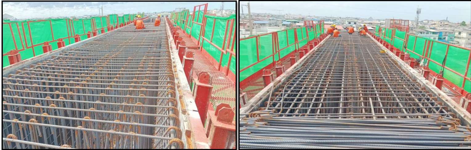
MLP03-23 งานผูกเหล็กบนเสริม Crossbeam Type IYI-4
