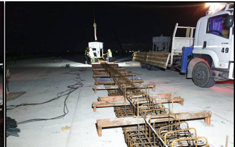
MLP01-16 to MLP01-17 งานเทคอนกรีต Connecting Slab
