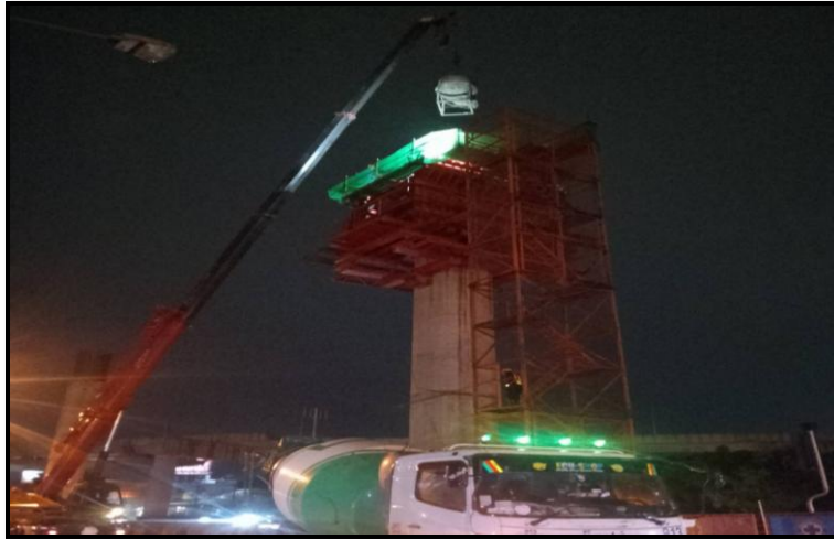
MLP03-03L งานเทคอนกรีต Crossbeam Interface Type PT-44A
