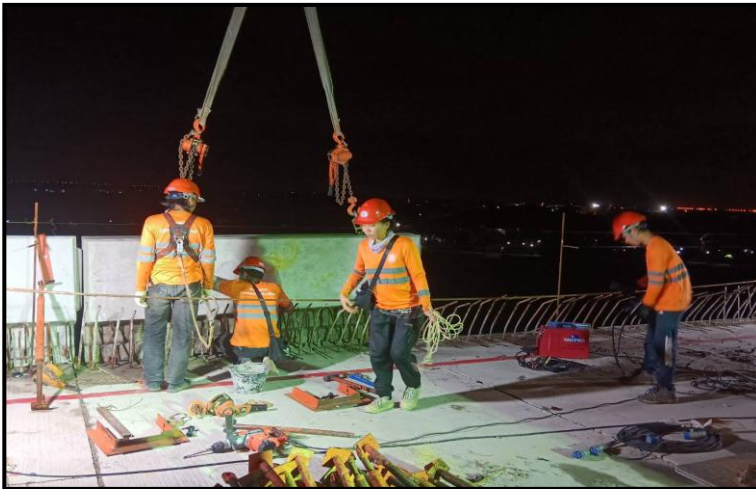
MLP01-09 to MLP01-11 งานติดตั้ง Parapet
