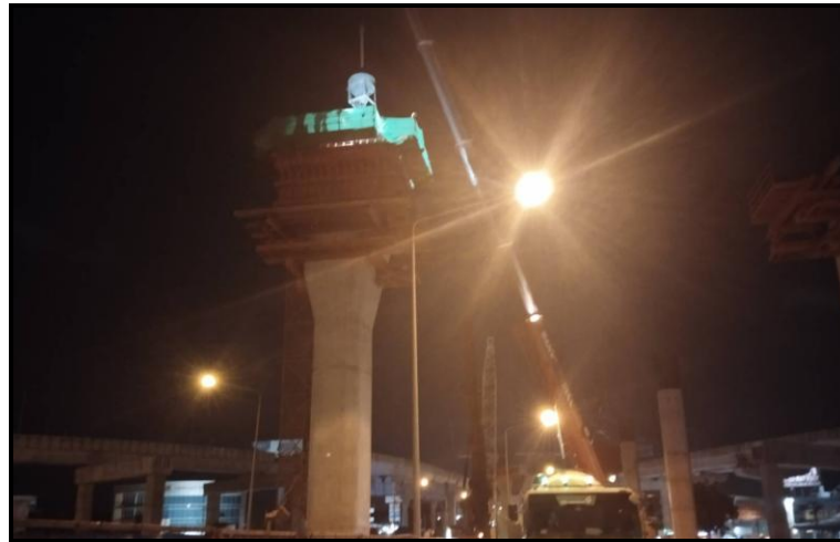
MLP03-03C งานเทคอนกรีต Crossbeam Interface Type PT-44A
