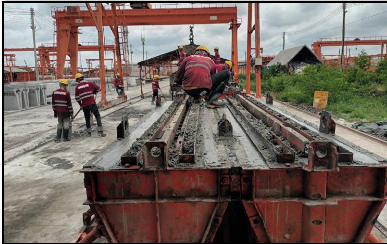
งานหล่อ Precast Central Barrier Zone 1-2 ที่โรงหล่อสระบุรี
