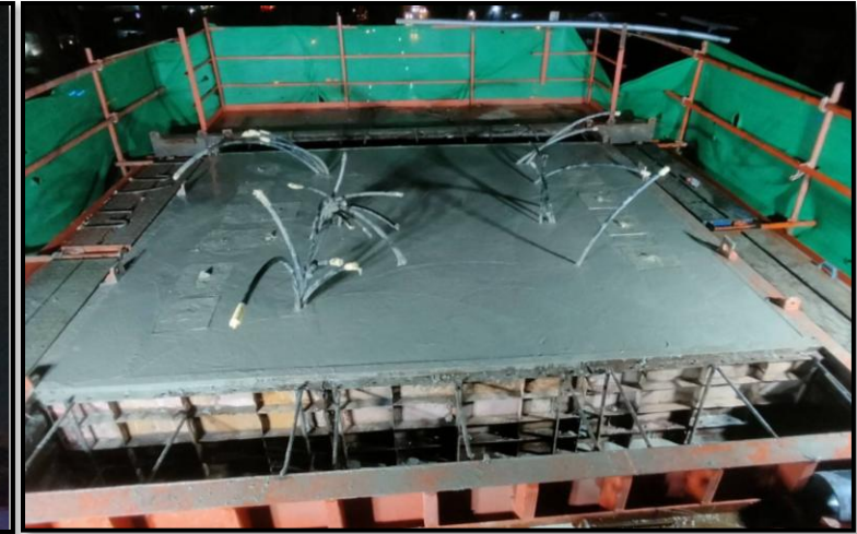
MLP03-03L งานเทคอนกรีต Crossbeam Interface Type PT-44A
