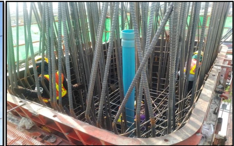
MLP03-08C งานผูกเหล็กเสริม Column Head Type PT-44 (Modified)
