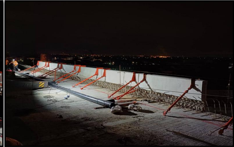
MLP01-07 to MLP01-09 งานติดตั้ง Parapet
