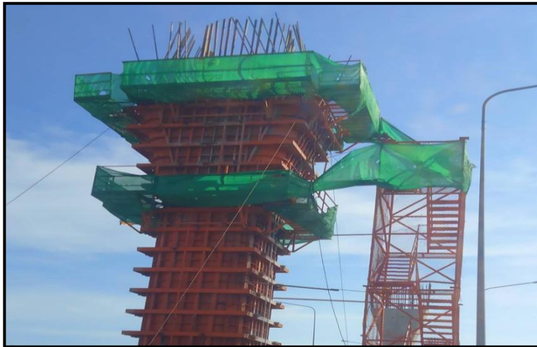
MLP03-08C งานผูกเหล็กเสริม Column Head Type PT-44 (Modified)
