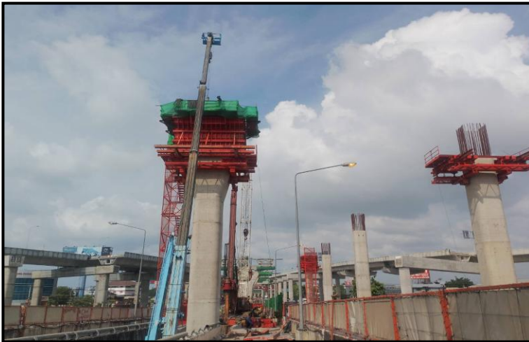
MLP03-03C งานผูกเหล็กเสริม Crossbeam Interface Type PT-44A
