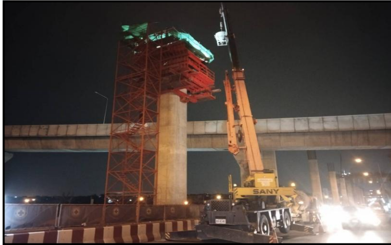
MLP03-12L งานเทคอนกรีต Crossbeam Interface Type PT-44 (Modified)
