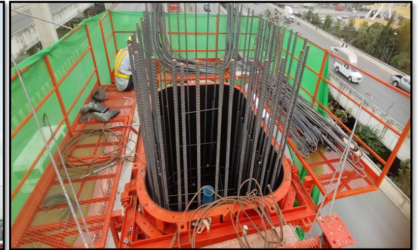
MLP03-04C งานผูกเหล็กเสริม Column Type PT-44A Step 3-4
