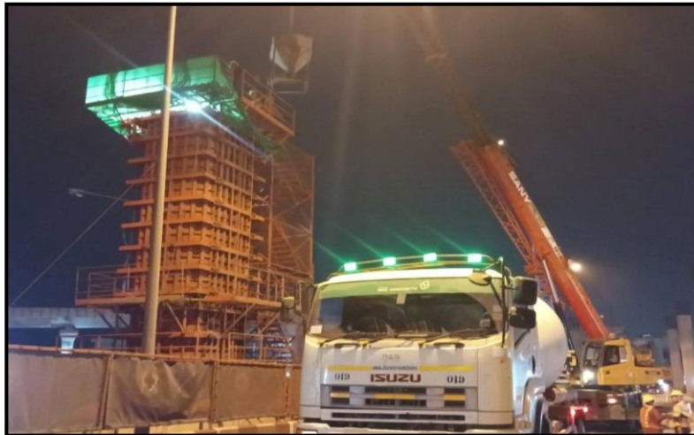
MLP03-04C งานเทคอนกรีต Column Type PT-44A Step 3-4
