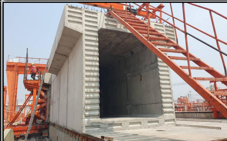
งานหล่อ Precast Crossbeam Type PT-44 ที่โรงหล่อสระบุรี
