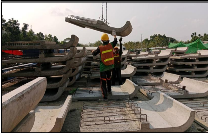
งานหล่อ Precast Parapet Zone 3
