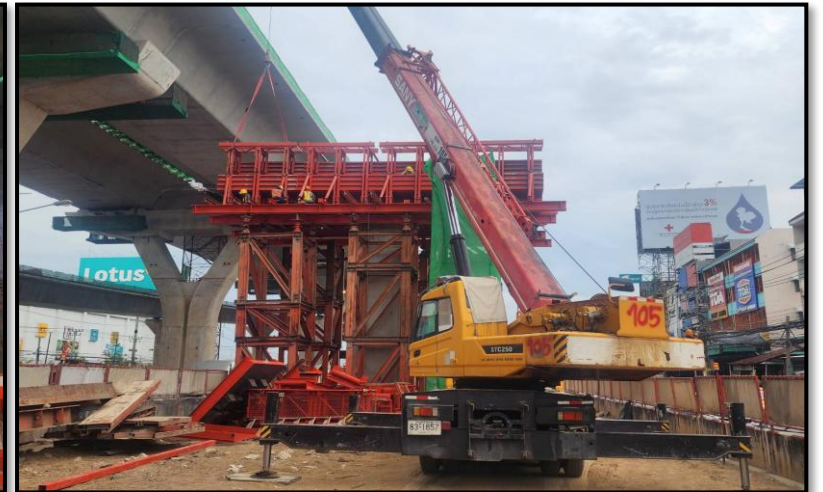
ROF2-08 งานติดตั้ง Formwork Crosshead Type P2
