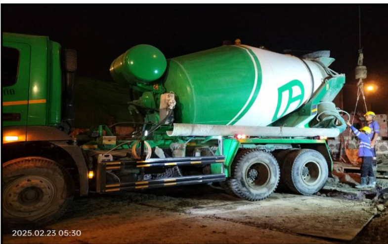
MLP03-02/4C งานเทคอนกรีต Bored Pile 1.80 m.
