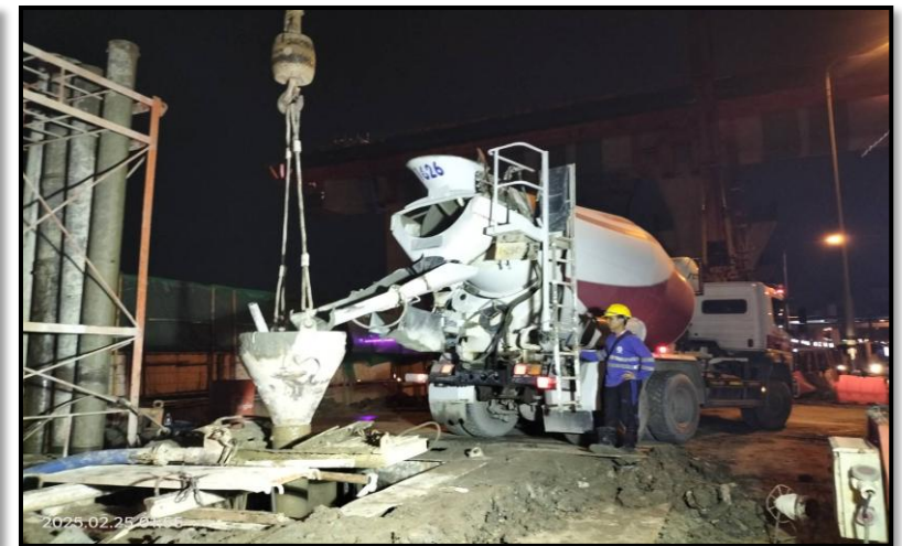
MLP03-16/1C งานเทคอนกรีต Bored Pile 1.80 m.
