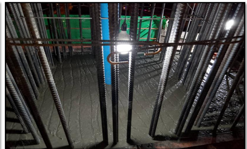
MLP03-05C งานเทคอนกรีต Column Head Type PT-44 (Modified)
