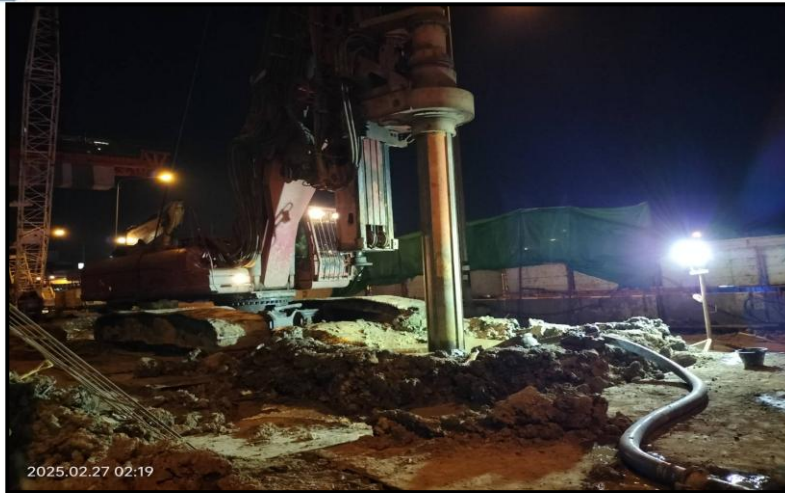
MLP03-15/3C งานเจาะ Bored Pile 1.80 m.
