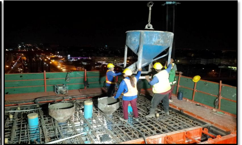
MLP03-12C งานเทคอนกรีต Crossbeam Interface Type PT-44(Modified)
