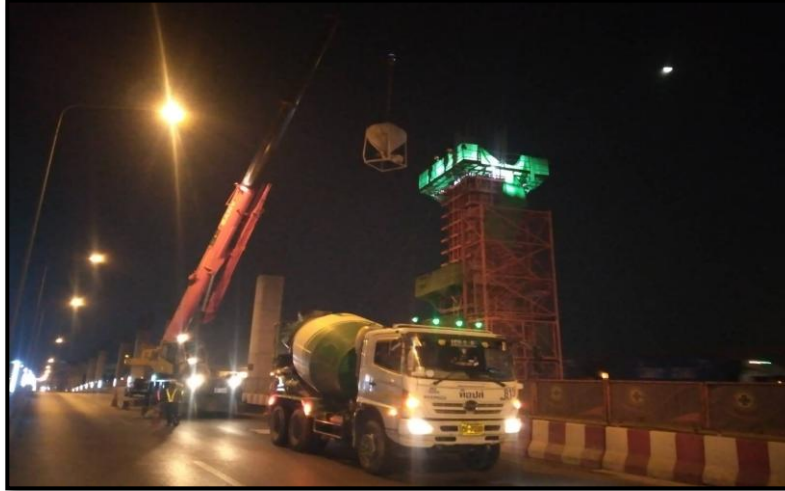
MLP03-09L งานเทคอนกรีต Column Type PT-44(Modified) Step 4-5
