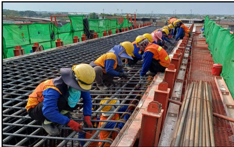
MLP01-19 งานผูกเหล็กเสริม Crossbeam Type Y-1
