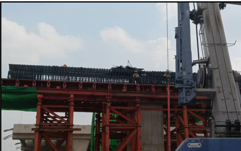
ROF2-10 งานผูกเหล็กเสริม Crosshead Type P-2
