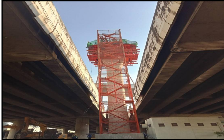
MLP03-12C งานผูกเหล็กเสริม Crossbeam Interface Type PT-44(Modified)
