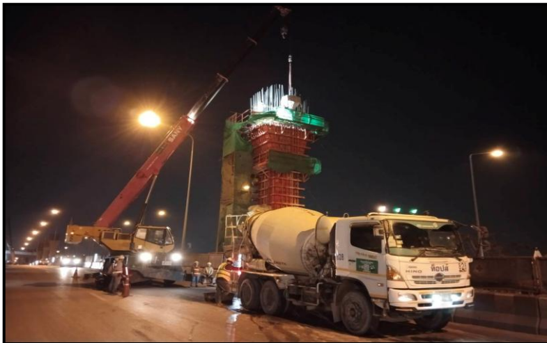
MLP03-05C งานเทคอนกรีต Column Head Type PT-44 (Modified)
