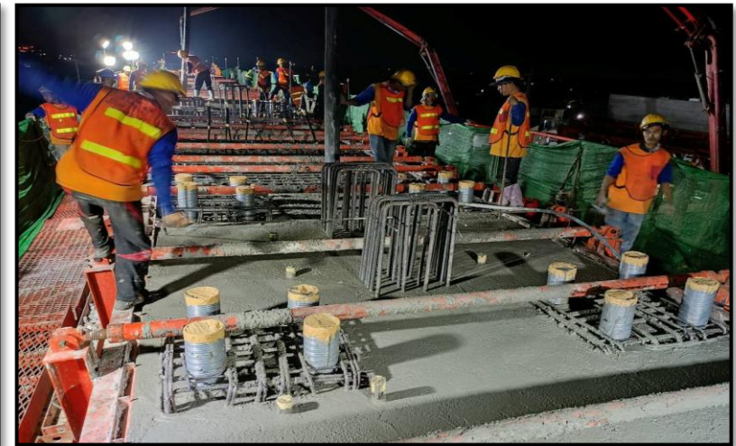
MLP02-17 งานเทคอนกรีต Crossbeam Type IYI-1
