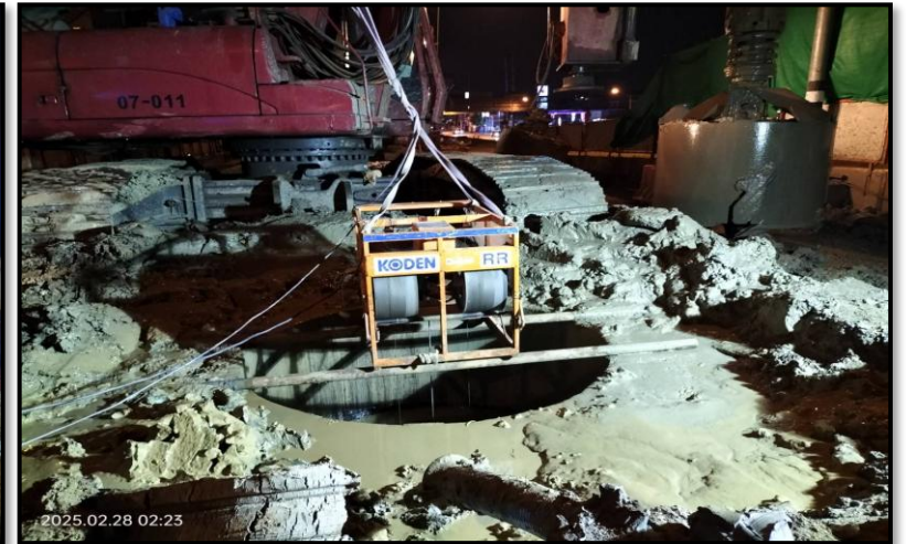
MLP03-15/3C งานเจาะ Bored Pile 1.80 m.
