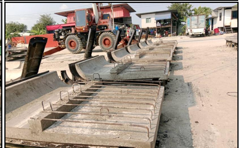
งานหล่อ Precast Parapet Zone 3
