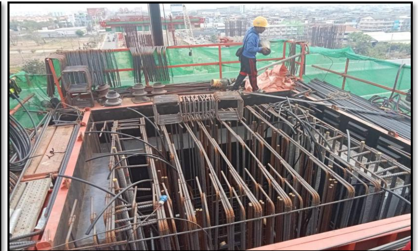
MLP03-12L งานผูกเหล็กเสริม Crossbeam Interface Type PT-44(Modified)
