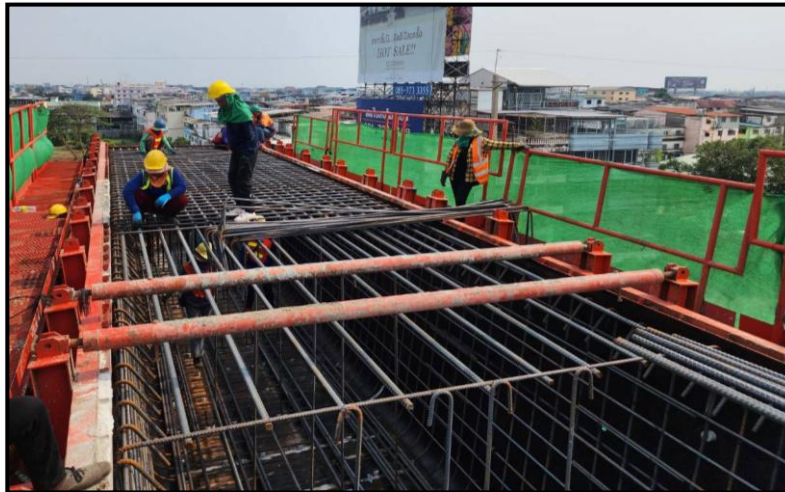
MLP03-26 งานผูกเหล็กเสริม Crossbeam Type YI-2
