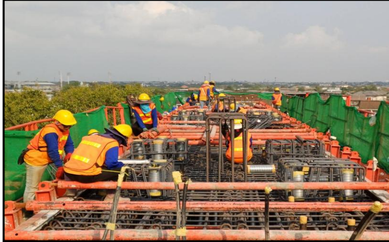
MLP02-18 งานผูกเหล็กเสริม Crossbeam Type IYI-4
