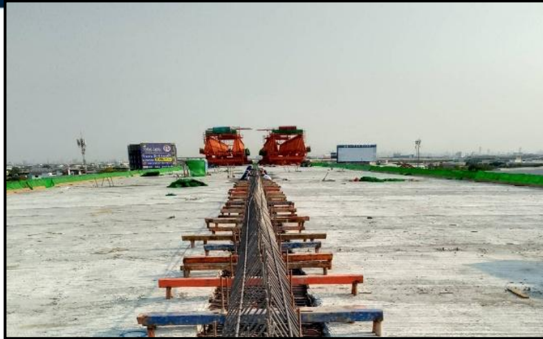
MLP02-07 to MLP02-09 งานผูกเหล็ก Connecting Slab
