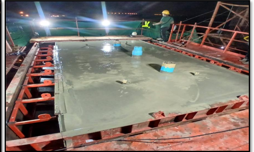
MLP03-11C งานเทคอนกรีต Crossbeam Interface Type PT-44 (Modified)
