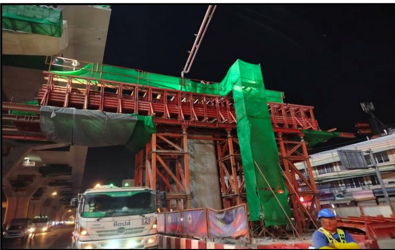
ROF2-10 งานเทคอนกรีต Cross Head Type P-2
