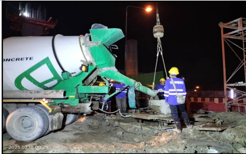
MLP03-15/2C งานเทคอนกรีต Bored Pile 1.80 m.
