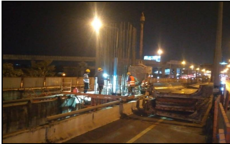
MLP03-05C งานเทคอนกรีต Column Type PT-44(Modified) Step 1-2
