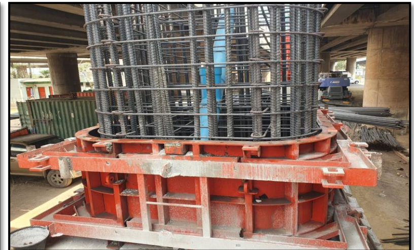
MLP03-04C งานผูกเหล็กเสริม Column Type PT-44A Step 1-2
