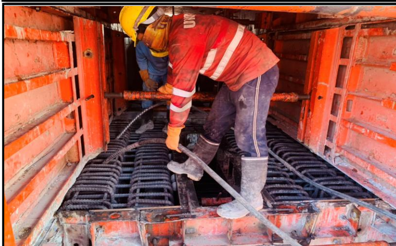
งานหล่อ Precast Crossbeam Type PT-44 ที่โรงหล่อสระบุรี
