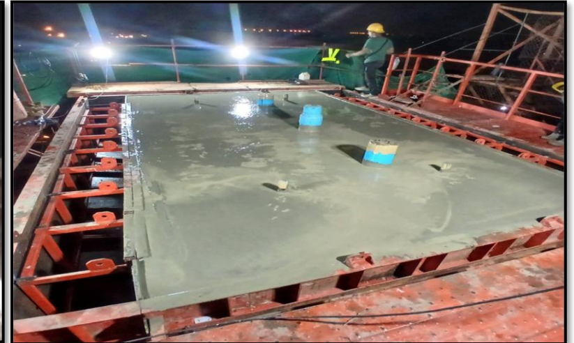
MLP03-12L งานเทคอนกรีต Crossbeam Interface Type PT-44 (Modified)
