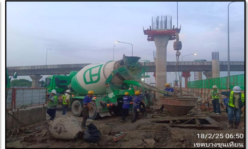
MLP03-15/2C งานเทคอนกรีต Bored Pile 1.80 m.
