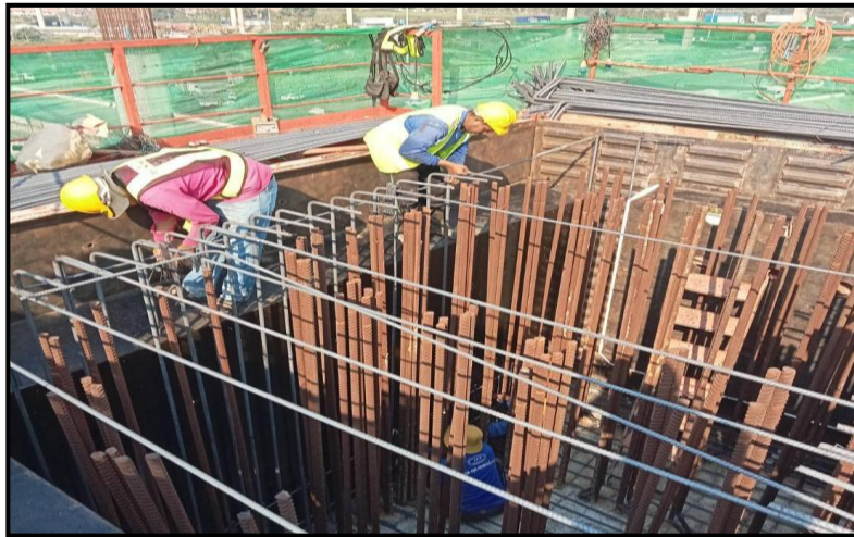
MLP03-11L งานผูกเหล็กเสริม Crossbeam Interface Type PT-44 (Modified)
