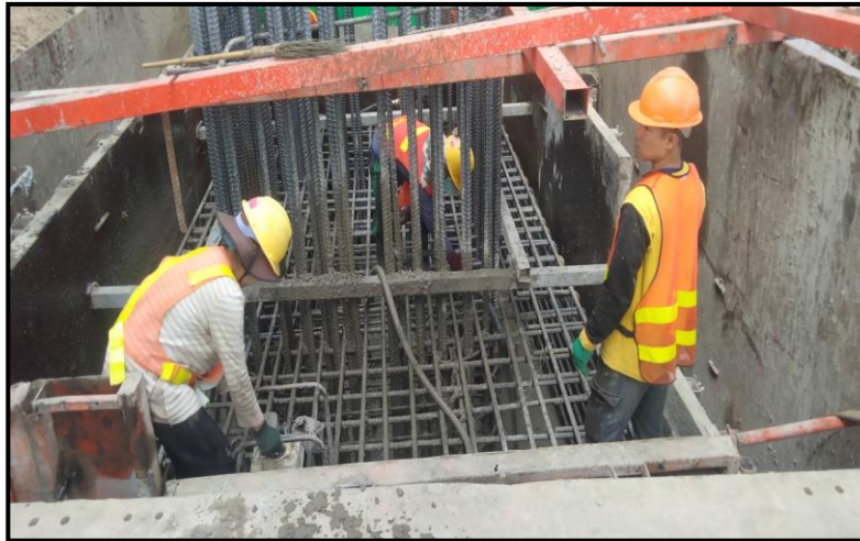
MLP03-09C งานเทคอนกรีต Footing
