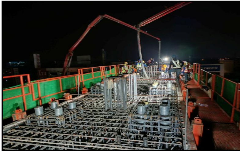
MLP01-28 งานเทคอนกรีต Crossbeam Type IYI-4
