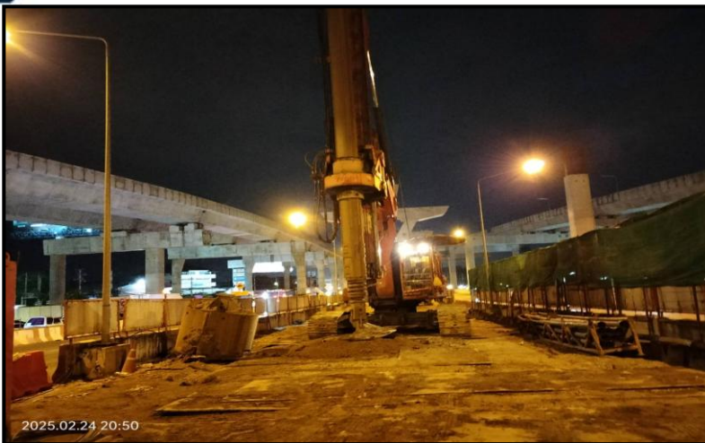
MLP03-01/4C งานเจาะ Bored Pile 1.80 m.
