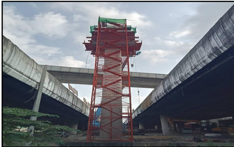
MLP03-12L งานผูกเหล็กเสริม Crossbeam Interface Type PT-44(Modified)
