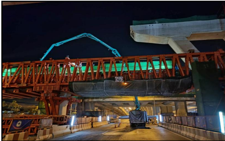
MLP01-03 งานเทคอนกรีต Lower Crossbeam Type YT-1
