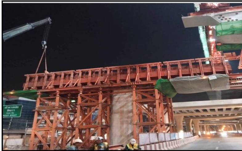
ROF2-10 งานติดตั้ง Formwork Croshead Type P-2
