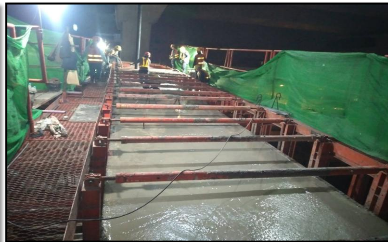
ROF2-10 งานเทคอนกรีต Cross Head Type P-2
