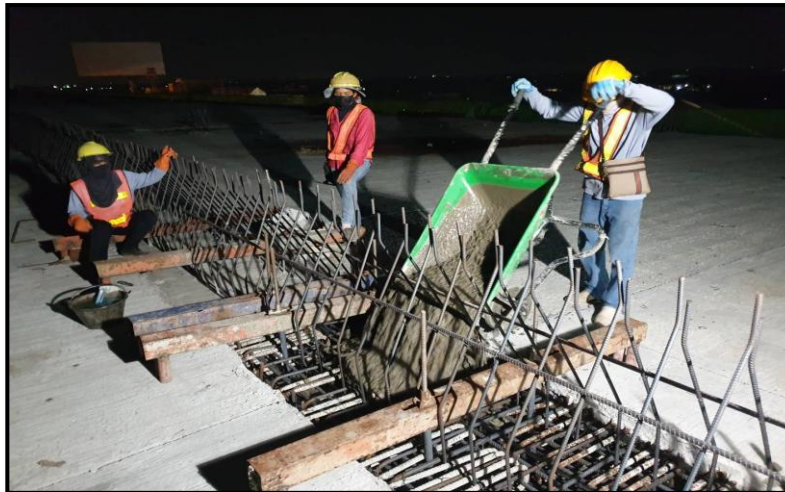
MLP02-08 to MLP02-10 งานเทคอนกรีต Connecting Slab
