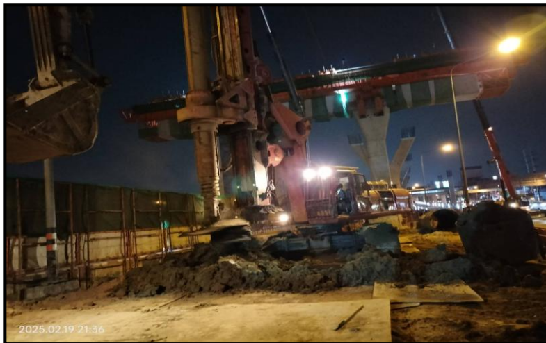
MLP03-16/1C งานเจาะ Bored Pile 1.80 m.
