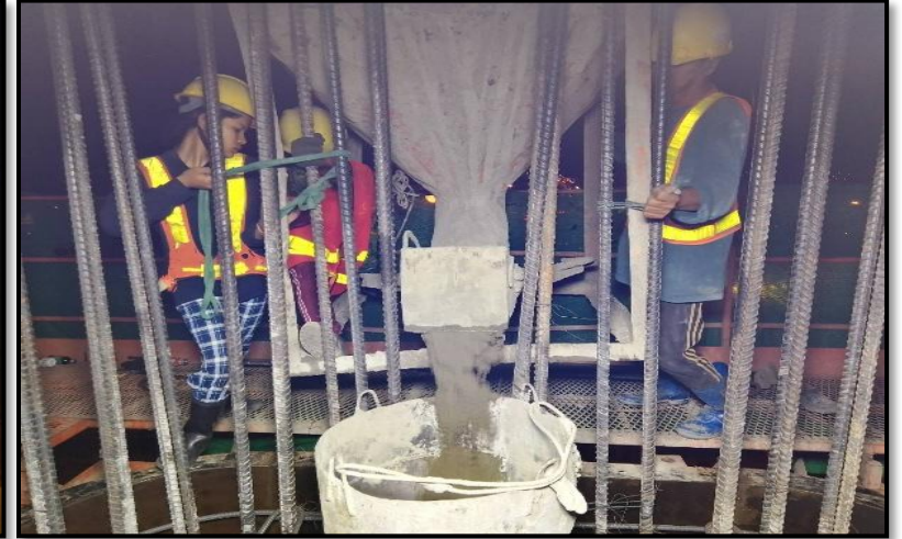
MLP03-09L งานเทคอนกรีต Column Type PT-44(Modified) Step 4-5
