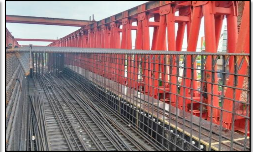
MLP01-06 งานผูกเหล็กเสริม Lower Crossbeam Type PTT-1
