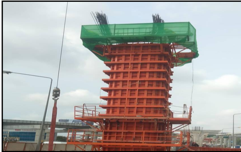
MLP03-04C งานผูกเหล็กเสริม Column Type PT-44A Step 3-4
