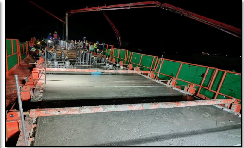
MLP01-28 งานเทคอนกรีต Crossbeam Type IYI-4
