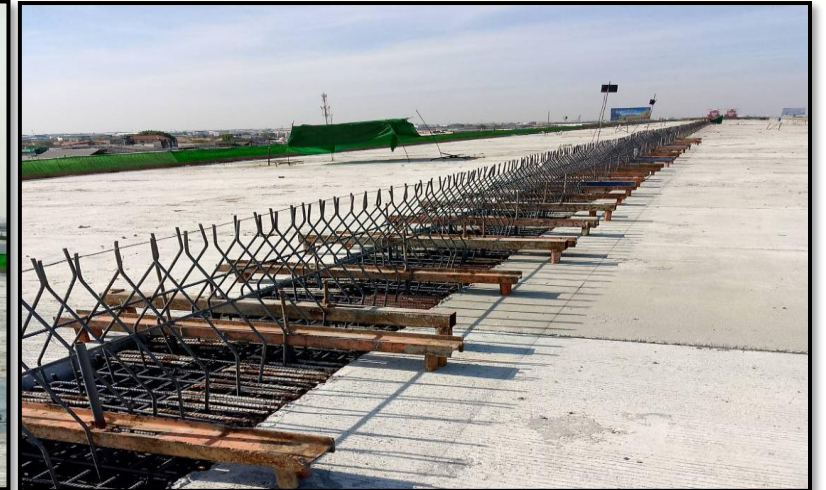
MLP02-07 to MLP02-09 งานผูกเหล็ก Connecting Slab
