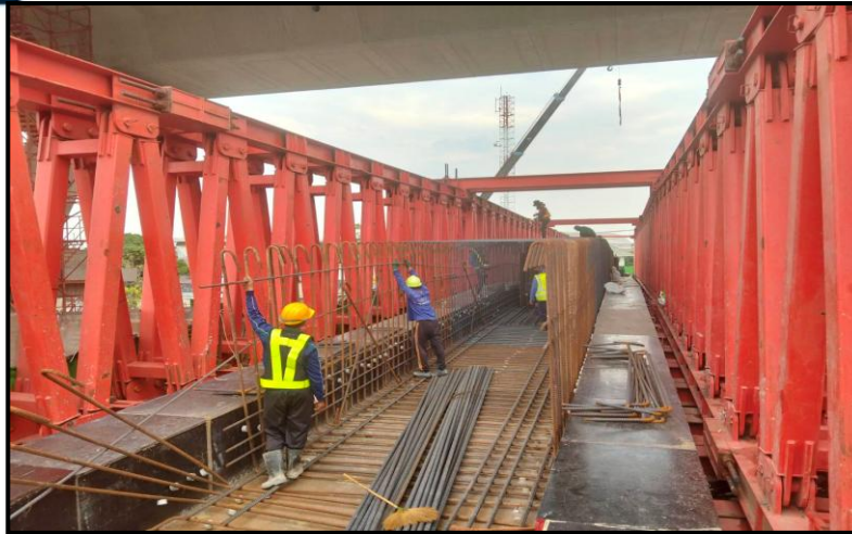
MLP01-06 งานผูกเหล็กเสริม Lower Crossbeam Type PTT-1
