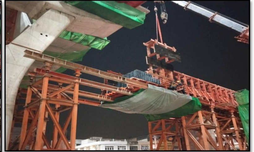
ROF2-10 งานติดตั้ง Formwork Croshead Type P-2
