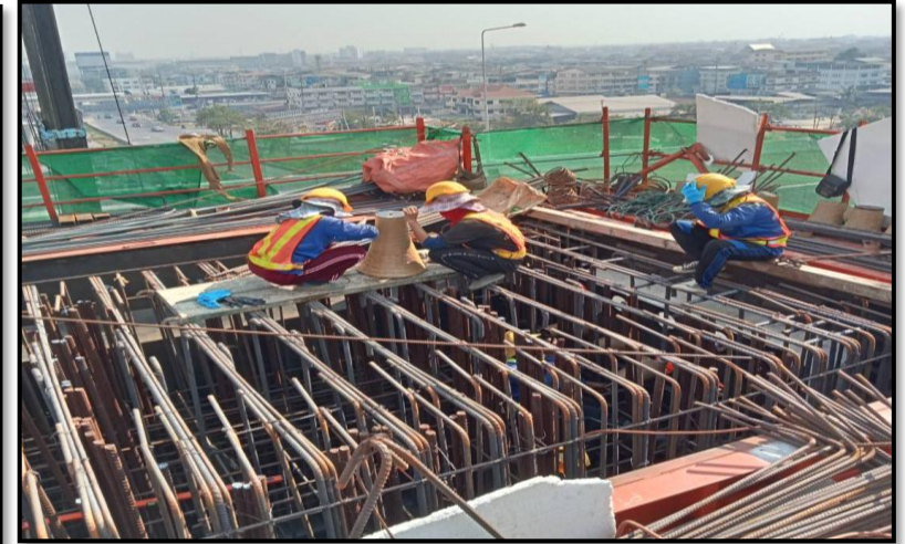
MLP03-12C งานผูกเหล็กเสริม Crossbeam Interface Type PT-44(Modified)
