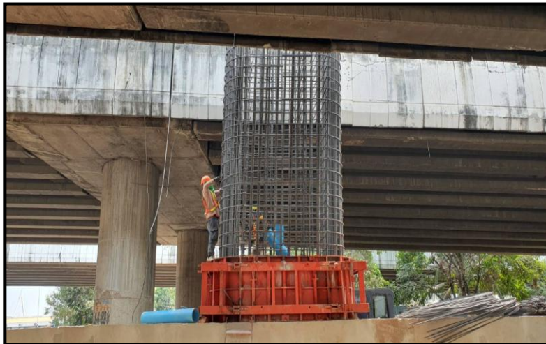
MLP03-05C งานผูกเหล็กเสริม Column Type PT-44 (Modified) Step 1-2
