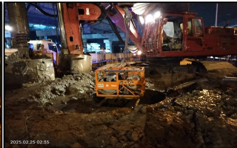
MLP03-01/4C งานเจาะ Bored Pile 1.80 m.
