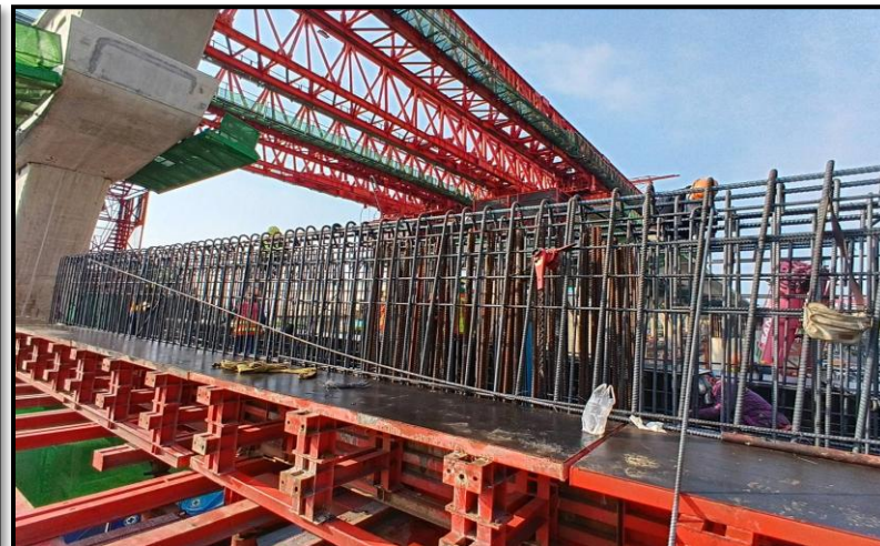
ROF2-10 งานผูกเหล็กเสริม Crosshead Type P-2
