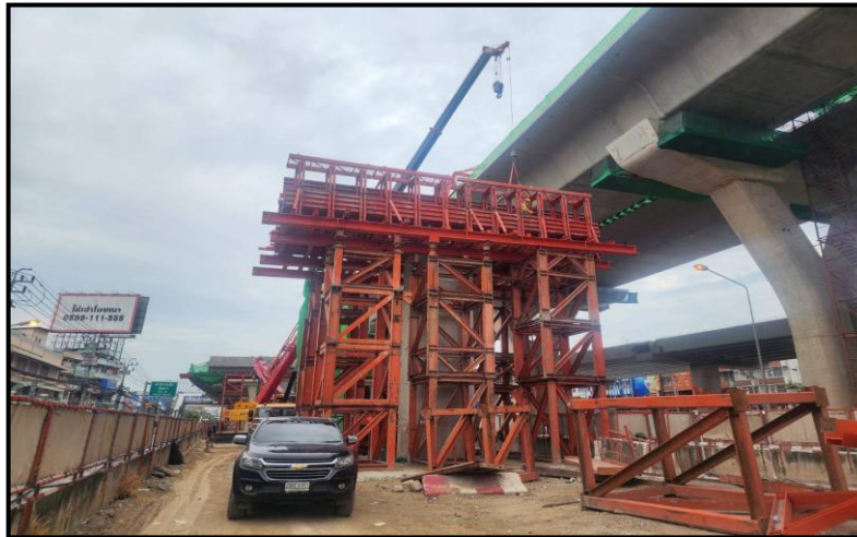
ROF2-08 งานติดตั้ง Formwork Crosshead Type P2
