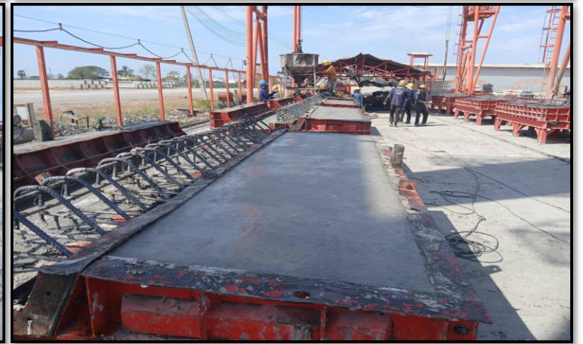
งานหล่อ Parapet Zone1-2 ที่โรงหล่อสระบุรี
