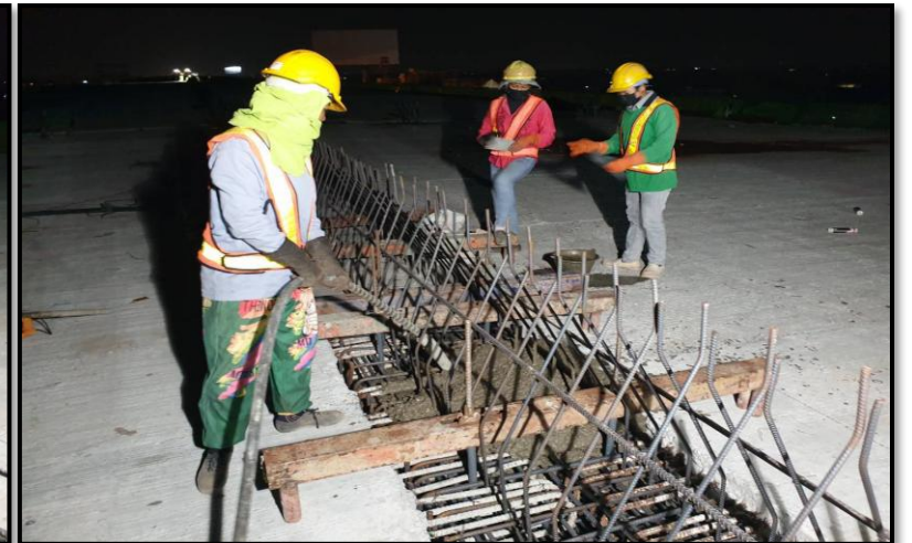
MLP02-08 to MLP02-10 งานเทคอนกรีต Connecting Slab
