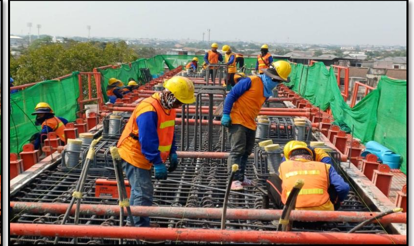
MLP02-18 งานผูกเหล็กเสริม Crossbeam Type IYI-4
