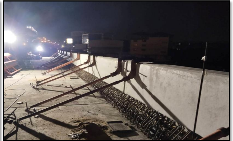
RON1-21 to RON1-22 งานติดตั้ง Parapet
