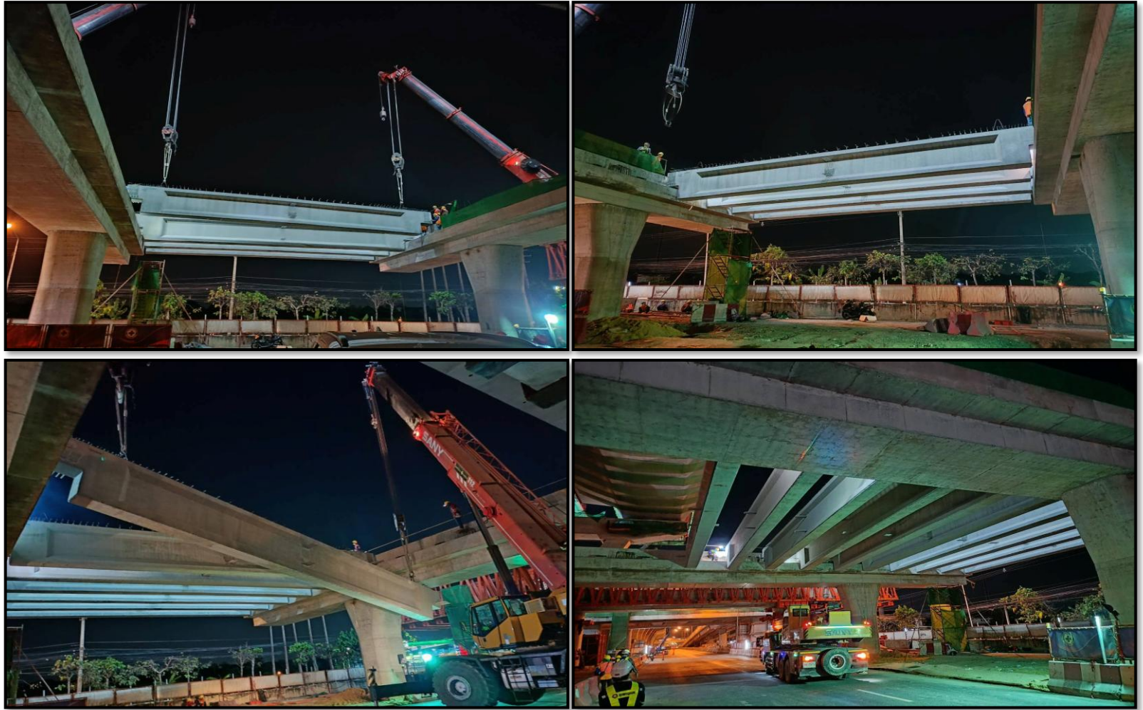
MLP01-04 to MLP01-05 งานติดตั้ง I-Girder
