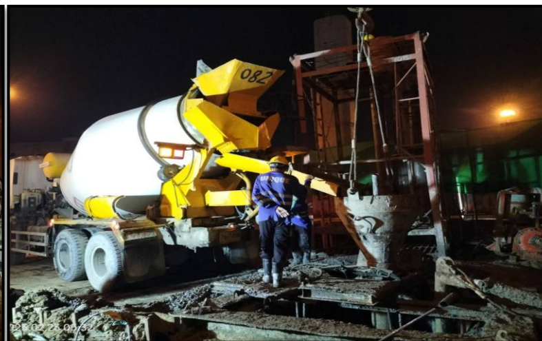
MLP03-02/4C งานเทคอนกรีต Bored Pile 1.80 m.
