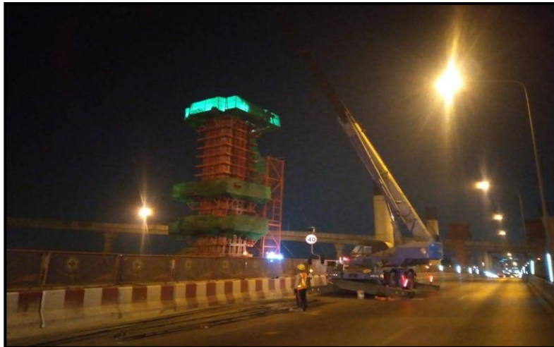
MLP03-09L งานผูกเหล็กเสริม Column Type PT-44(Modified) Step 4-5
