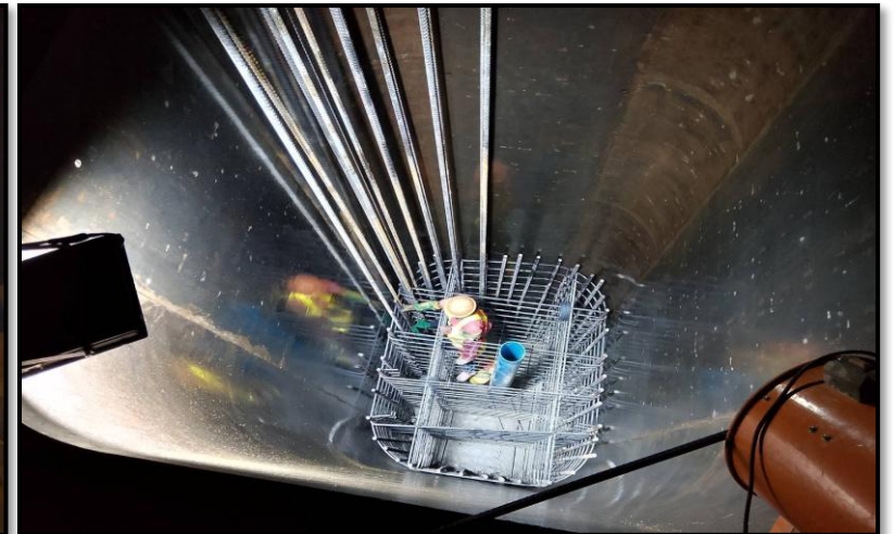
MLP03-09L งานผูกเหล็กเสริม Column Type PT-44(Modified) Step 4-5
