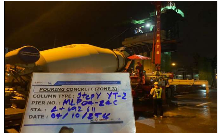
Pouring Concrete Column Pier Type YT-2 Step Y MLP04-24C
