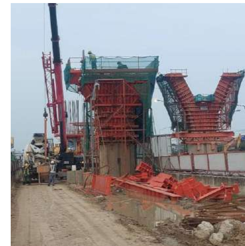
RON1-22 งานเทคอนกรีต Column Type S5 Step2
