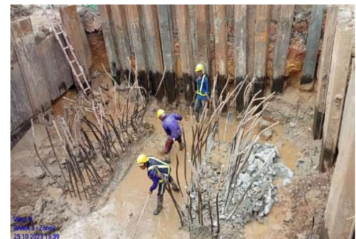
MLP03-27/R งาน Pile Cut Off Footing
