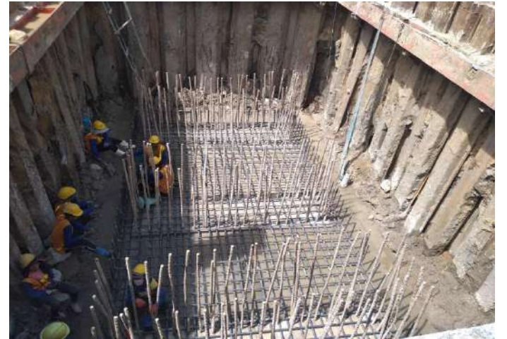
MLP04-01/C งานติดตั้งเหล็กเสริม Footing
