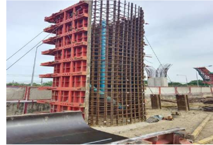
ROF1-08 งานติดตั้งเหล็กเสริม Column Type S5 Step1
