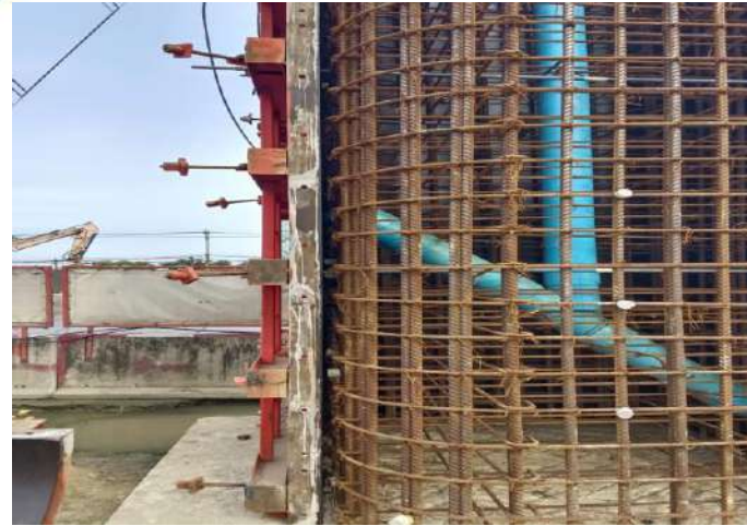
ROF1-08 งานติดตั้งเหล็กเสริม Column Type S5 Step1
