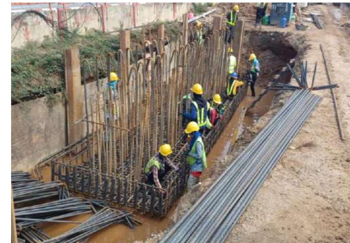
MLP01-28R งานติดตั้งเหล็กเสริม Footing
