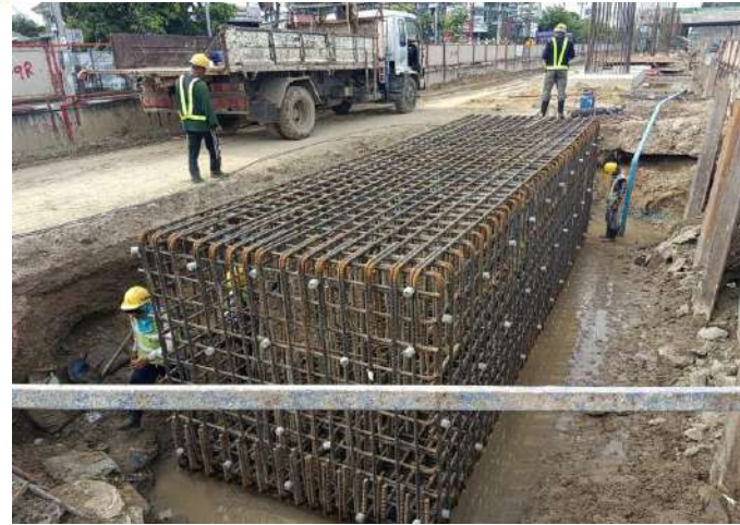
MLP01-09R งานติดตั้งเหล็กเสริม Footing
