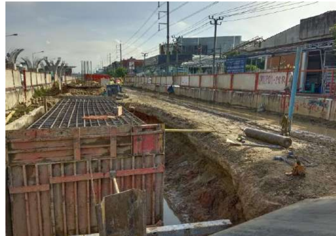
MLP01-18R งานติดตั้ง Formwork Footing
