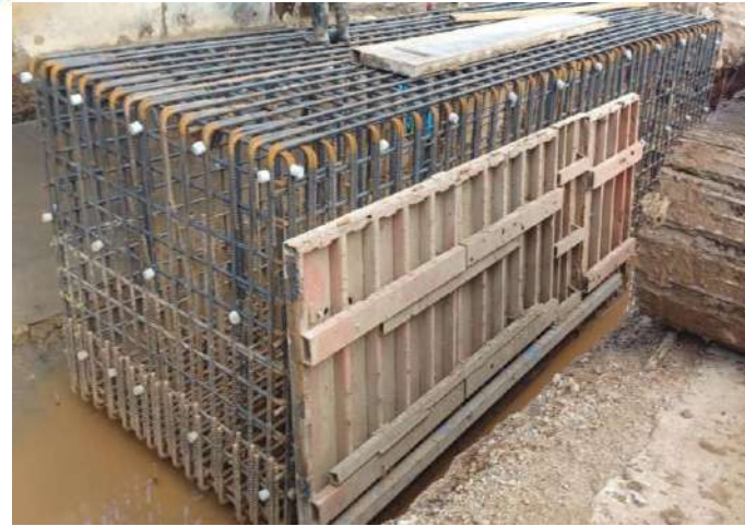
MLP01-29R งานติดตั้ง Formwork Footing
