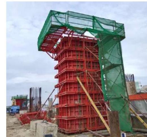
MLP01-12R งานติดตั้ง Formwork Column Type PTT-1 Step1
