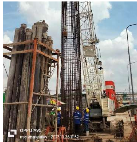
MLP03-17/3C งานติดตั้งเหล็กเสริม Bored Pile
