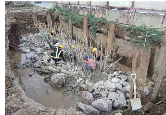
MLP01-28R งาน Pile Cut Off Footing
