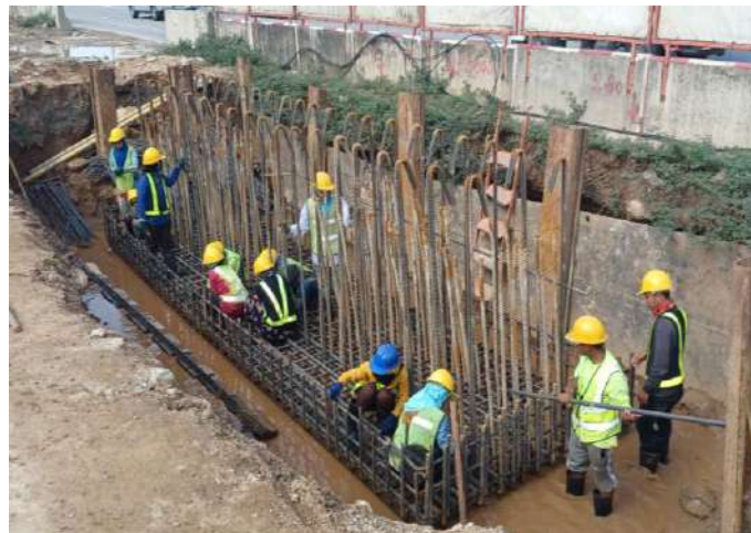
MLP01-28R งานติดตั้งเหล็กเสริม Footing
