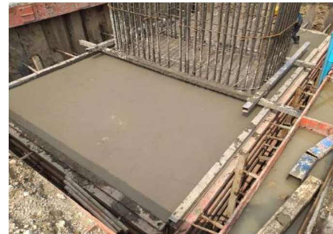
MLP03-28/C งานเทคอนกรีต Footing
