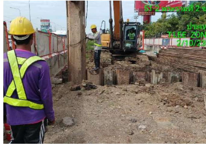
MLP04-06/L งานติดตั้ง Sheet Pile Footing
