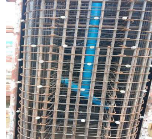
MLP04-03/C งานติดตั้งเหล็กเสริม Column Type IYI-4 Step1
