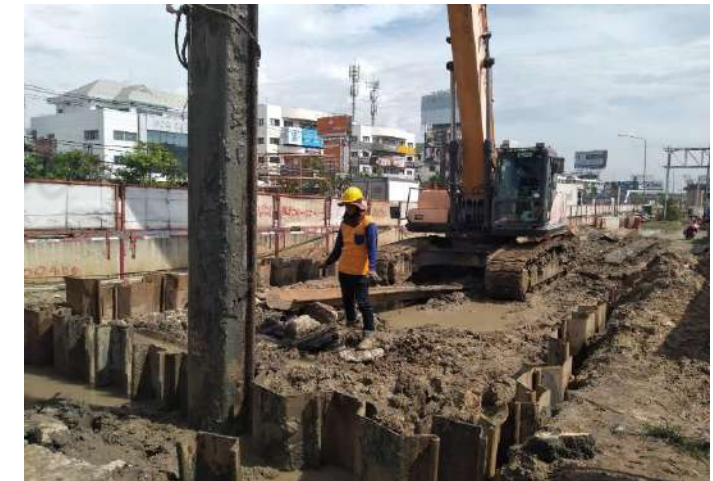
MLP04-07/C งานติดตั้ง Sheet Pile Footing
