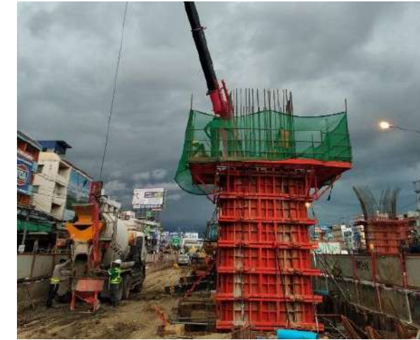
MLP04-14/C งานเทคอนกรีต Column Type Y1 Step 1
