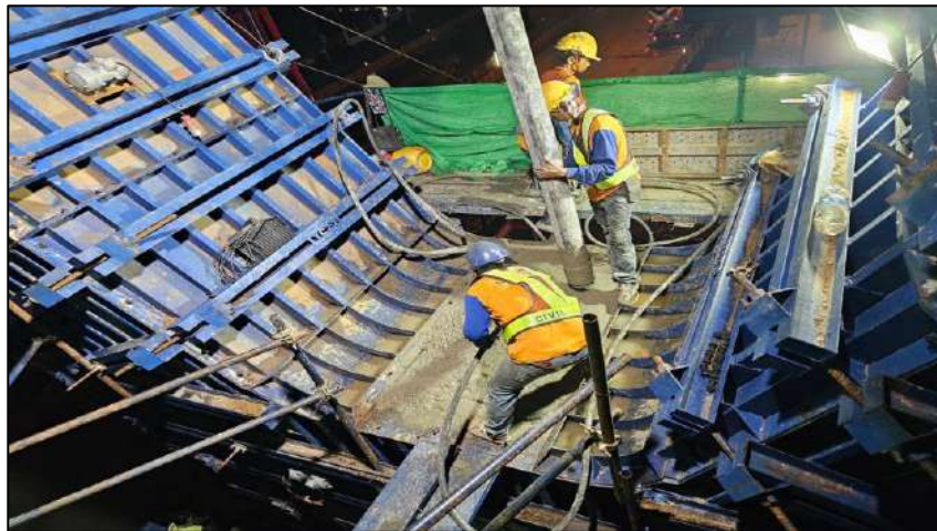
Pouring Concrete Column Pier Type Y-1 Step Y MLP04-33C
