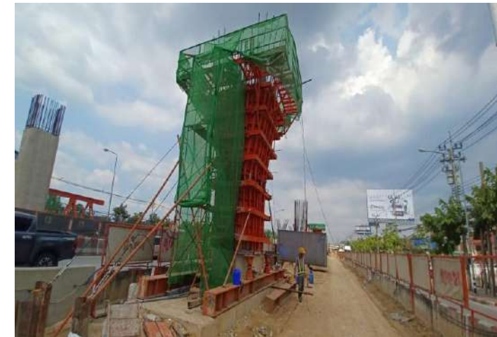
MLP01-12R งานติดตั้งเหล็กเสริม Column Type PTT-1 Step2
