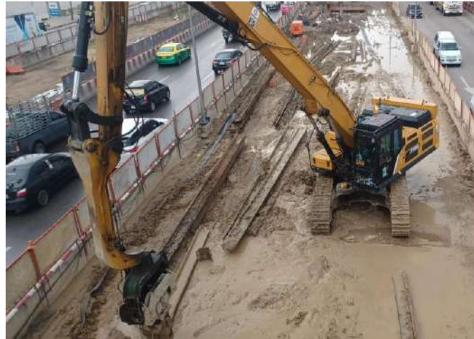
MLP02-18C งานติดตั้ง Sheet Pile Footing
