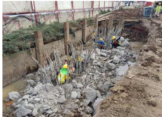
MLP01-28R งาน Pile Cut Off Footing
