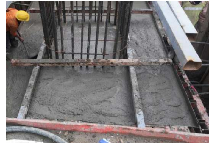
MLP01-05L งานเทคอนกรีต Footing
