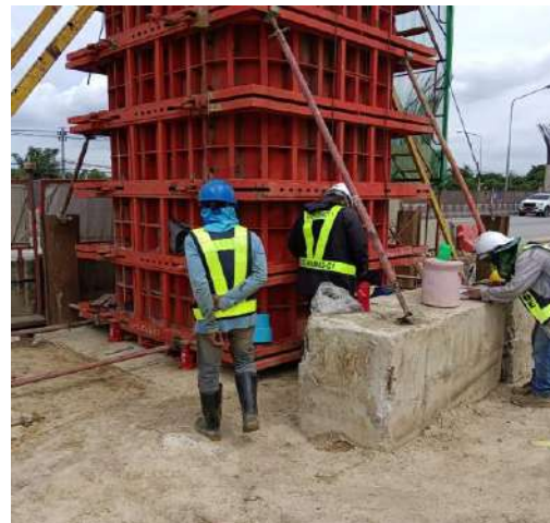
MLP01-12R งานติดตั้ง Formwork Column Type PTT-1 Step1
