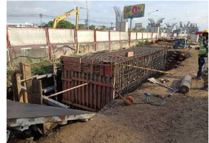
MLP01-18R งานติดตั้ง Formwork Footing
