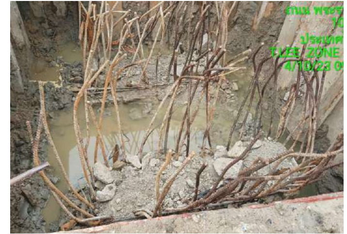
ROF02-02/L งาน Pile Cut Off Footing
