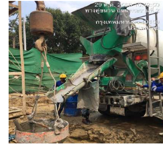
MLP02-17/1L งานเทคอนกรีต Barrette Pile
