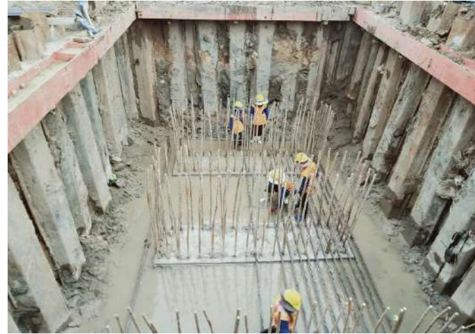
MLP04-07/C งานติดตั้งเหล็กเสริม Footing
