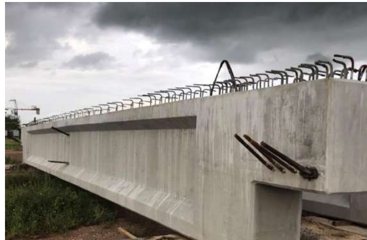
งานผลิตชิ้นงาน Precast Girder
