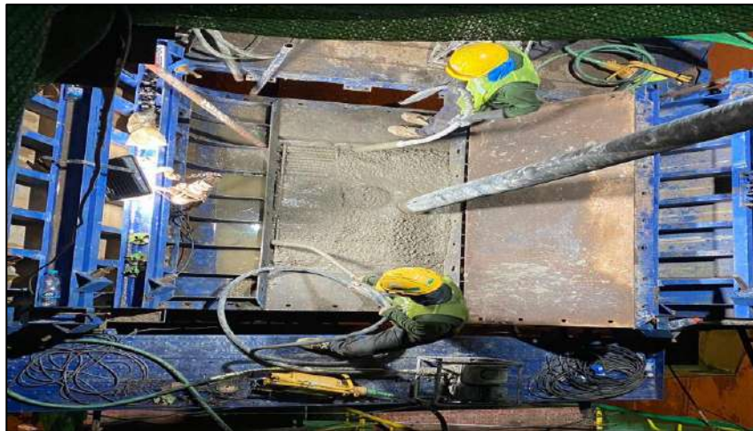
Pouring Concrete Column Pier Type Y-1 Step Y MLP04-31C
