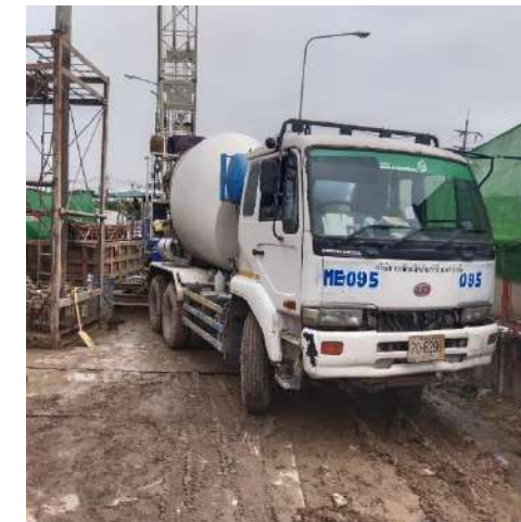
MLP03-17/2C งานเทคอนกรีตเสาเข็ม Bored Pile
