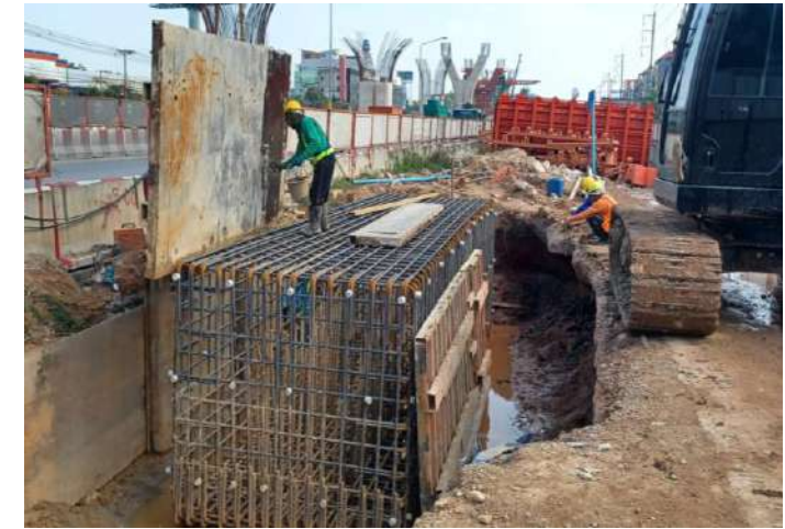
MLP01-29R งานติดตั้ง Formwork Footing
