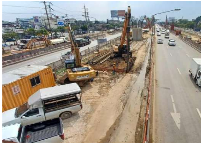
MLP01-26C งานติดตั้ง Sheet Pile Footing
