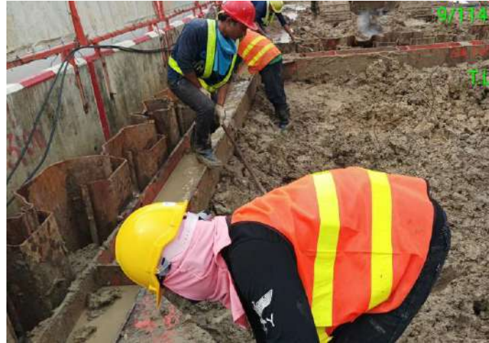
MLP04-06/L งานติดตั้ง Bracing Footing
