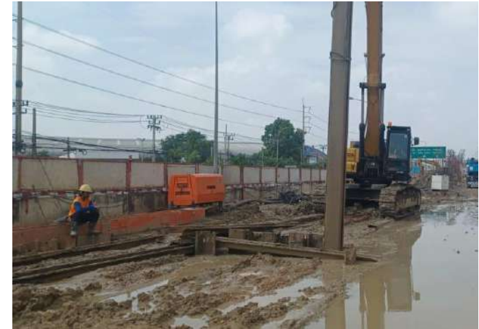
MLP02-18C งานติดตั้ง Sheet Pile Footing
