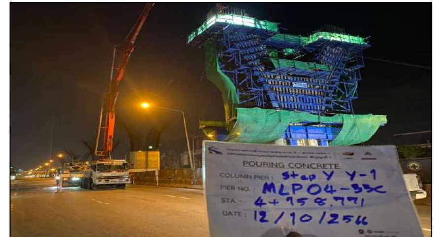
Pouring Concrete Column Pier Type Y-1 Step Y MLP04-33C
