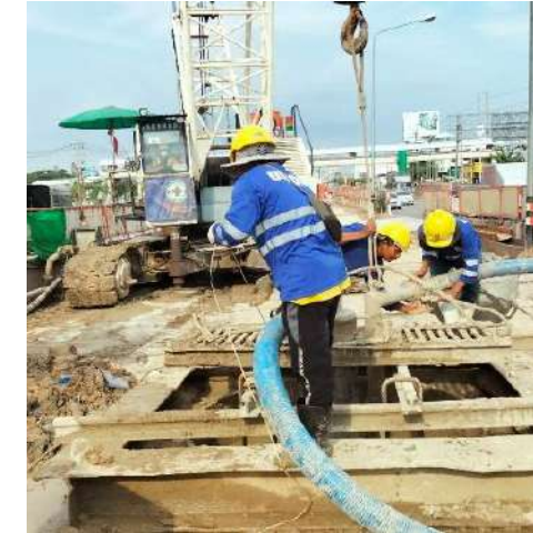
MLP03-17/3C งาน Airlift & Desand Bored Pile
