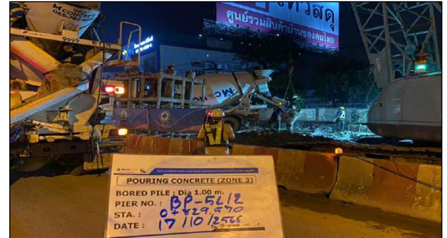
Pouring Concrete Bored Pile Dia 1.00 m. BP-5L/2
