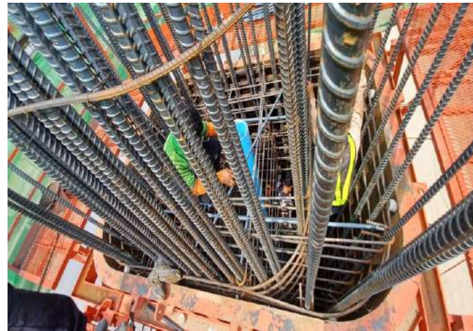
MLP01-12R งานติดตั้งเหล็กเสริม Column Type PTT-1 Step2
