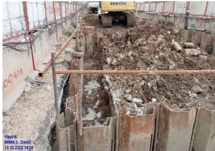
MLP04-07/C งานติดตั้ง Bracing Footing
