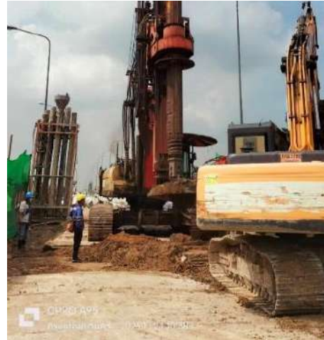
MLP03-17/3C งานเจาะเสาเข็ม Bored Pile
