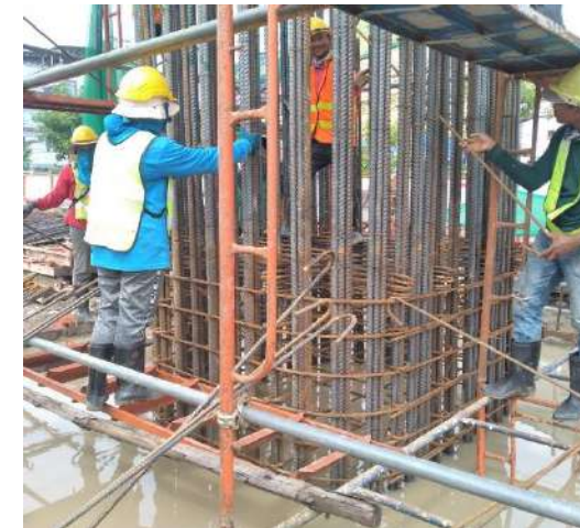
ROF02-03/L งานติดตั้งเหล็กเสริม Column Type S4
