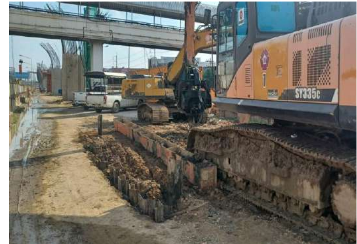
MLP01-26C งานติดตั้ง Sheet Pile Footing
