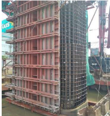
MLP04-03/C งานติดตั้งเหล็กเสริม Column Type IYI-4 Step1
