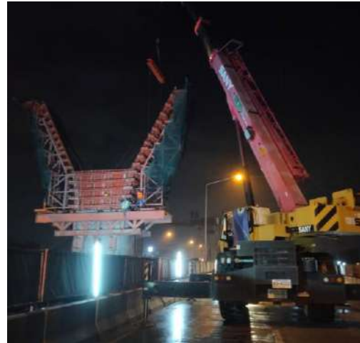
MLP01-18C งานติดตั้ง Formwork Column Type Y1 Step2
