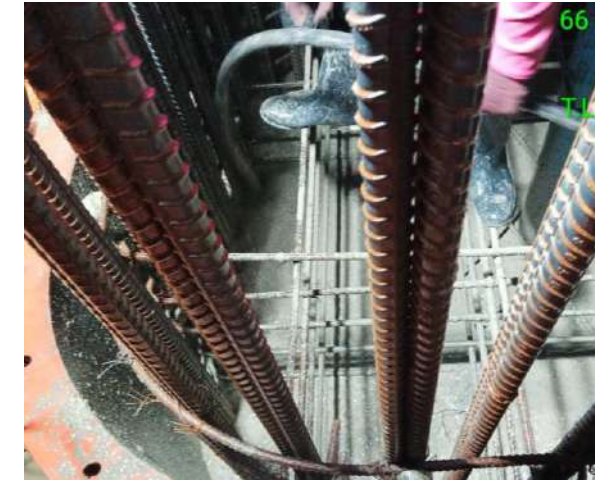
MLP04-11/C งานเทคอนกรีต Column Type Y2 Step 1
