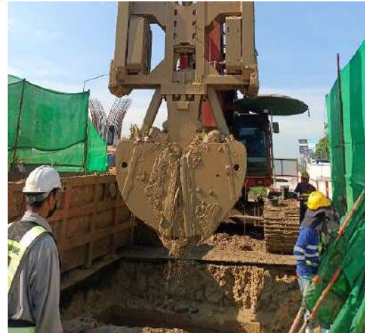
MLP02-13/2L งานเจาะเสาเข็ม Barrette Pile
