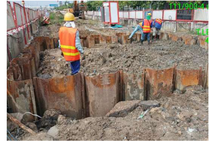
MLP04-06/L งานติดตั้ง Sheet Pile Footing
