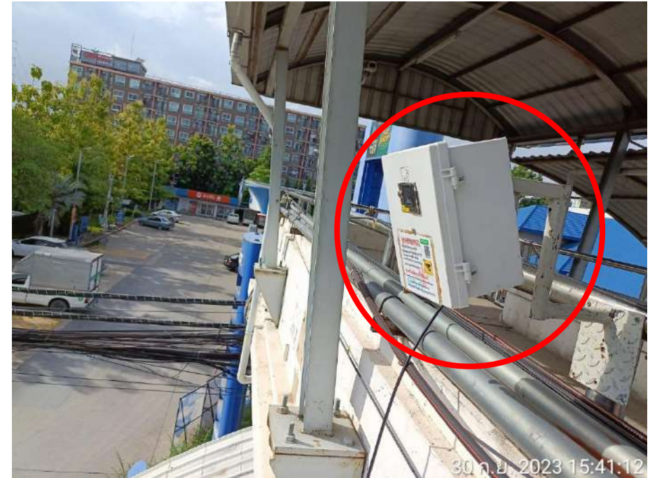
จุดที่ 2 ถนนพระรามที่ 2 บริเวณปั้มน้ำมัน ปตท. กม.7+737
