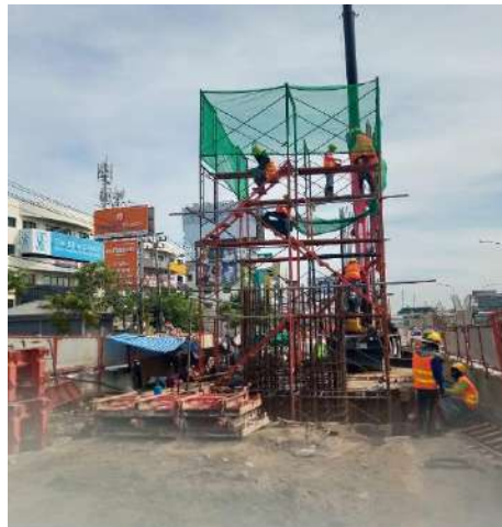
ROF02-03/L งานติดตั้งเหล็กเสริม Column Type S4
