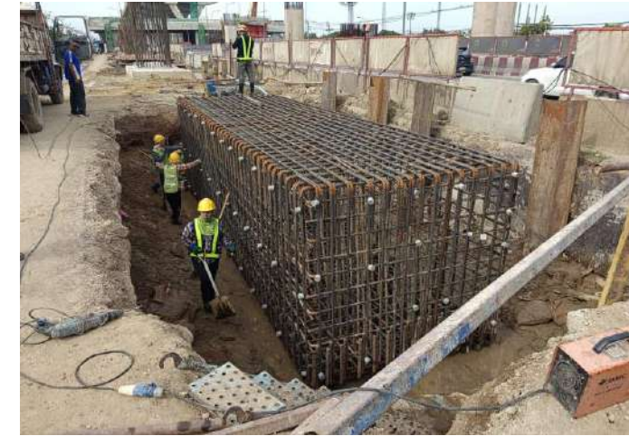
MLP01-09R งานติดตั้งเหล็กเสริม Footing
