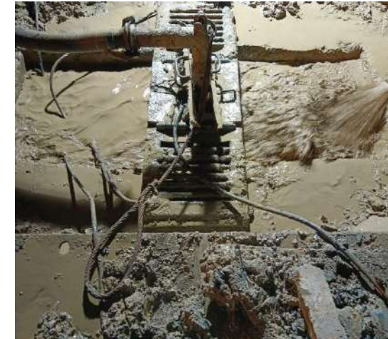
MLP02-13/1L งาน Airlift & Desand Barrette Pile
