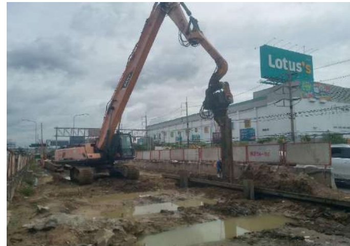
MLP04-07/C งานติดตั้ง Sheet Pile Footing
