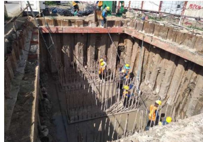
MLP04-01/C งานติดตั้งเหล็กเสริม Footing
