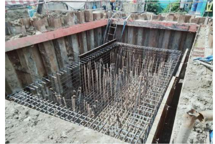
MLP04-07/C งานติดตั้งเหล็กเสริม Footing
