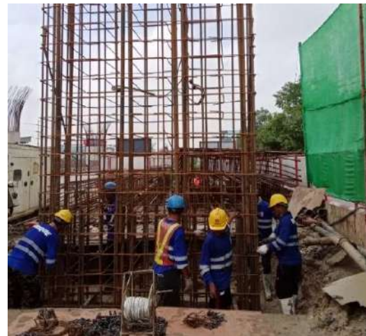
MLP02-13/1L งานติดตั้งเหล็กเสริม Barrette Pile
