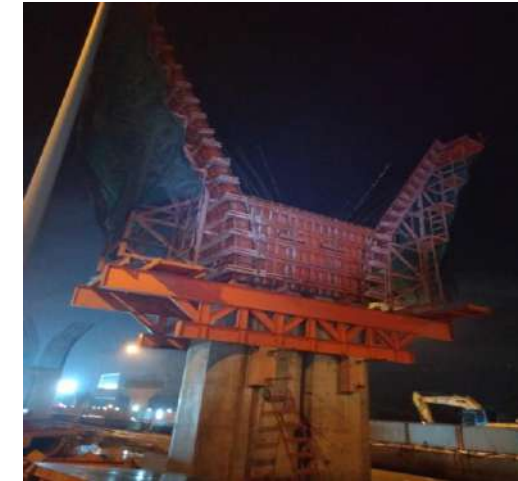
MLP01-18C งานติดตั้ง Formwork Column Type Y1 Step2
