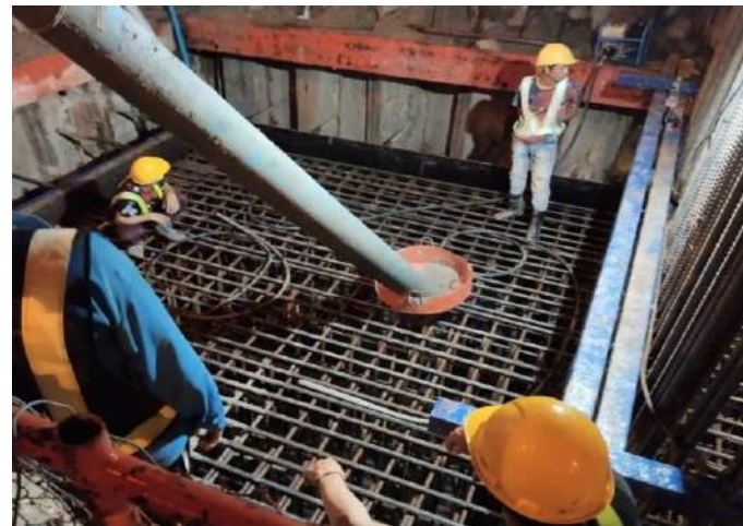
MLP01-03C งานเทคอนกรีต Footing
