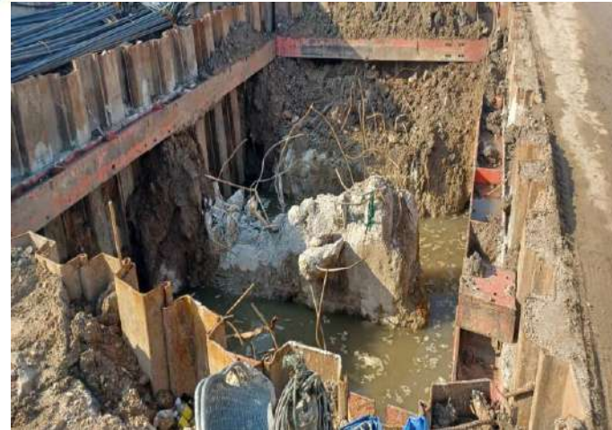
MLP01-26C งาน Pile Cut Off Footing
