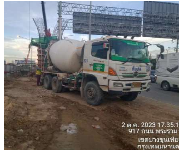
MLP04-11/C งานเทคอนกรีต Column Type Y2 Step 1
