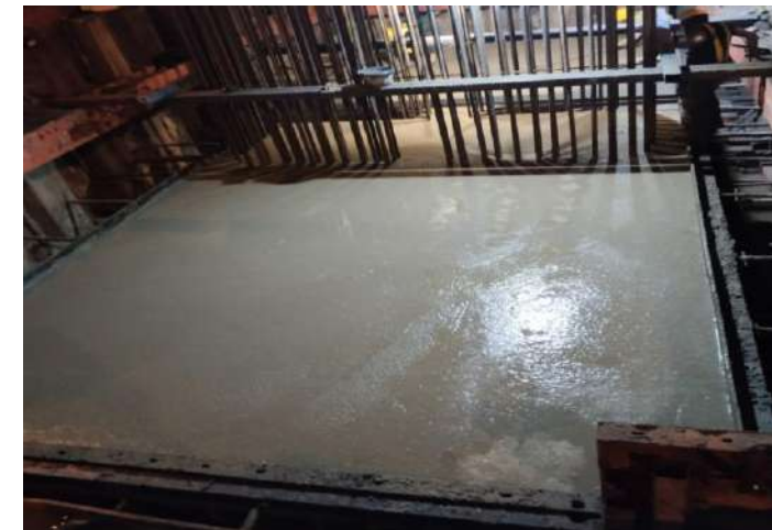
MLP01-03C งานเทคอนกรีต Footing
