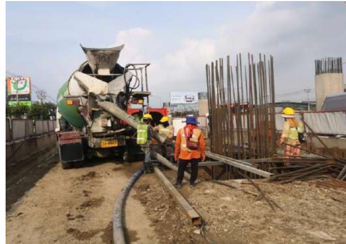
MLP01-05L งานเทคอนกรีต Footing
