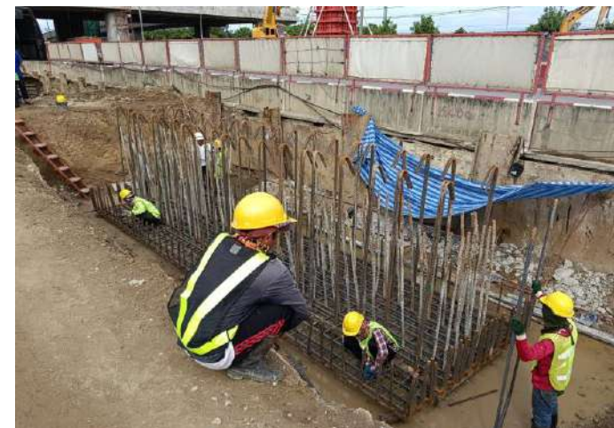
MLP01-05R งานติดตั้งเหล็กเสริม Footing
