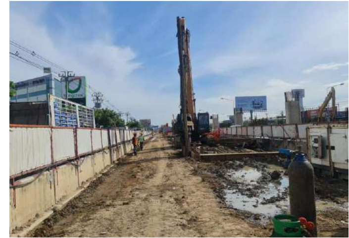
MLP01-06L งานติดตั้ง Sheet Pile Footing
