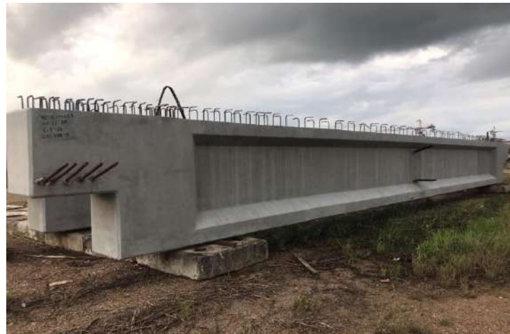
งานผลิตชิ้นงาน Precast Girder
