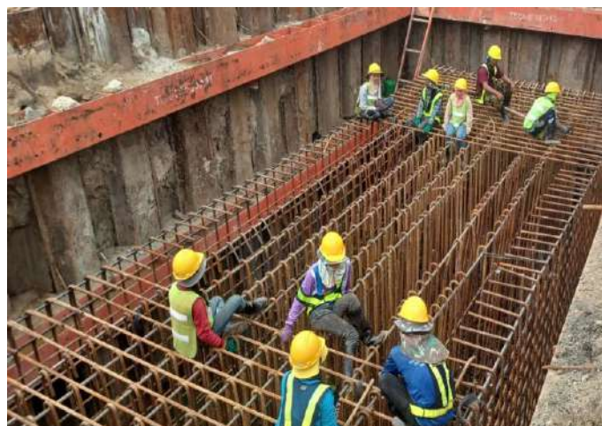
MLP01-03C งานติดตั้งเหล็กเสริม Footing
