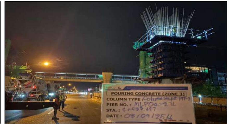
Pouring Concrete Column Pier Type P-1 Step 2 MLP04-21L
