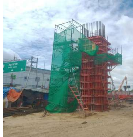
ROF02-07 งานติดตั้ง Formwork Column Type T4 Step2
