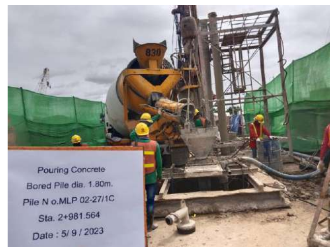
MLP02-27/1C งานเทคอนกรีต Bored Pile
