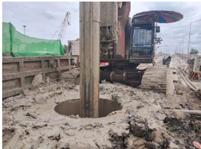
MLP02-27/4C งานเจาะเสาเข็ม Bored Pile
