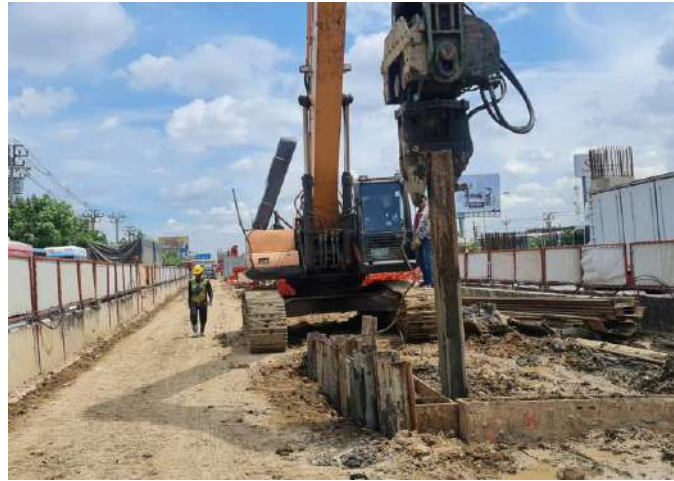
MLP01-06L งานติดตั้ง Sheet Pile Footing
