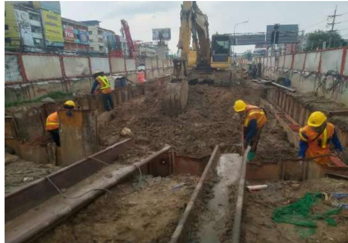
MLP04-09/C งานติดตั้ง Bracing Footing
