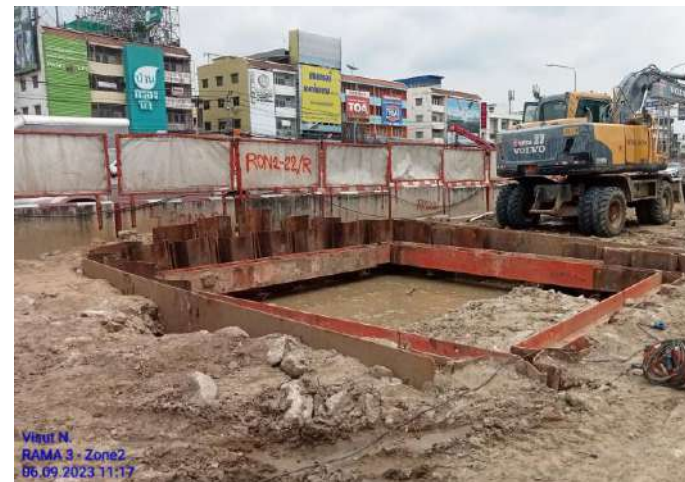
RON2-22 งานติดตั้ง Bracing Footing
