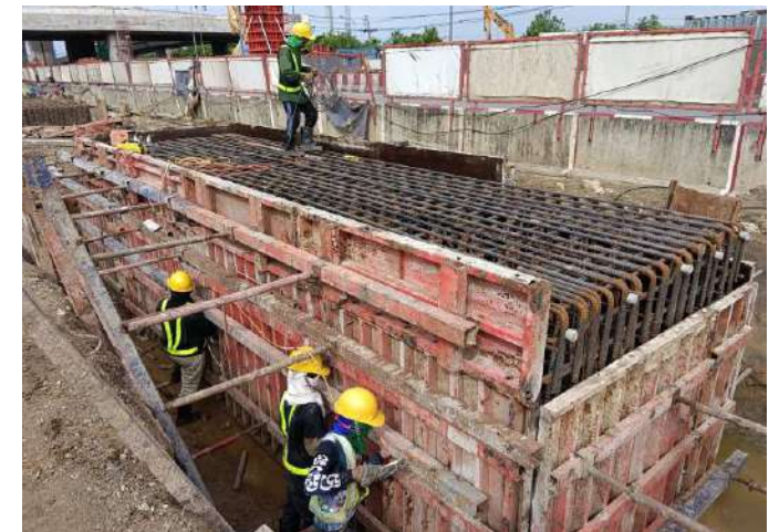
MLP01-06R งานติดตั้ง Formwork Footing
