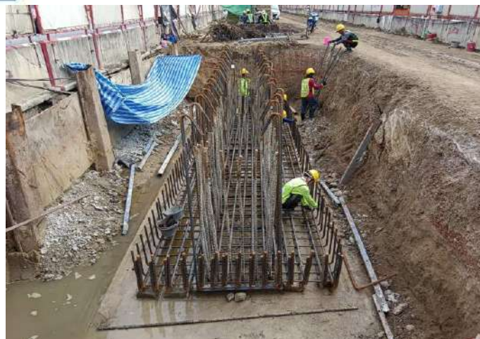
MLP01-05R งานติดตั้งเหล็กเสริม Footing
