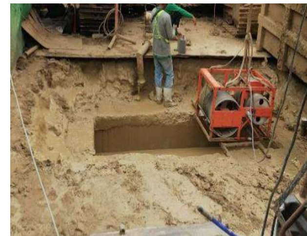
MLP02-20/2L งาน Drilling Monitor Test Barrette Pile
