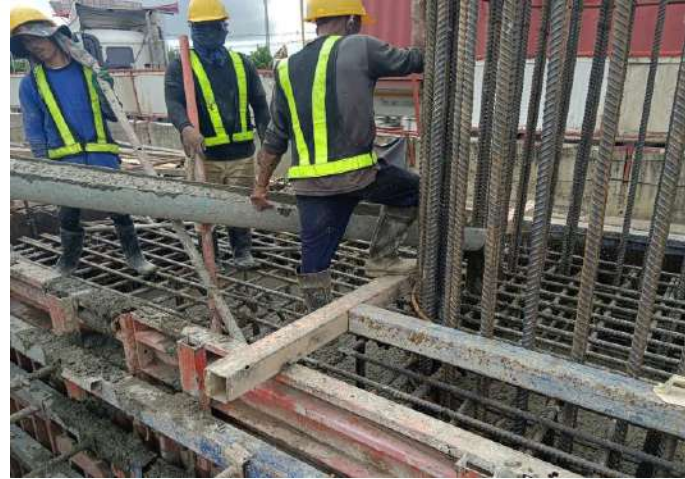
MLP01-06R งานเทคอนกรีต Footing
