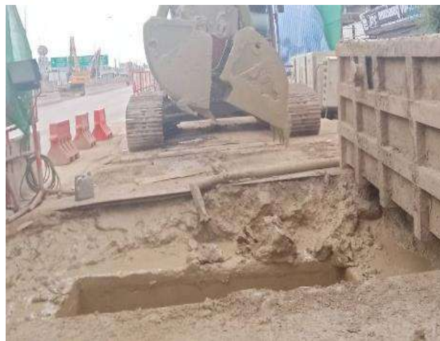
MLP02-18/1L งานเจาะเสาเข็ม Barrette Pile
