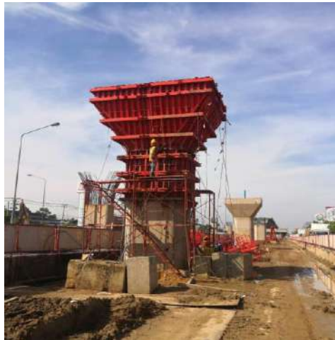
RON1-22 งานติดตั้ง Formwork Column Type S5 (Pier Head)
