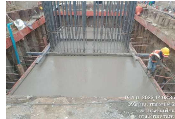
MLP04-03/C งานเทคอนกรีต Footing
