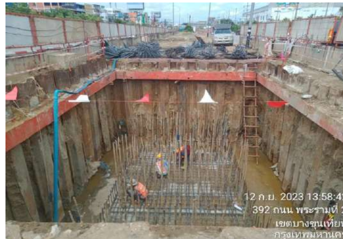
MLP04-03/C งานงานติดตั้งเหล็กเสริม Footing
