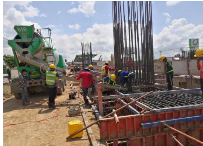
MLP01-11R งานเทคอนกรีต Footing
