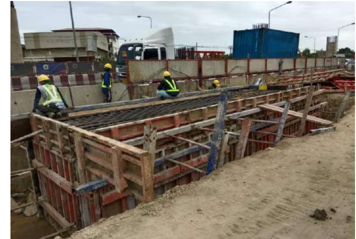
MLP01-10R งานติดตั้ง Formwork Footing
