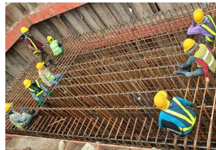
MLP01-03C งานติดตั้งเหล็กเสริม Footing
