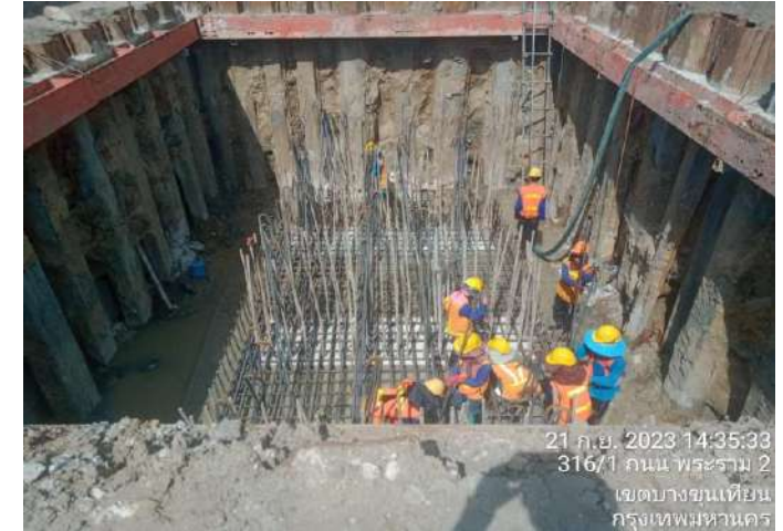
MLP04-11/C งานงานติดตั้งเหล็กเสริม Footing
