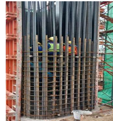
MLP02-07C งานติดตั้งเหล็กเสริม Column Type Y1 Step1
