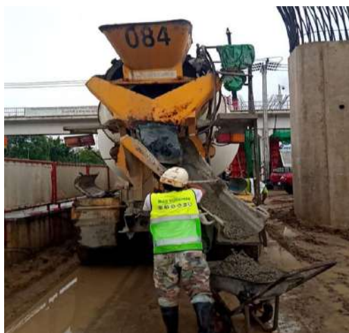
MLP02-07C งานเทคอนกรีต Column Tpye Y1 Step1
