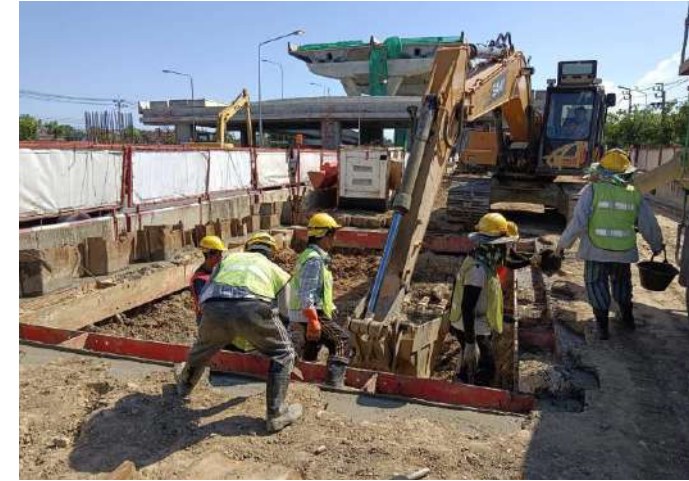
MLP01-04L งานติดตั้ง Bracing Footing
