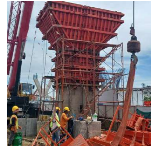
RON1-22 งานติดตั้ง Formwork Column Type S5 (Pier Head)
