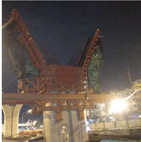
MLP02-02C งานติดตั้ง Formwork Column Type Y1 Step2
