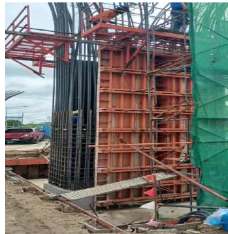
MLP02-07C งานติดตั้งเหล็กเสริม Column Type Y1 Step1
