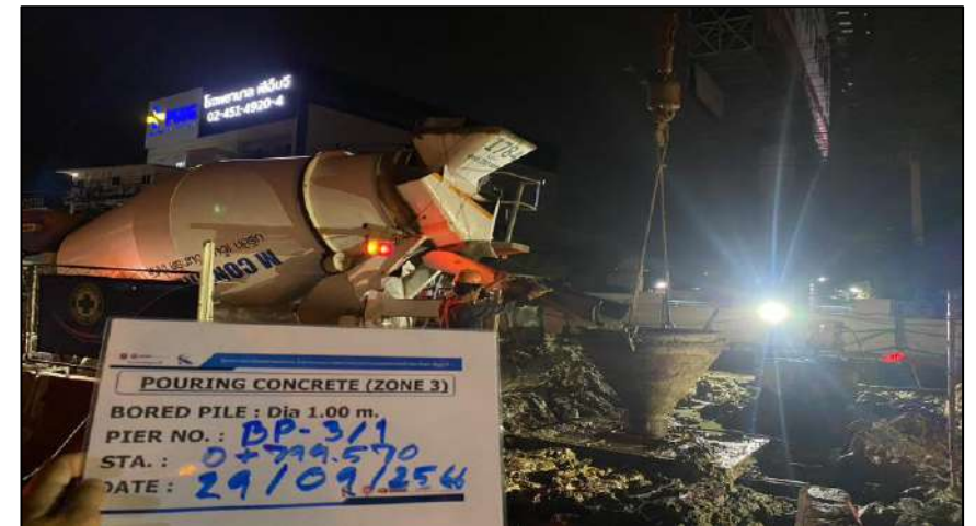
Pouring Concrete Bored Pile Dia 1.00 m. BP-3L/2
