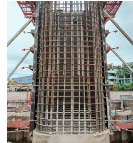
MLP01-04C งานติดตั้งเหล็กเสริม Column Type PTT-1 Step1
