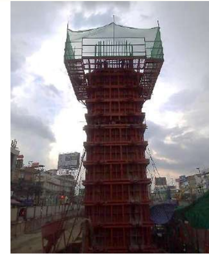
ROF02-07 งานติดตั้ง Formwork Column Type T4 Step2
