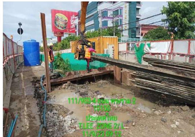
ROF02-02 งานติดตั้ง Sheet Pile Footing
