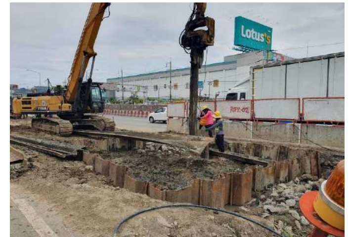
MLP04-14C งานติดตั้ง Sheet Pile Footing
