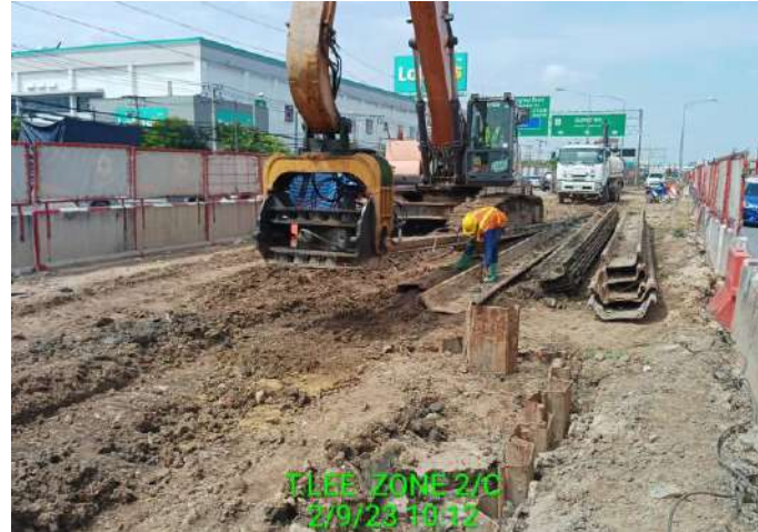
MLP04-14C งานติดตั้ง Sheet Pile Footing
