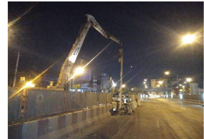
MLP01-08R งานติดตั้ง Sheet Pile Footing
