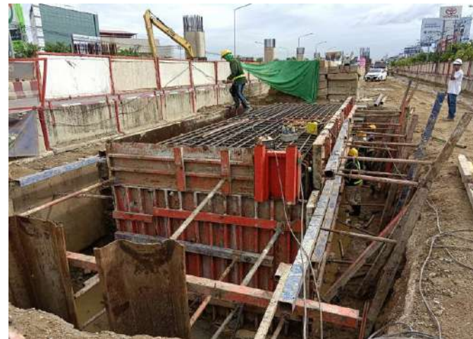
MLP01-06R งานติดตั้ง Formwork Footing
