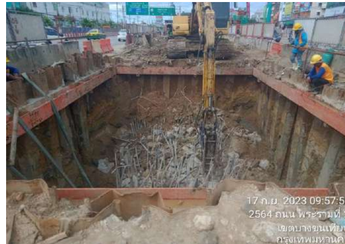
MLP04-02/C งาน Pile Cut Off Footing
