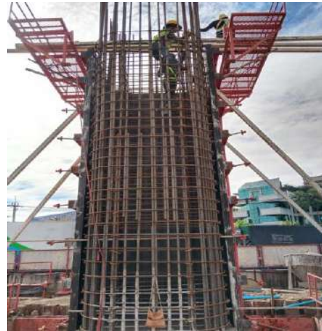
MLP01-04C งานติดตั้งเหล็กเสริม Column Type PTT-1 Step1
