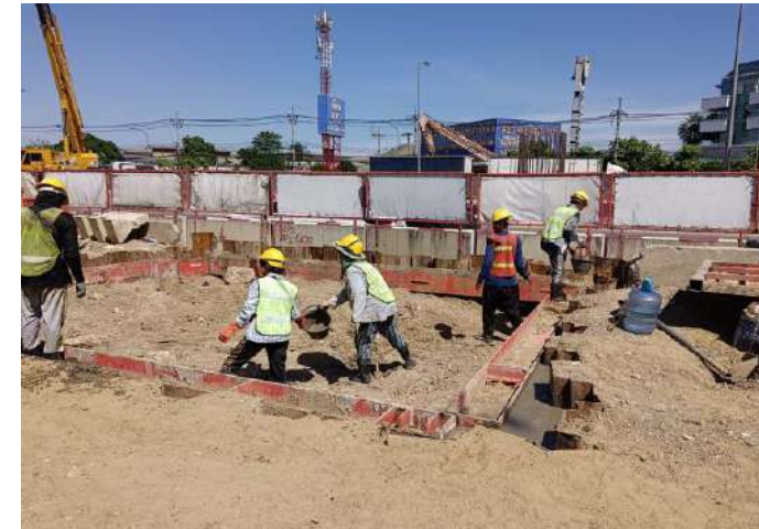
MLP01-05L งานติดตั้ง Bracing Footing
