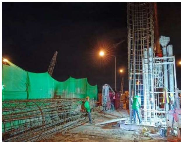
MLP02-27/3C งานติดตั้งเหล็กเสริม Bored Pile
