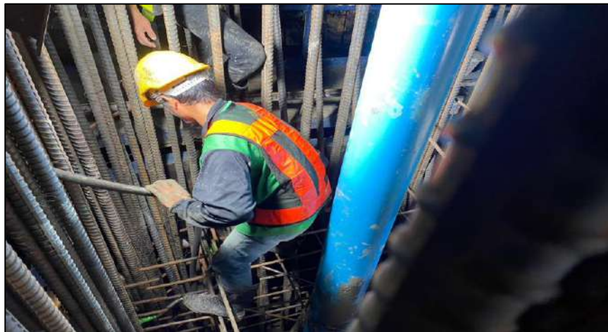
Pouring Concrete Column Pier Type P-1 Step 2 MLP04-21L
