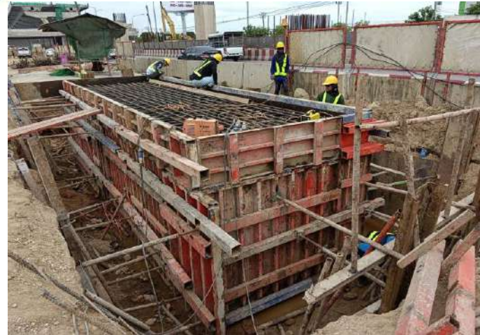
MLP01-10R งานติดตั้ง Formwork Footing
