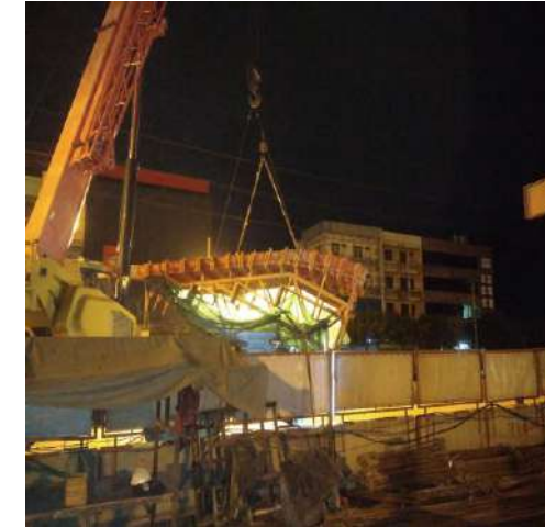
MLP02-02C งานติดตั้ง Formwork Column Type Y1 Step2
