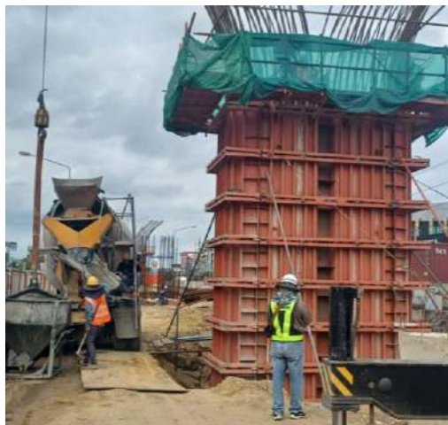
MLP01-08C งานเทคอนกรีต Column Type Y1 Step1
