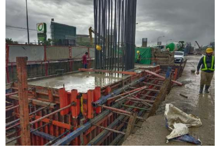
MLP01-06R งานเทคอนกรีต Footing
