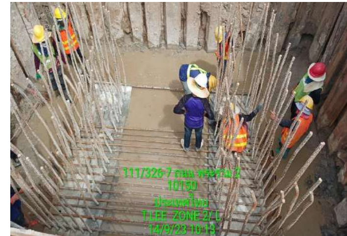
MLP04-03/C งานงานติดตั้งเหล็กเสริม Footing
