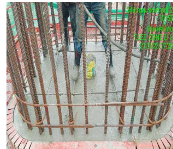
ROF02-07 งานเทคอนกรีต Column Type T4 Step2
