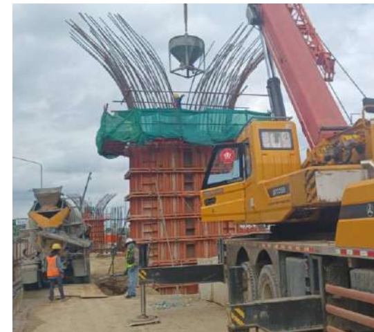
MLP01-08C งานเทคอนกรีต Column Type Y1 Step1
