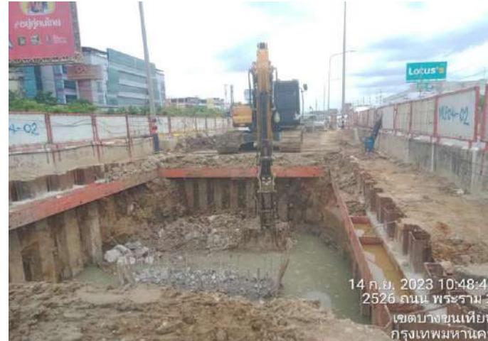
MLP04-01/C งาน Pile Cut Off Footing
