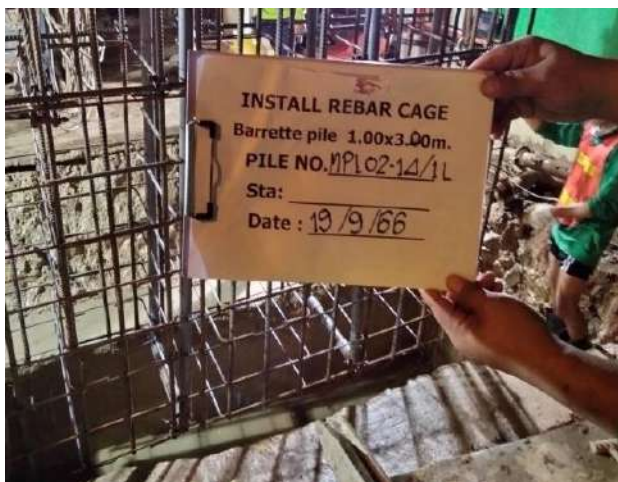
MLP02-14/1L งานติดตั้งเหล็กเสริม Barrette Pile
