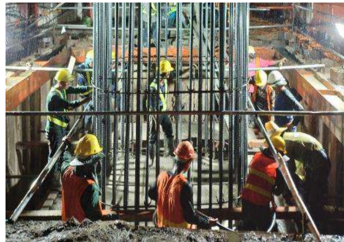
ROF02-04 งานเทคอนกรีต Footing
