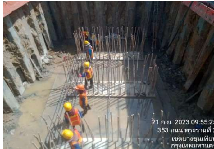
MLP04-11/C งานงานติดตั้งเหล็กเสริม Footing
