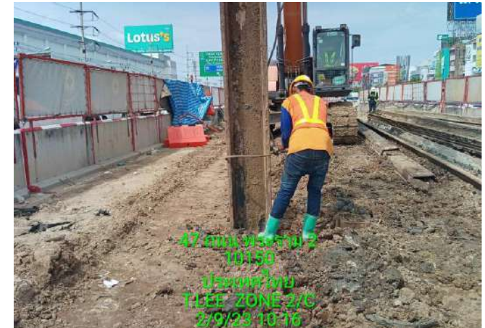
MLP04-14C งานติดตั้ง Sheet Pile Footing
