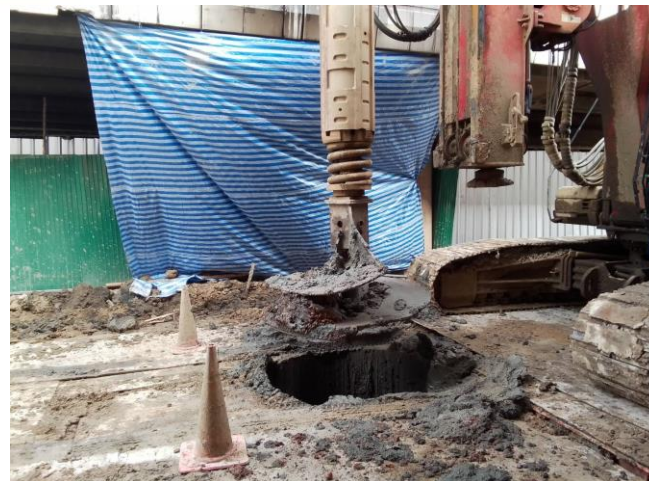
MLP03-03/1C งานเจาะเสาเข็ม Bored Pile
