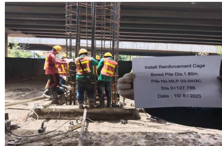
MLP03-04/2C งานติดตั้งเหล็กเสริม Bored Pile
