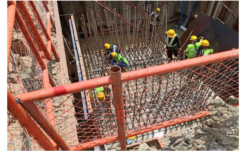
MLP01-04C งานติดตั้งเหล็กเสริม Footing
