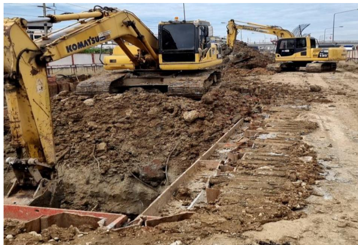
MLP02-11C งาน Excavation Footing
