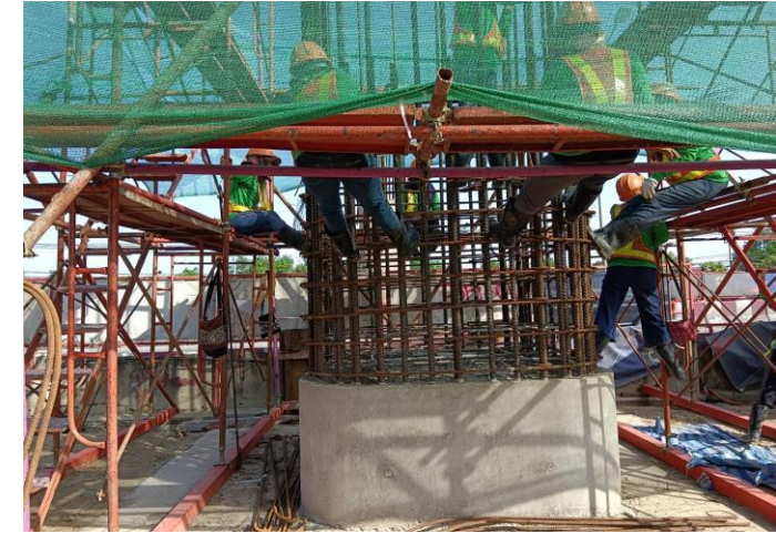
ROF1-06 งานติดตั้งเหล็กเสริม Column S5
