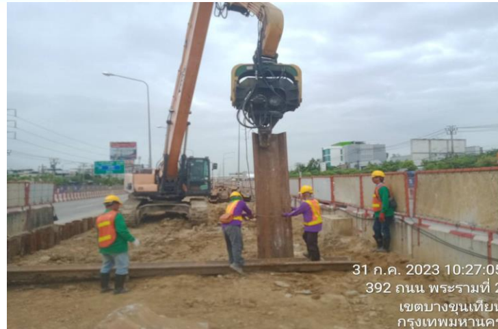
MLP04-03/C งานติดตั้ง Sheet Pile Footing
