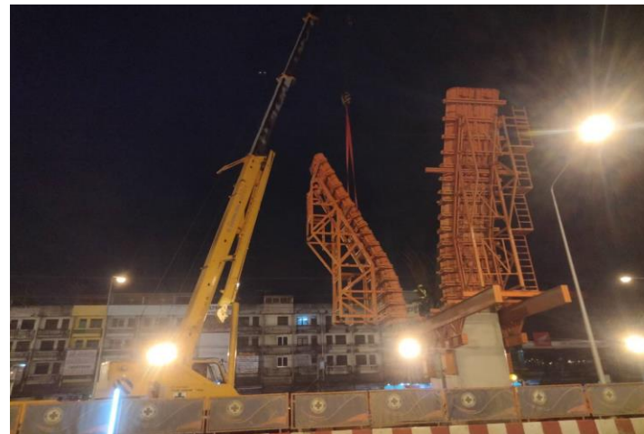
MLP02-03C งานติดตั้ง Formwork Column Y-1 Step2
