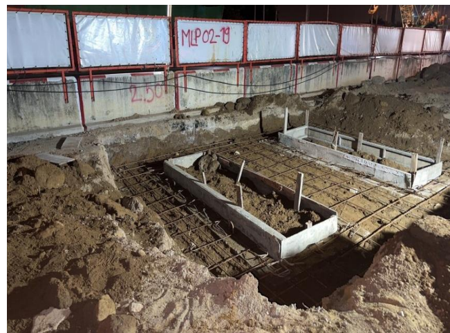
MLP02-19R งานติดตั้ง Rebar Cage Guide Wall
