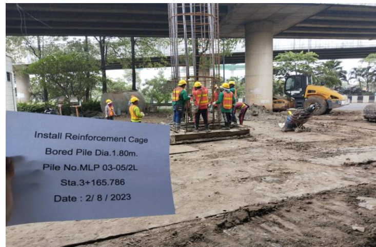
MLP03-05/2L งานติดตั้งเหล็กเสริม Bored Pile
