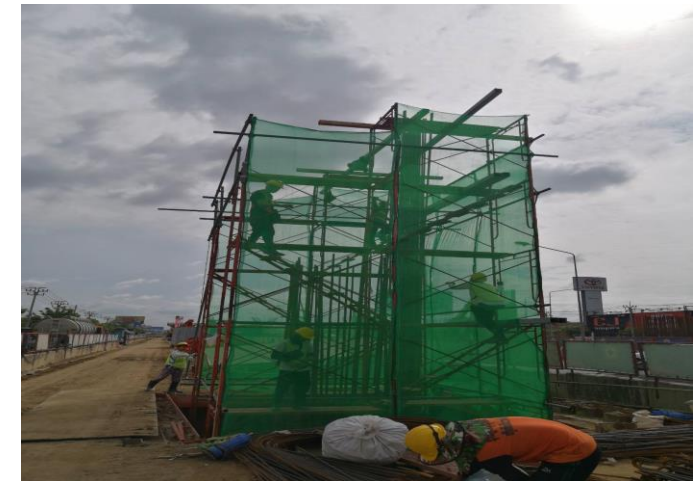
MLP01-08L งานติดตั้งเหล็กเสริม Column PTT-1
