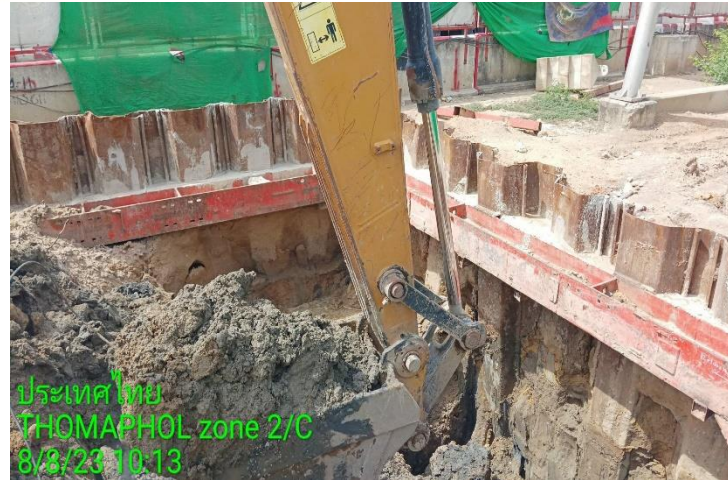
MLP04-11C งาน Excavation Footing
