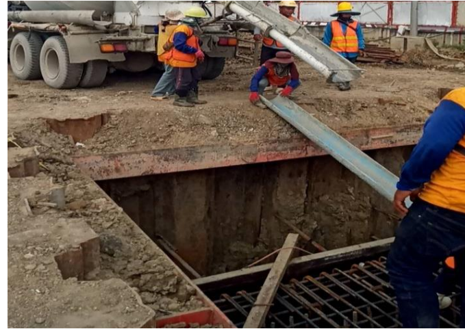
MLP02-10C งานเทคอนกรีต Footing
