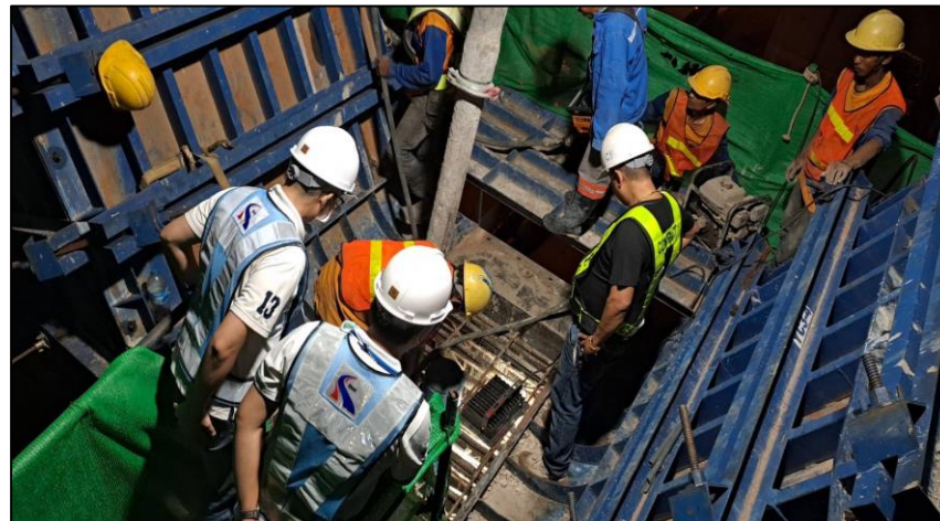
Pouring Concrete Column Pier Type Y-1 Step Y MLP04-28C
