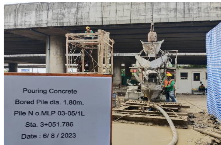
MLP03-05/1L งานเทคอนกรีต Bored Pile
