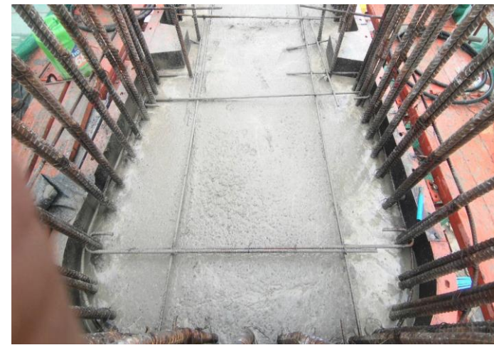
MLP01-27C งานเทคอนกรีต Column IYI-2 Step
