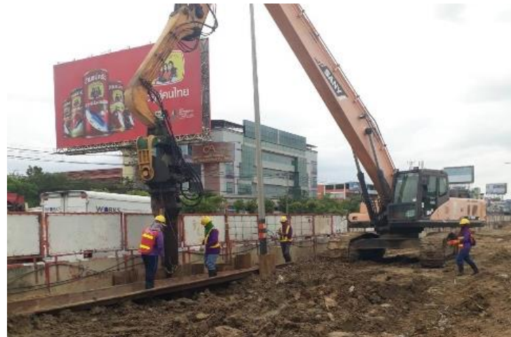
MLP04-02/C งานติดตั้ง Sheet Pile Footing
