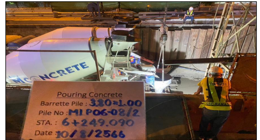
Pouring concrete Barrette pile MLP06-08C/2
