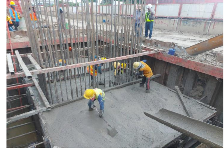
MLP02-10C งานเทคอนกรีต Footing
