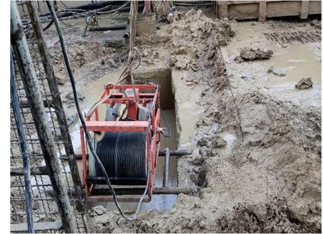
MLP02-18/3C งาน Drilling Monitor Test Barrette Pile
