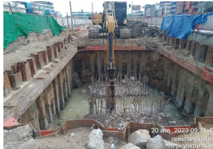
MLP04-11C งาน Pile Cut Off Footing
