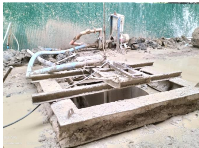
MLP03-05/2C งาน Airlift & Desand Bored Pile
