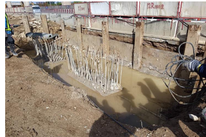
MLP01-12R งาน Pile Cut Off Footing
