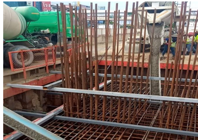
MLP01-25C งานเทคอนกรีต Footing
