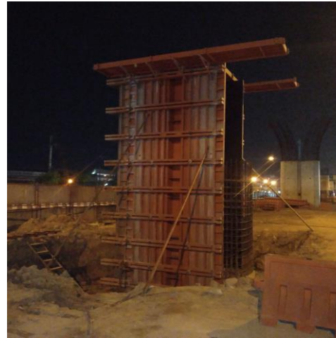
MLP01-17C งานติดตั้ง Formwork Column Y Step1
