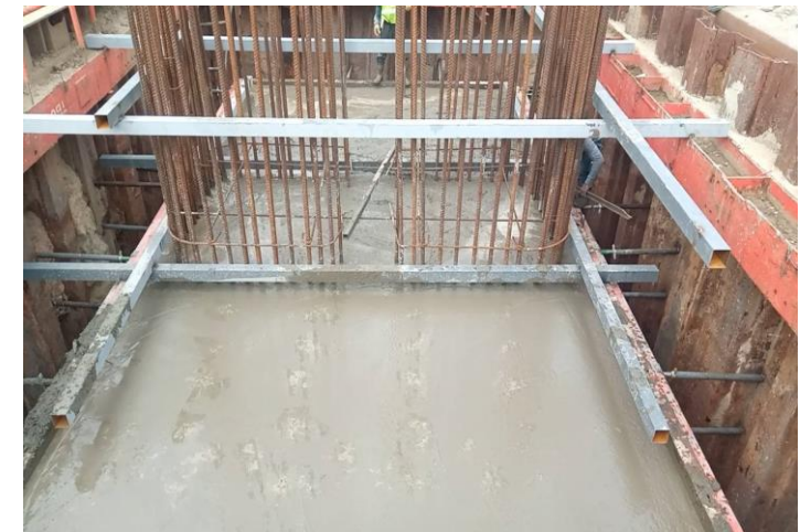
MLP01-25C งานเทคอนกรีต Footing
