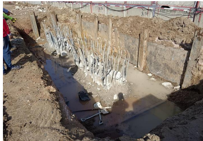
MLP01-12R งาน Pile Cut Off Footing
