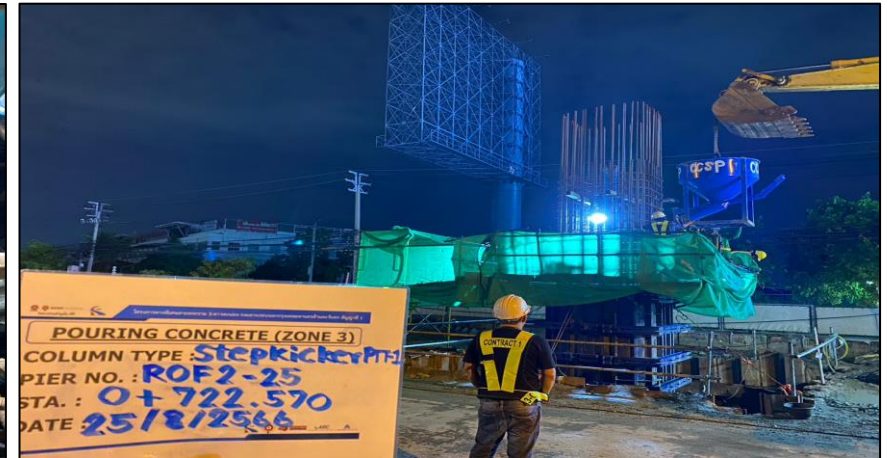
Pouring Concrete Column Pier Type P-1 Step 1 ROF2-25
