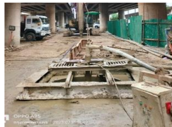
MLP03-04/3C งาน Airlift & Desand Bored Pile
