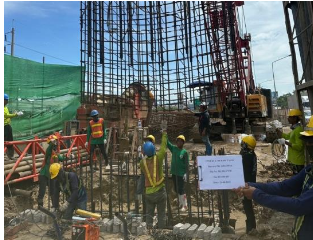
MLP02-17/3C งานติดตั้งเหล็กเสริม Barrette Pile
