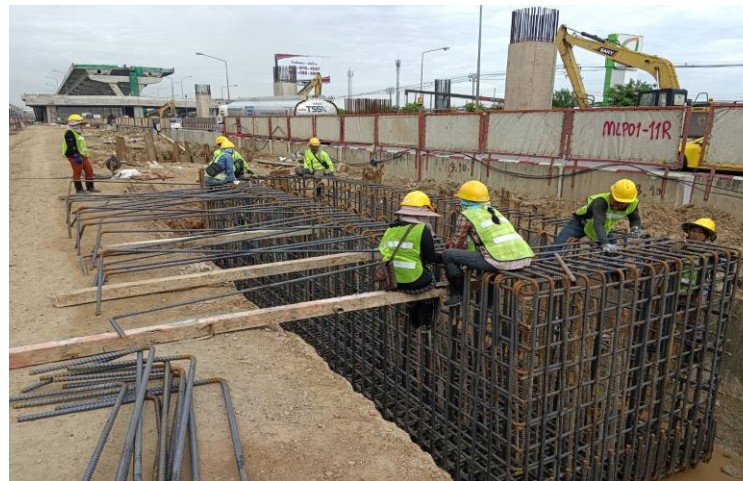
MLP01-11R งานติดตั้งเหล็กเสริม Footing
