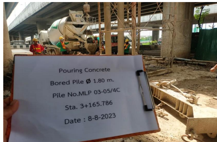
MLP03-05/4C งานเทคอนกรีต Bored Pile
