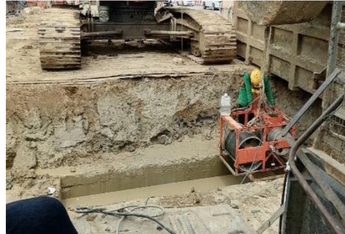
MLP02-19/2C งาน Drilling Monitor Test Barrette Pile
