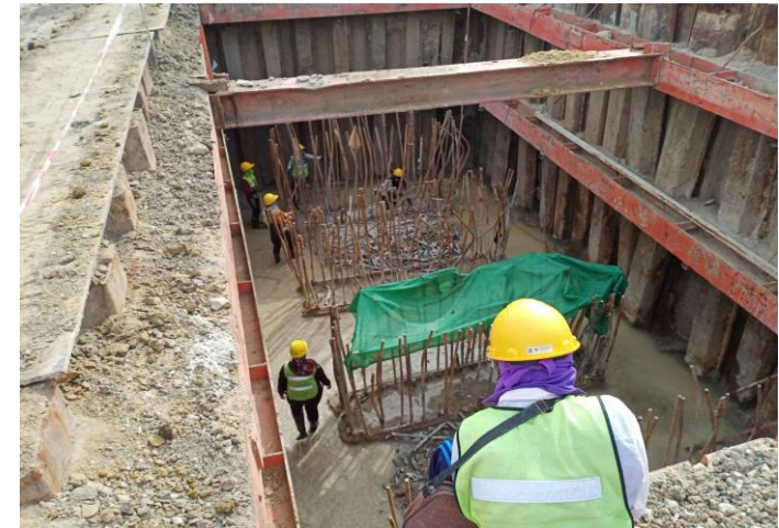
MLP01-05C งาน Pile Cut Off Footing
