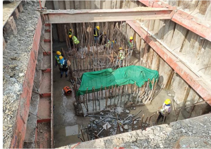
MLP01-05C งาน Pile Cut Off Footing
