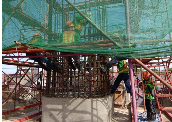
ROF1-06 งานติดตั้งเหล็กเสริม Column S5
