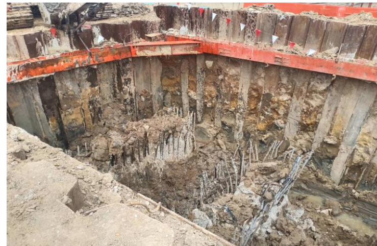
MLP01-32C งาน Excavation Footing
