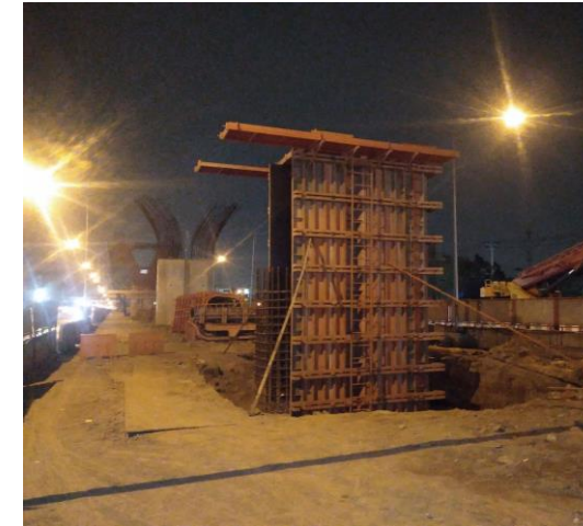
MLP01-17C งานติดตั้ง Formwork Column Y Step1
