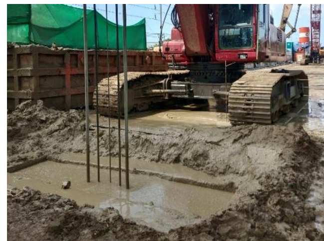
MLP02-18/3C งานเจาะเสาเข็ม Barrette Pile
