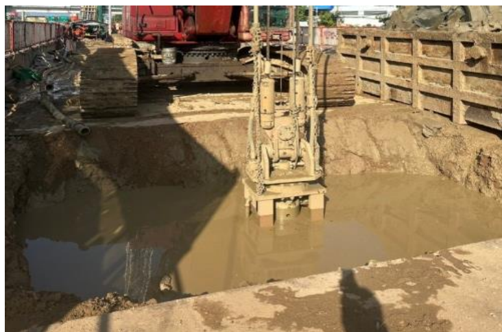
MLP02-21/2C งานเจาะเสาเข็ม Barrette Pile
