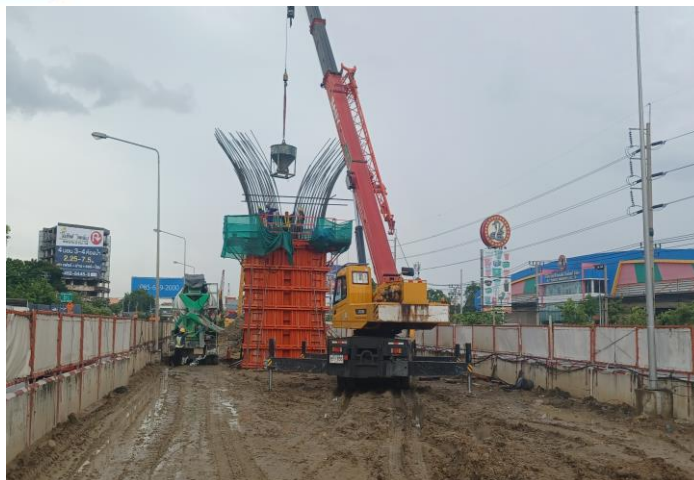
MLP02-09C งานเทคอนกรีต Column Step1
