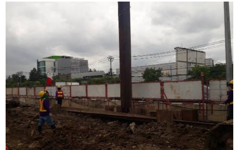
MLP04-02/C งานติดตั้ง Sheet Pile Footing
