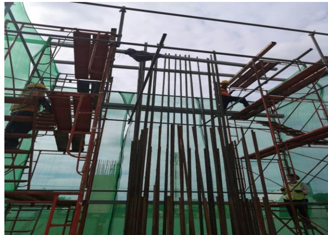
MLP01-08L งานติดตั้งเหล็กเสริม Column PTT-1
