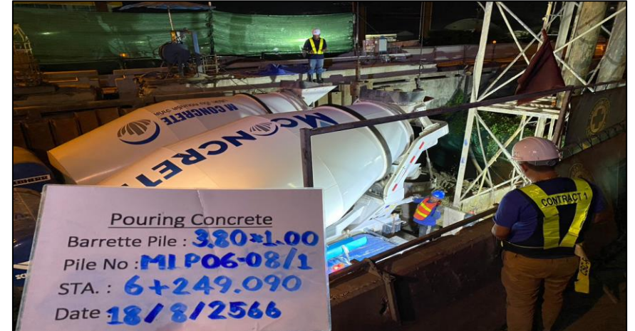
Pouring concrete MLP06-08C/1
