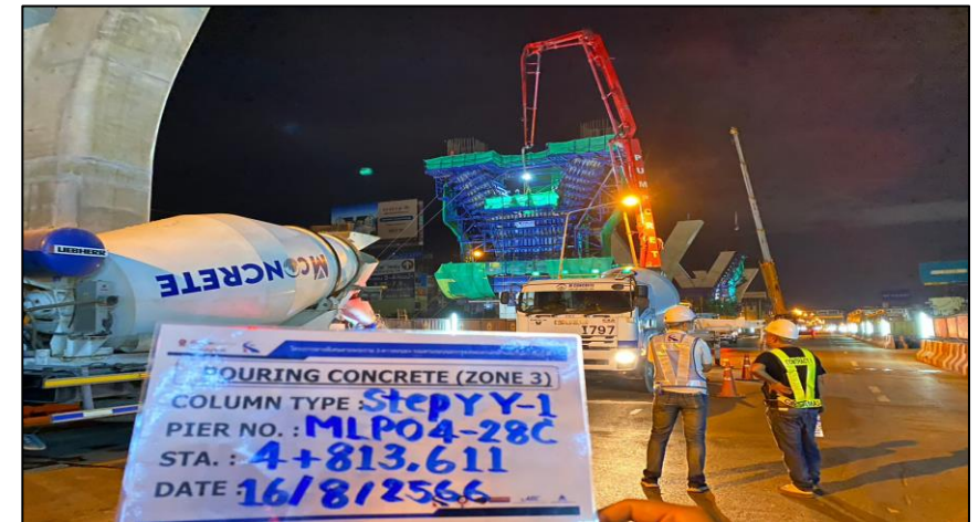
Pouring Concrete Column Pier Type Y-1 Step Y MLP04-28C
