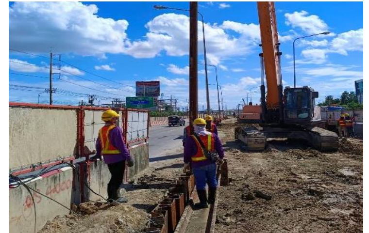
MLP04-03/C งานติดตั้ง Sheet Pile Footing
