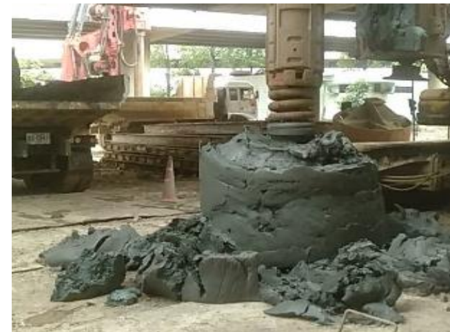
MLP03-04/3C งานเจาะเสาเข็ม Bored Pile
