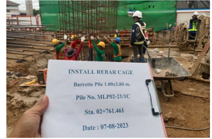
MLP02-21/1C งานติดตั้งเหล็กเสริม Barrette Pile
