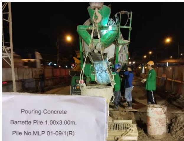
MLP01-09 R งานเทคอนกรีต Barrette Pile
