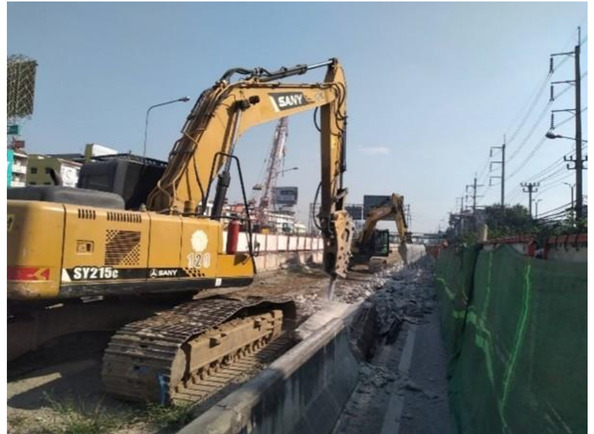
งานรื้อย้าย Barrier ของกรมทางหลวง บริเวณ Zone 2 ของโครงการฯ
