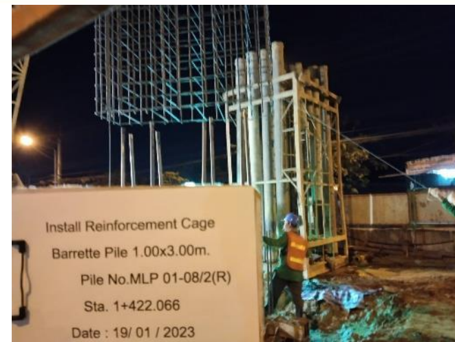
MLP01-08Rงานติดตั้งโครงเหล็กเสริม
