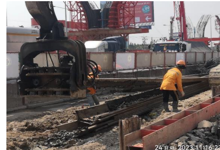
MLP01-23L งานปัก Sheet Pile และ ติดตั้ง Bracing
