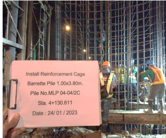
MLP04-04งานติดตั้งโครงเหล็กเสริม
