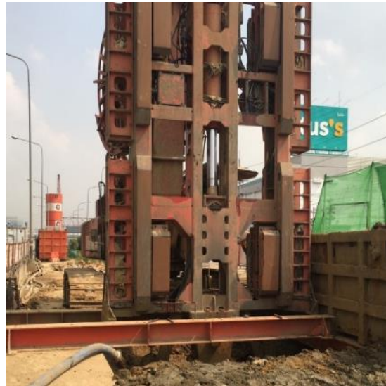
MLP4-05 งานเจาะเสาเข็ม Barrette Pile
