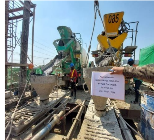
MLP04-04 งานเทคอนกรีต Barrette Pile
