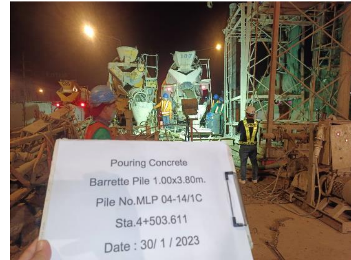
MLP04-14 งานเทคอนกรีต Barrette Pile
