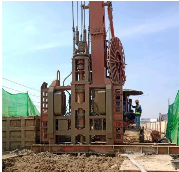
MLP4-04 งานเจาะเสาเข็ม Barrette Pile
