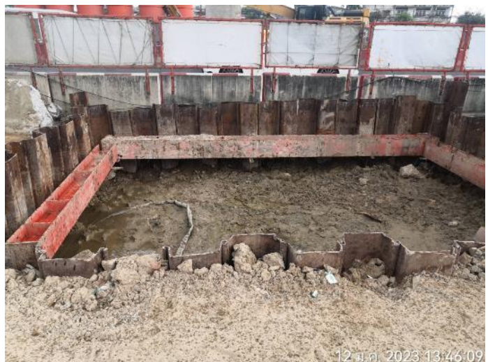
MLP01-21L งานปัก Sheet Pile และ ติดตั้ง Bracing
