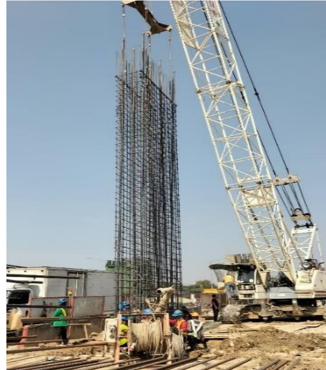
MLP01-12Rงานติดตั้งโครงเหล็กเสริม
