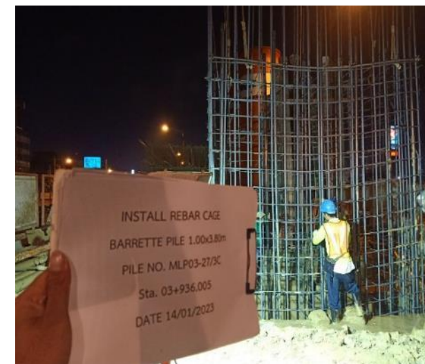
MLP03-27 งานติดตั้งโครงเหล็กเสริม
