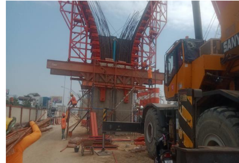
MLP01-20 ติดตั้ง Formwork Column Step2
