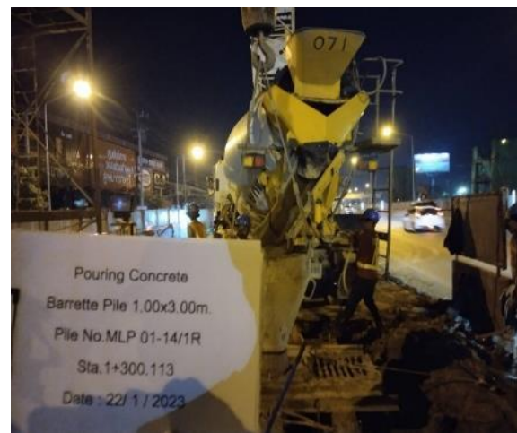
MLP01-14 R งานเทคอนกรีต Barrette Pile
