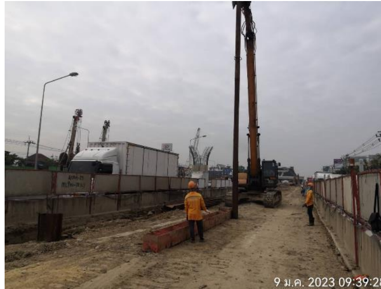
MLP01-18L งานปัก Sheet Pile และ ติดตั้ง Bracing
