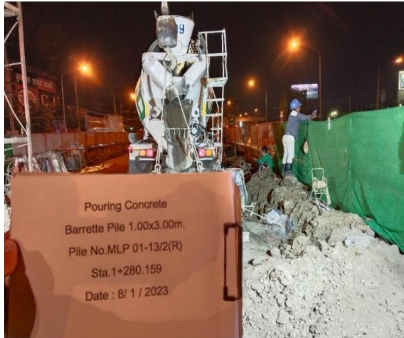
MLP01-13 R งานเทคอนกรีต Barrette Pile
