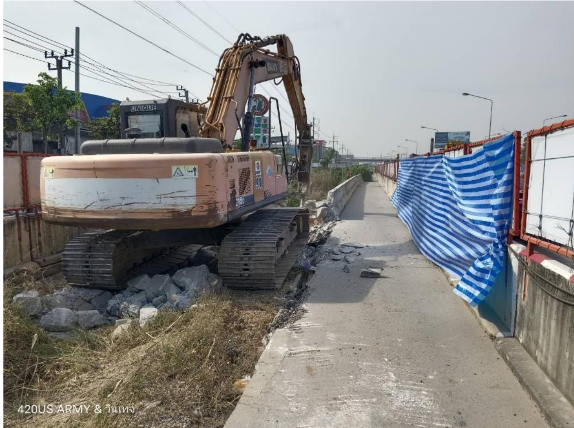
งานรื้อย้าย Barrier ของกรมทางหลวง บริเวณ Zone 2 ของโครงการฯ
