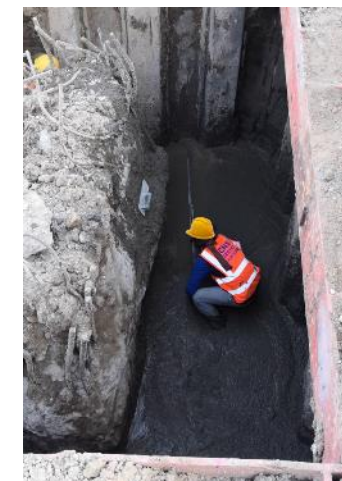
MLP01-21L งานเทลิ้นคอนกรีตฐานราก
