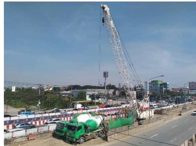
MLP03-22 งานเทคอนกรีต Barrette Pile
