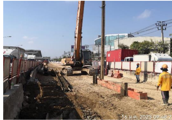
MLP01-15L งานปัก Sheet Pileและ ติดตั้ง Bracing
