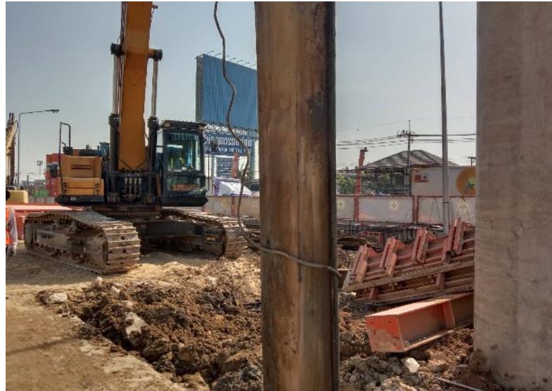
MLP01-18 งานรื้อถอน Sheet Pile
