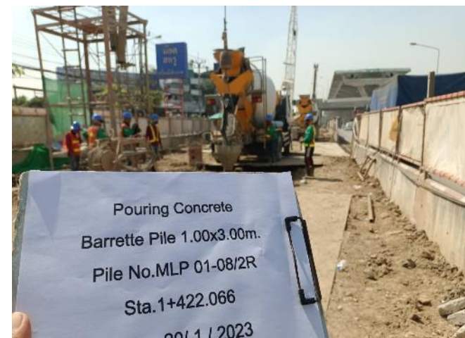
MLP01-08 R งานเทคอนกรีต Barrette Pile
