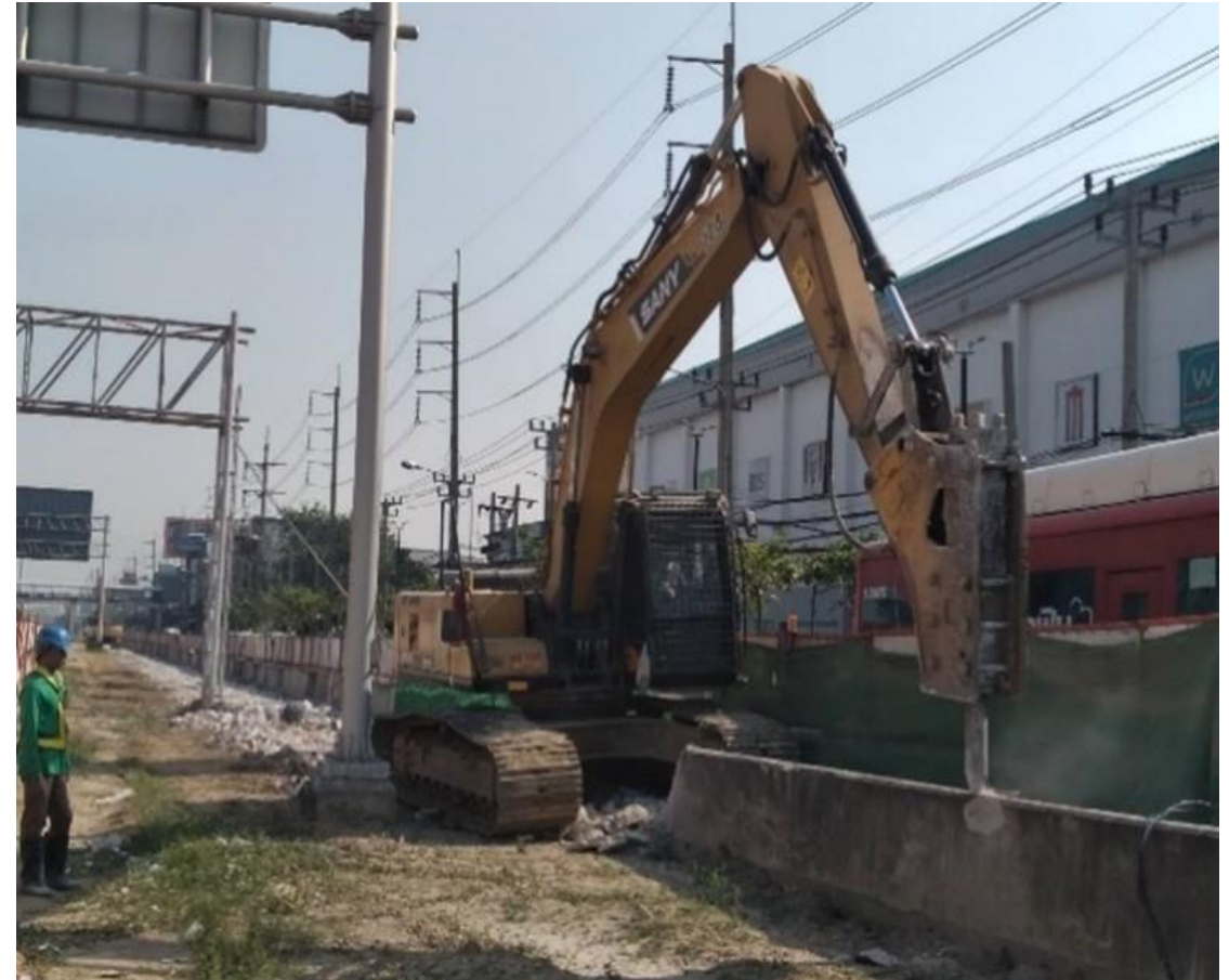
งานรื้อย้าย Barrier ของกรมทางหลวง บริเวณ Zone 2 ของโครงการฯ
