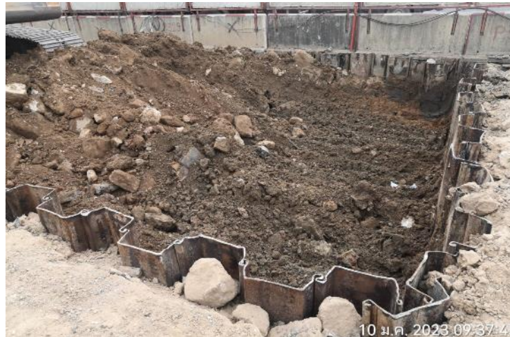
MLP01-08L งานปัก Sheet Pile และ ติดตั้ง Bracing
