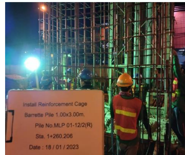
MLP01-12 Rงานติดตั้งโครงเหล็กเสริม
