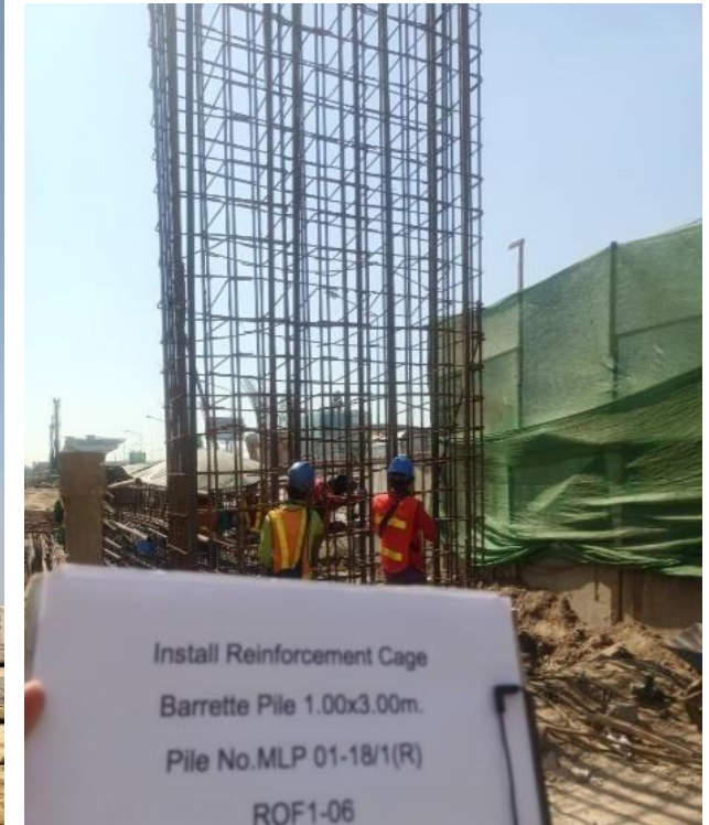
MLP01-18 Rงานติดตั้งโครงเหล็กเสริม
