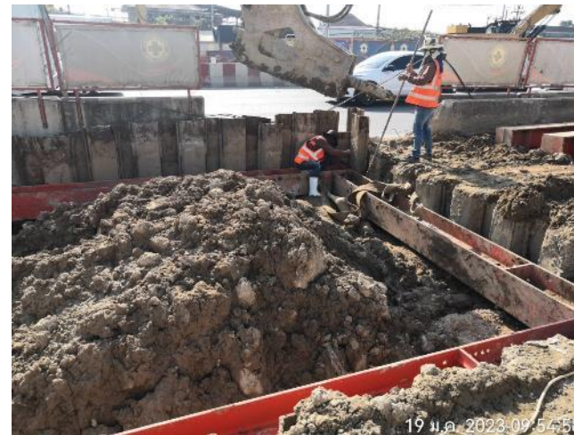
MLP01-17L งานปัก Sheet Pile และ ติดตั้ง Bracing
