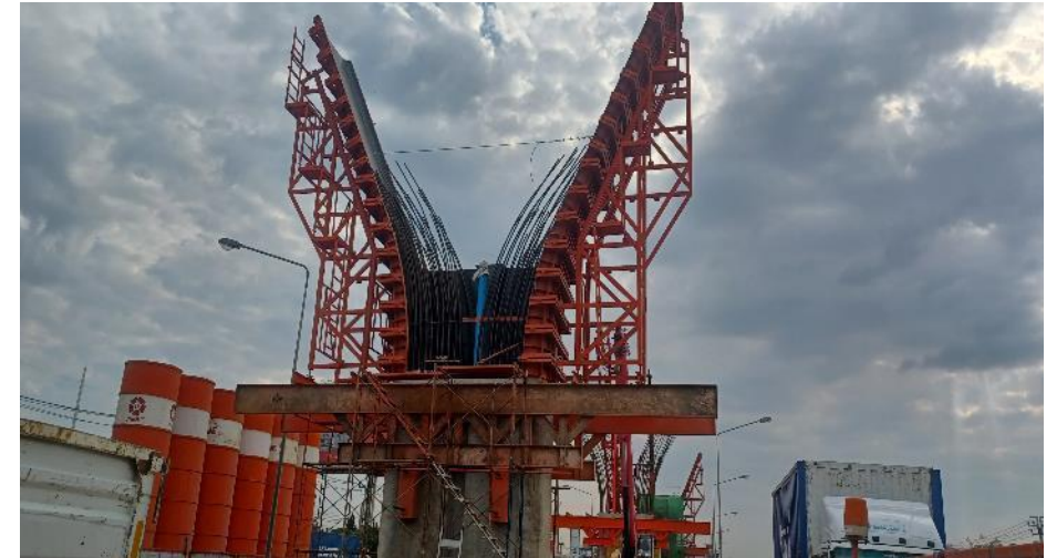
MLP01-21 งานติดตั้ง Formwork Column Step2
