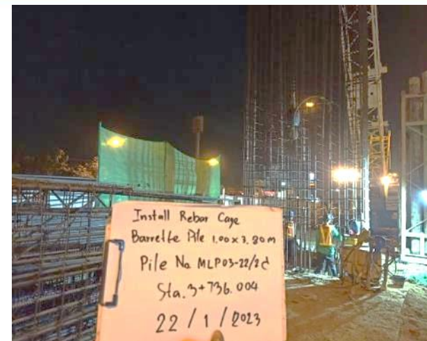
MLP03-22 งานติดตั้งโครงเหล็กเสริม
