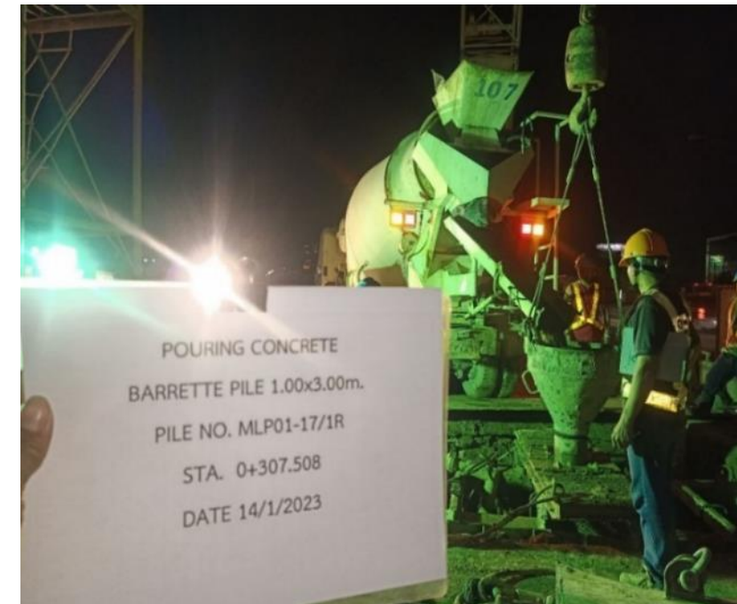
MLP01-17 R งานเทคอนกรีต Barrette Pile
