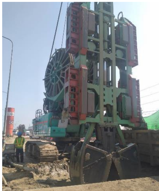
MLP3-25 งานเจาะเสาเข็ม Barrette Pile
