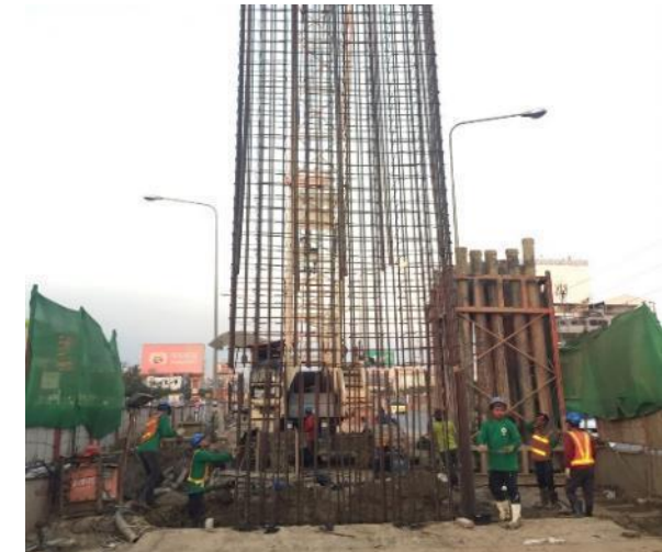
MLP03-22 งานติดตั้งโครงเหล็กเสริม
