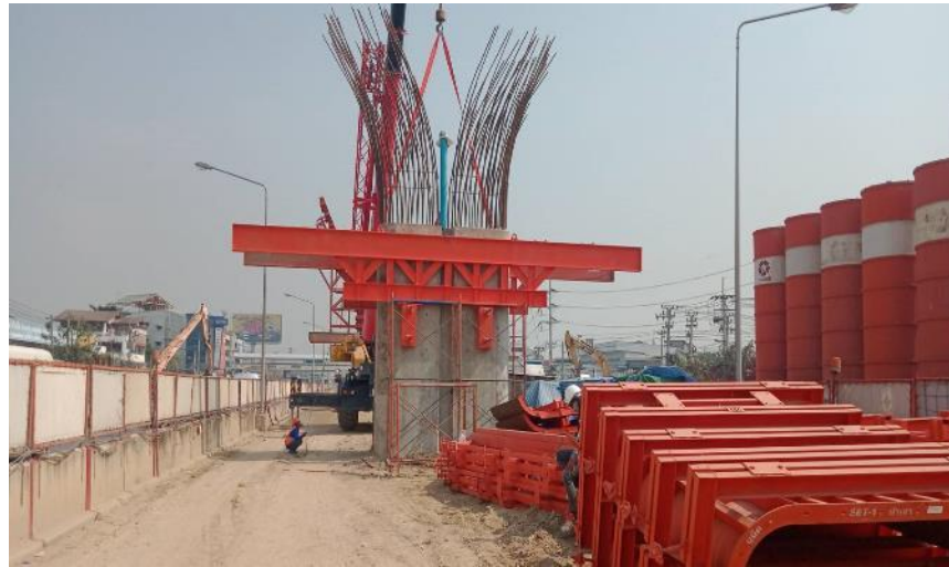
MLP01-21 งานติดตั้ง Formwork Column Step2
