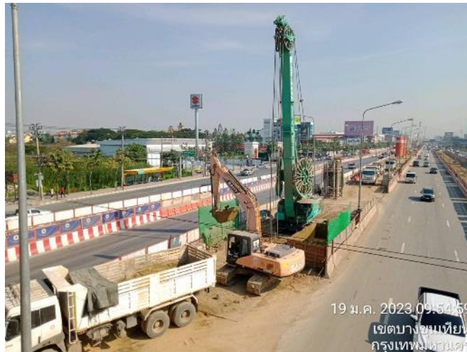
MLP03-22งานเจาะเสาเข็ม Barrette Pile
