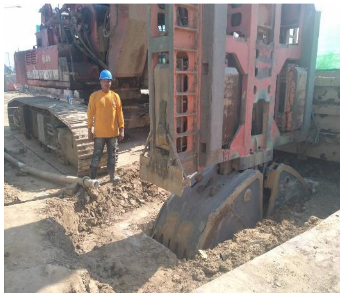
MLP4-02 งานเจาะเสาเข็ม Barrette Pile
