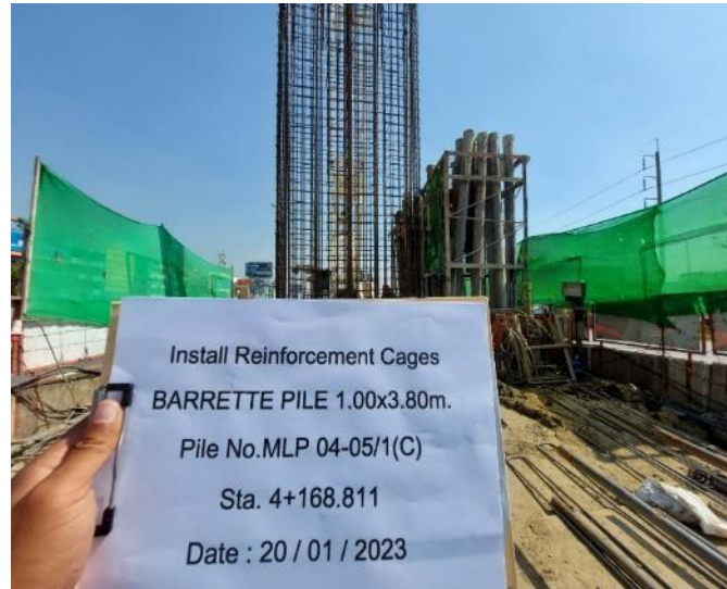
MLP04-05 งานติดตั้งโครงเหล็กเสริม
