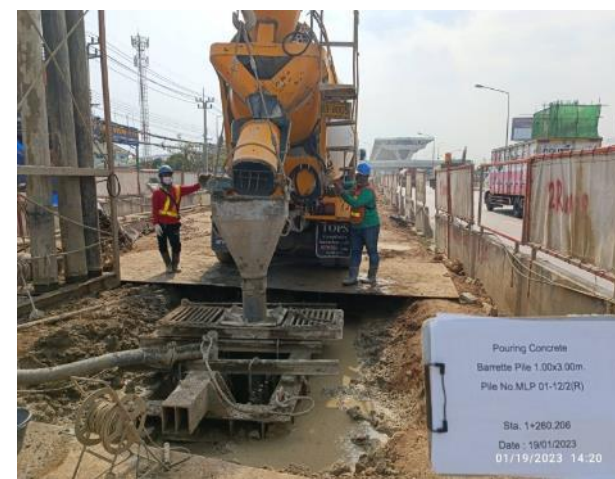
MLP01-12 R งานเทคอนกรีต Barrette Pile
