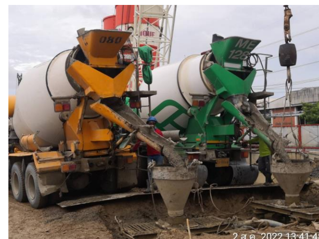
MLP01-27 งานเทคอนกรีต Barrette Pile
