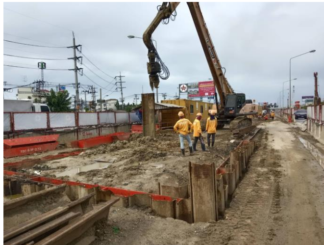
MLP01-25 งานปัก Sheet Pile และ ติดตั้ง Bracing
