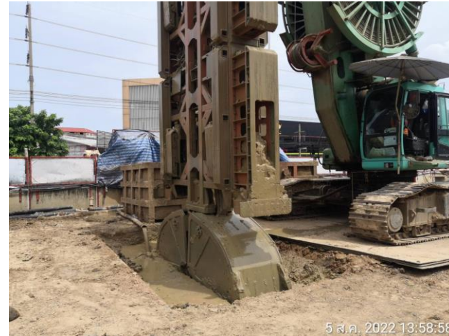
MLP01-31 งานเจาะเสาเข็ม Barrette Pile
