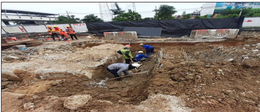
งาน Pile Cut off 3.80x1.00 m. EGAT#1
