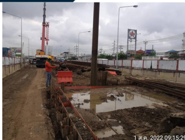
MLP01-20 งานปัก Sheet Pile และ ติดตั้ง Bracing
