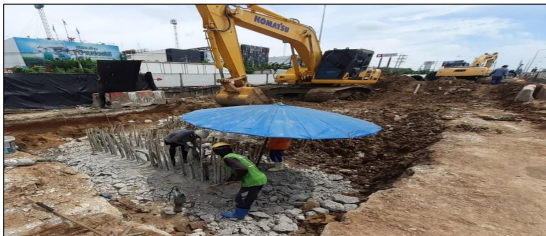
งาน Pile Cut off 3.80x1.00 m. EGAT#1
