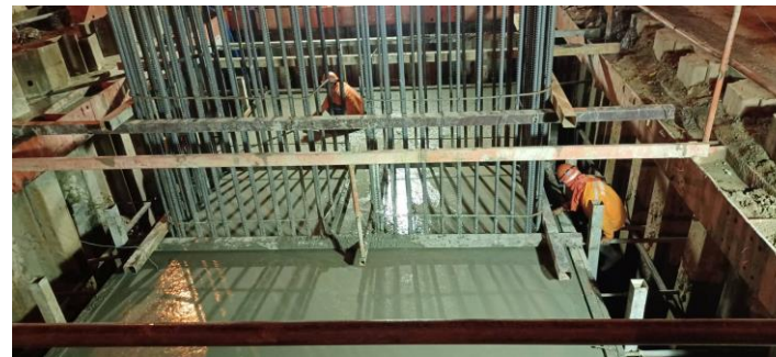
MLP01-24 งานเตรียมเทคอนกรีตฐานราก
