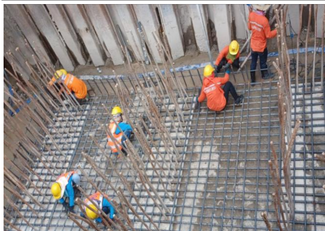
MLP01-22 งานเหล็กเสริมฐานราก
