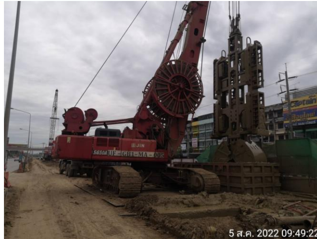
MLP01-30 งานเจาะเสาเข็ม Barrette Pile
