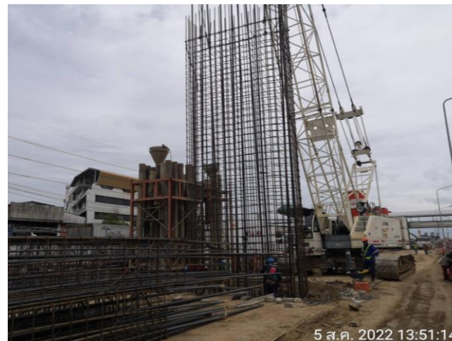
MLP01-29 งานติดตั้งโครงเหล็กเสริม
