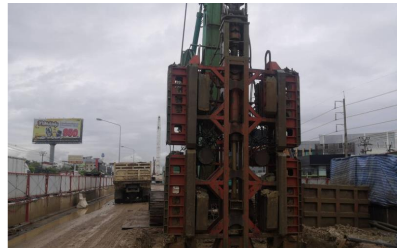
MLP01-28 งานเจาะเสาเข็ม Barrette Pile
