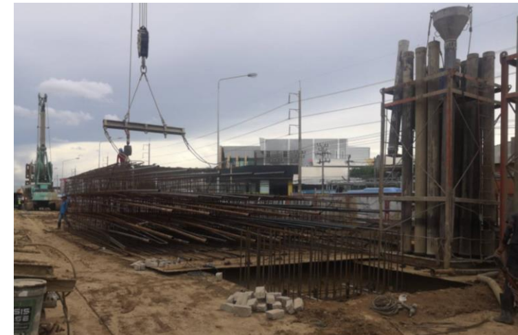
MLP01-28 งานติดตั้งโครงเหล็กเสริม
