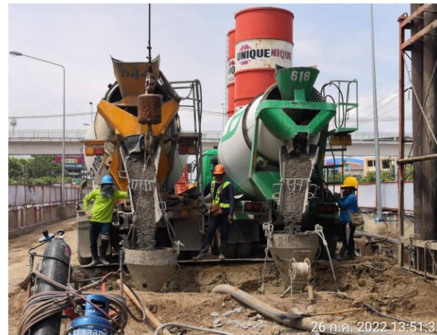
MLP02-05 งานเทคอนกรีต Barrette Pile
