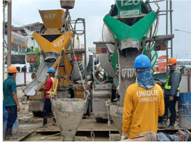
MLP01-23L งานเทคอนกรีต Barrette Pile
