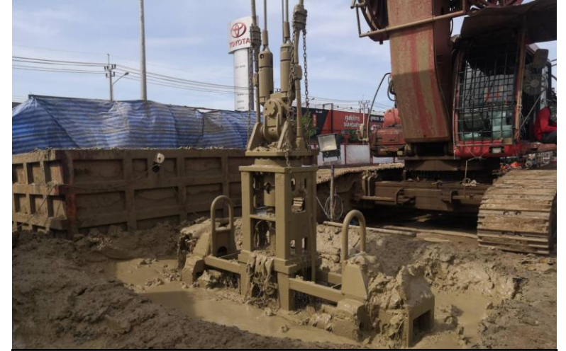
MLP01-15 งานเจาะเสาเข็ม Barrette Pile
