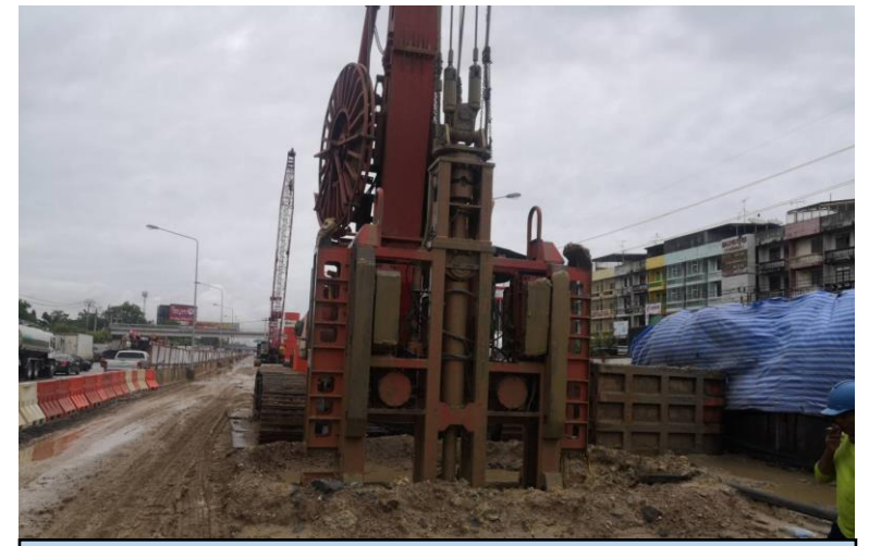
MLP02-02 งานเจาะเสาเข็ม Barrette Pile
