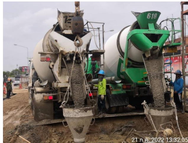
MLP01-31 งานเทคอนกรีต Barrette Pile
