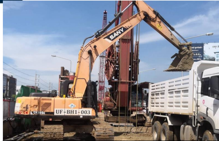
MLP02-05 งานเจาะเสาเข็ม Barrette Pile
