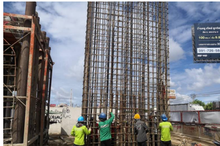
MLP02-02 งานติดตั้งโครงเหล็กเสริม
