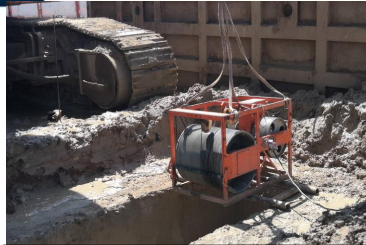
MLP02-04 งาน Drilling monitoring
