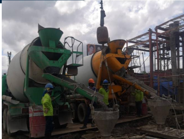
MLP01-15 งานเทคอนกรีต Barrette Pile
