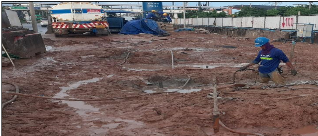
งาน Toe grout Barrette pile MLP05-16C, MLP05-18
