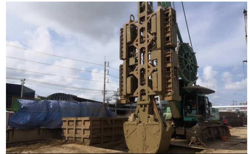
MLP01-30 งานเจาะเสาเข็ม Barrette Pile
