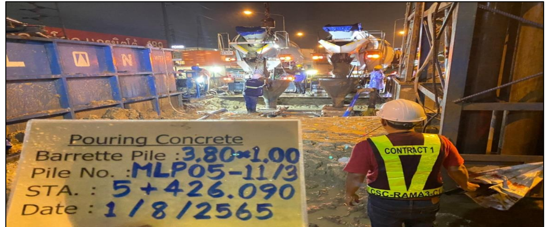
งานเจาะเสาเข็ม Barrette Pile MLP05-11C-BP3
