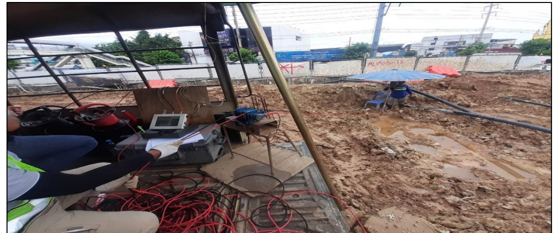
งาน Toe grout Barrette pile MLP05-16C, MLP05-18
