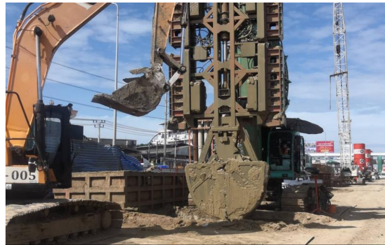
MLP01-31 งานเจาะเสาเข็ม Barrette Pile
