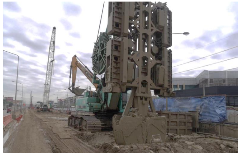
MLP01-29 งานเจาะเสาเข็ม Barrette Pile
