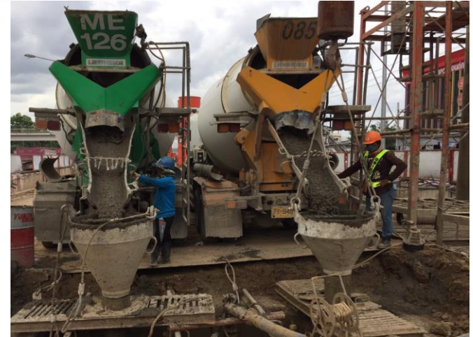
MLP02-04 งานเทคอนกรีต Barrette Pile
