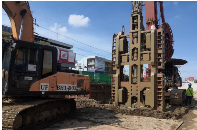
MLP02-03 งานเจาะเสาเข็ม Barrette Pile
