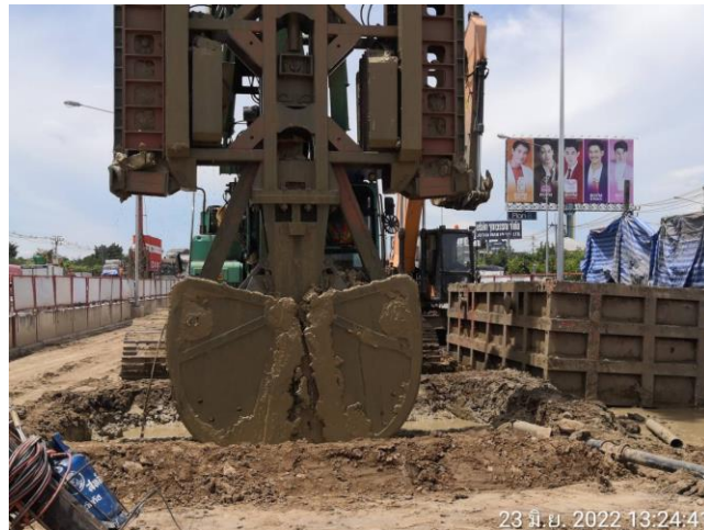
MLP01-11 งานเจาะเสาเข็ม Barrette Pile
