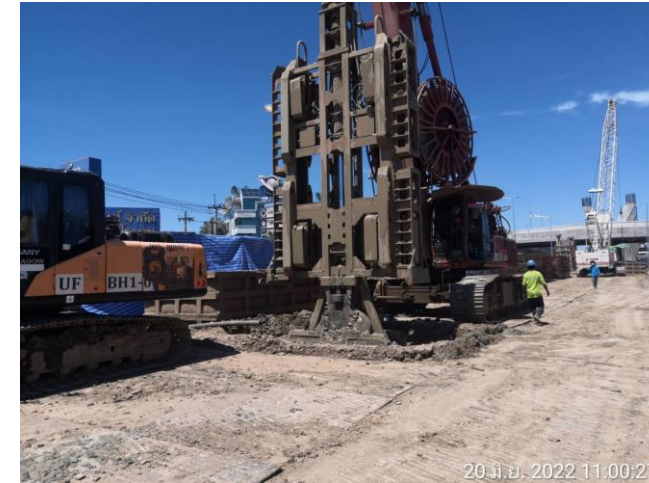
MLP01-07 งานเจาะเสาเข็ม Barrette Pile
