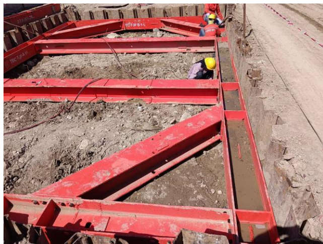
MLP01-22 ติดตั้ง Bracing
