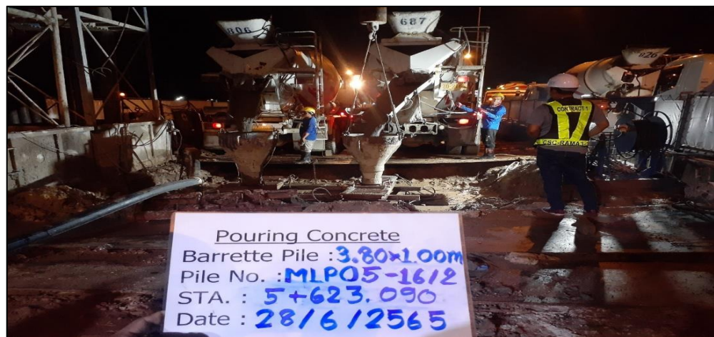
งานเจาะเสาเข็ม Barrette Pile MLP05-16C-BP1,2
