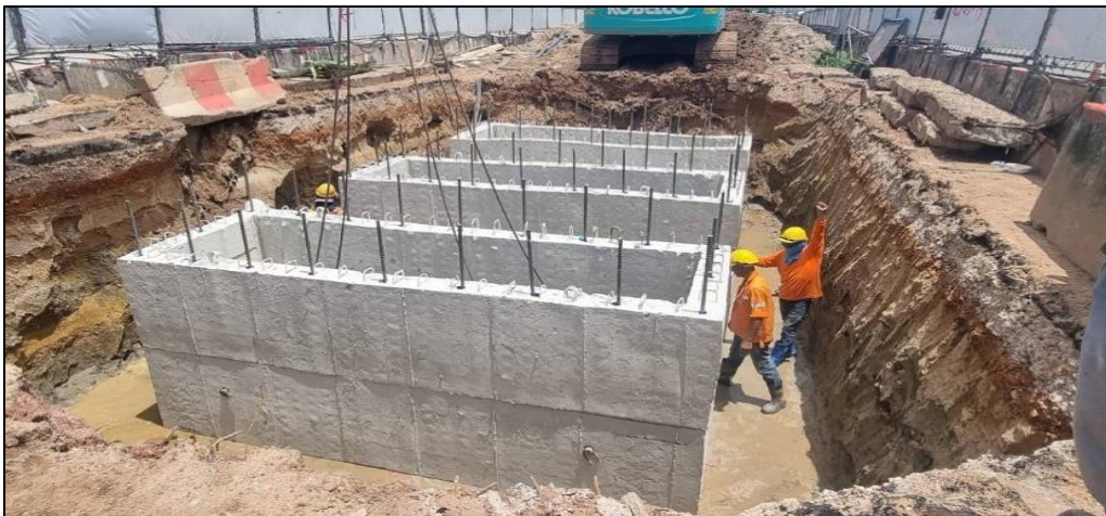
งานหล่อ Guide wall MLP05-12C
