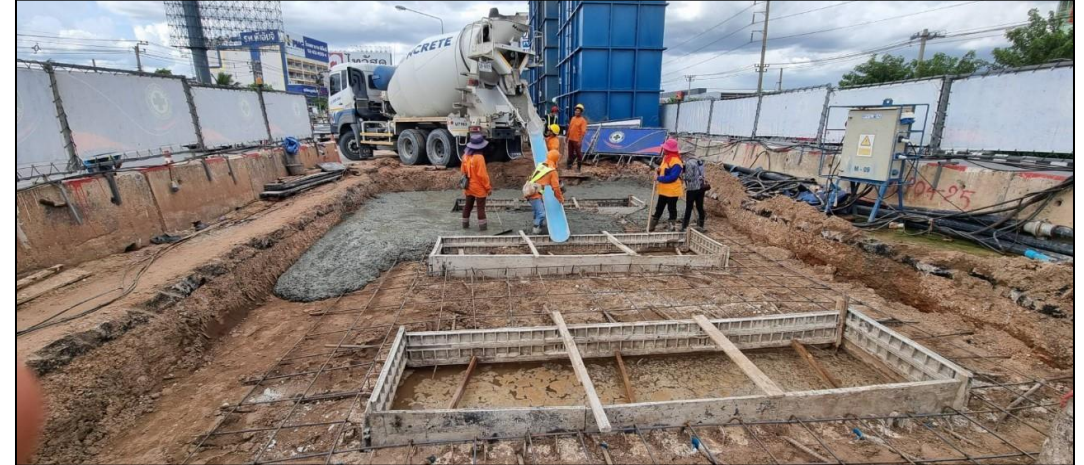
งานหล่อ Guide wall MLP04-25C
