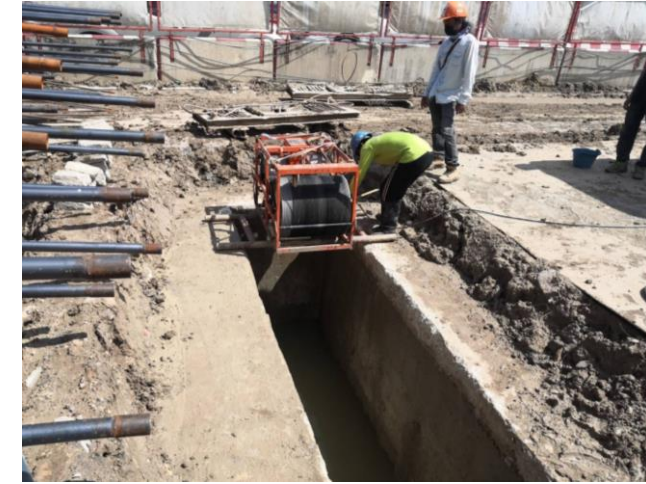
MLP01-03 งาน Drilling monitoring
