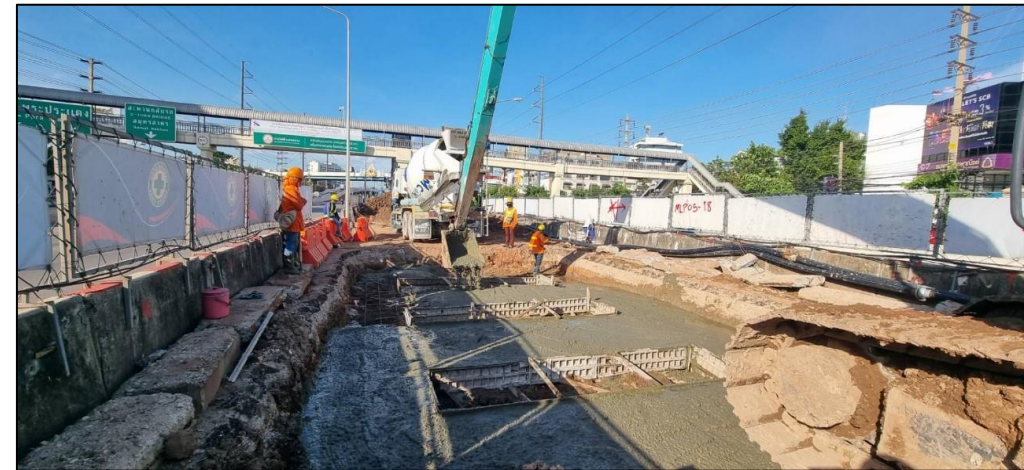
งานหล่อ Guide wall MLP05-18C
