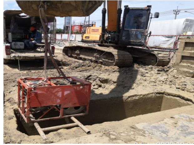
MLP01-07 งาน Drilling monitoring
