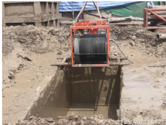
MLP01-11 งาน Drilling monitoring
