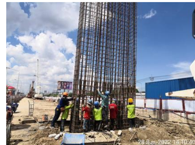
MLP01-05 งานติดตั้งโครงเหล็กเสริม
