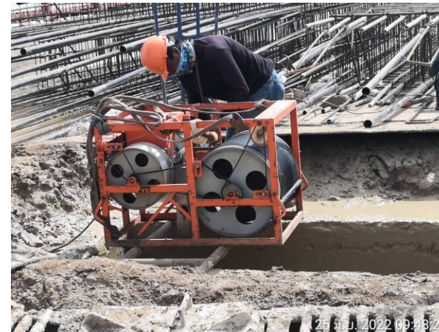
MLP01-11 งาน Drilling monitoring
