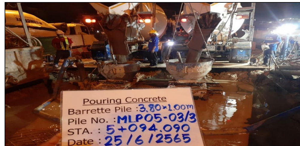
งานเจาะเสาเข็ม Barrette Pile MLP05-03C-BP3
