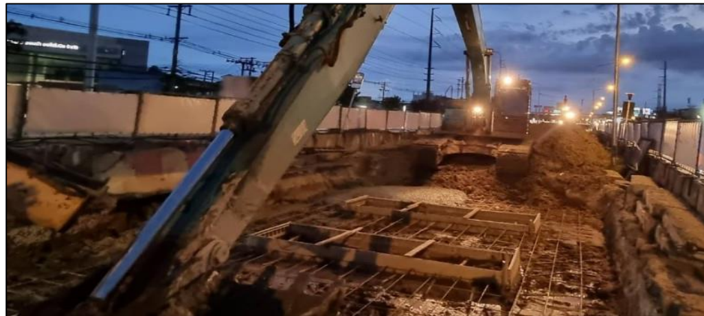
งานหล่อ Guide wall MLP04-30C
