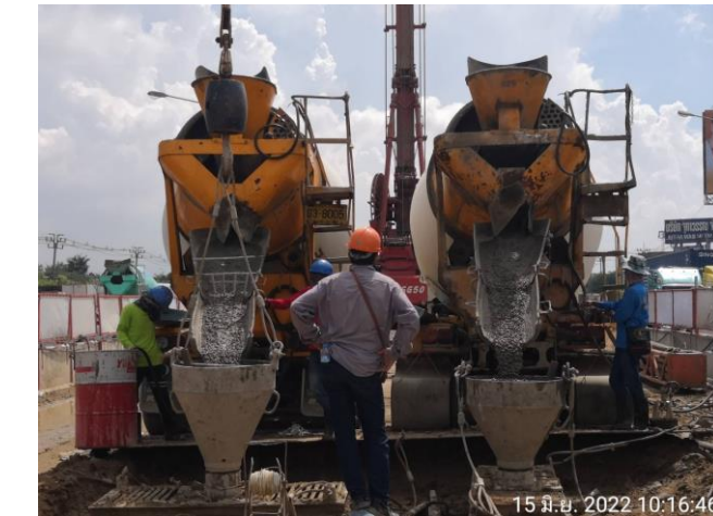
MLP01-11 งานเทคอนกรีต Barrette Pile
