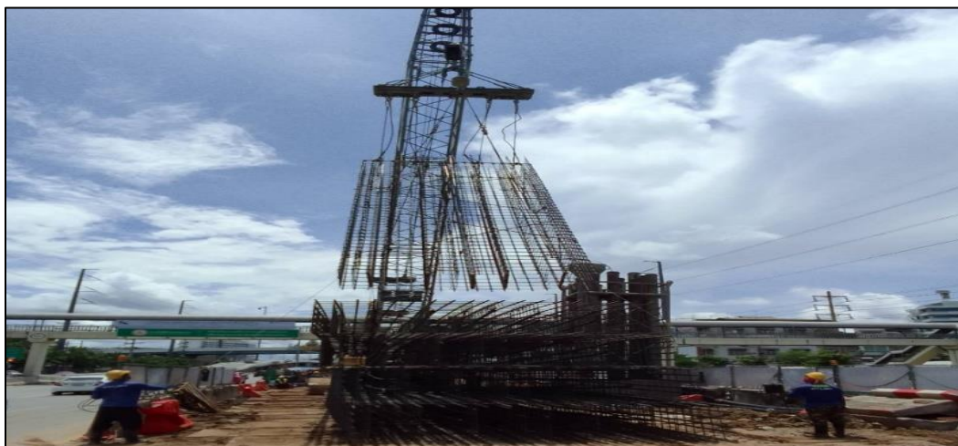
งานเจาะเสาเข็ม Barrette Pile MLP05-19C-BP1
