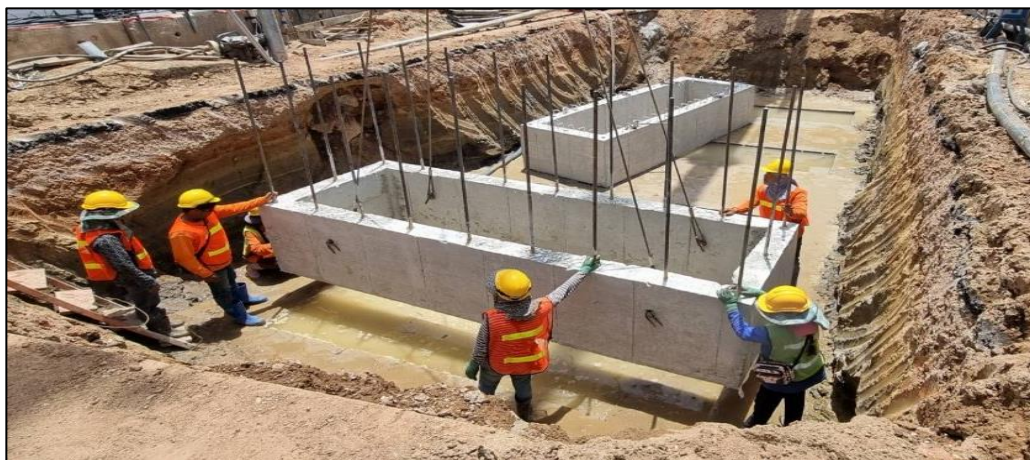
งานหล่อ Guide wall MLP04-30C
