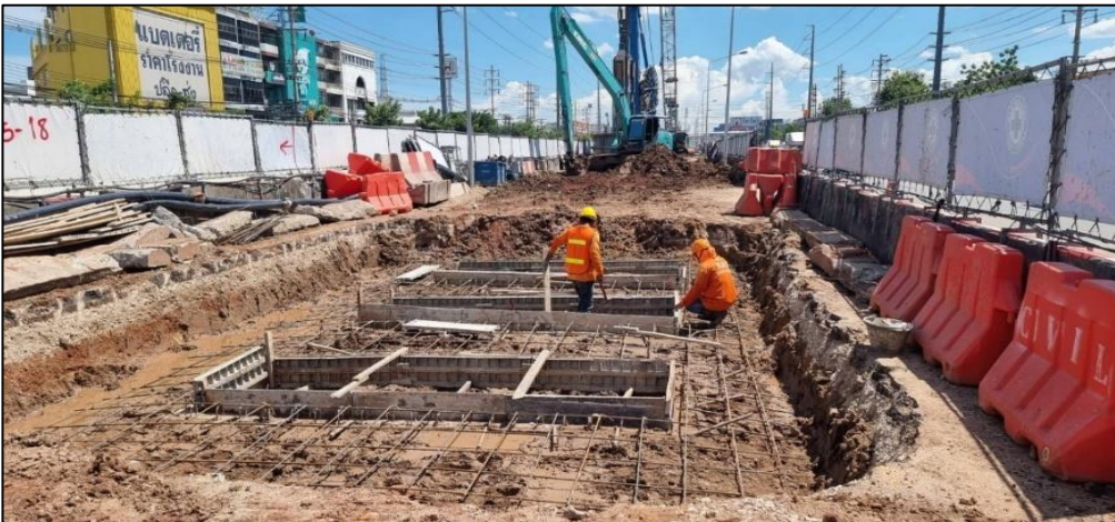
งานหล่อ Guide wall MLP05-18C
