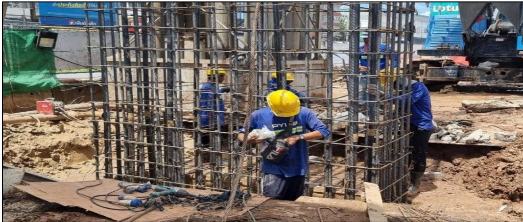
งานเจาะเสาเข็ม Barrette Pile MLP04-18C-BP2
