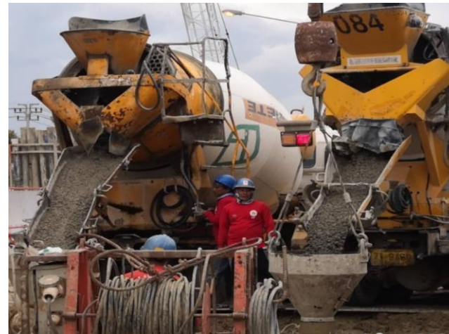
MLP01-07 งานเทคอนกรีต Barrette Pile
