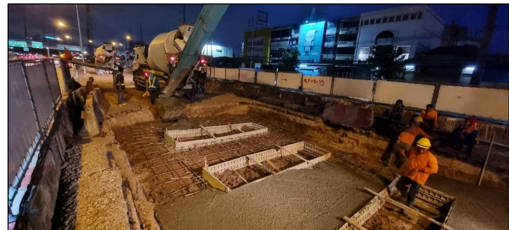
งานหล่อ Guide wall MLP05-14C
