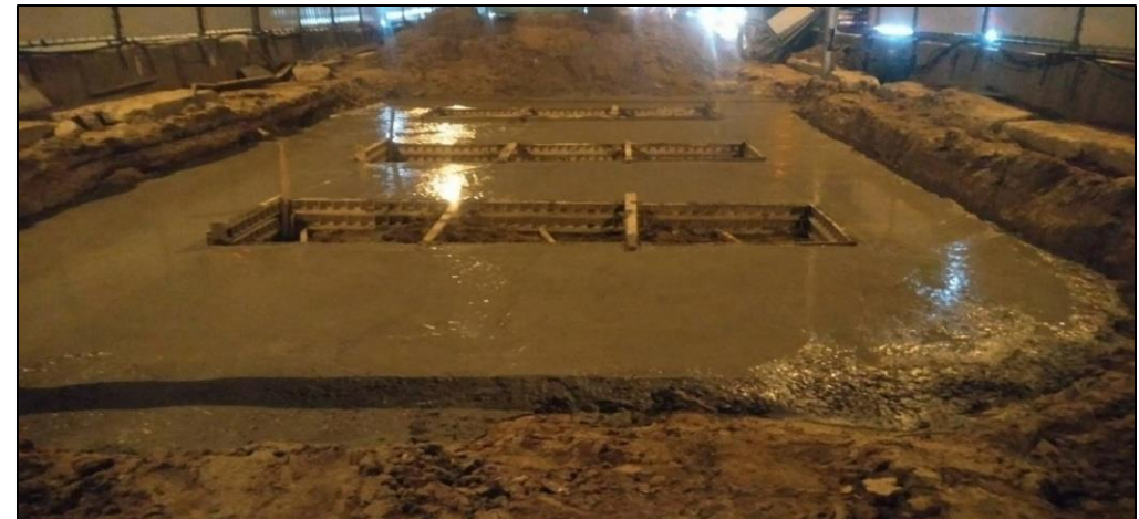
งานหล่อ Guide wall MLP05-13C
