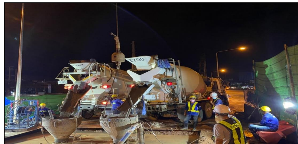
งานเจาะเสาเข็ม Barrette Pile MLP05-16C-BP1,2
