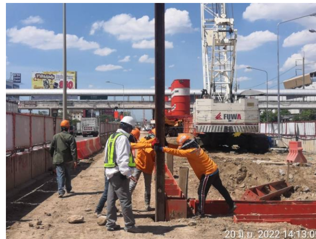
MLP01-24 งานปัก Sheet Pile
