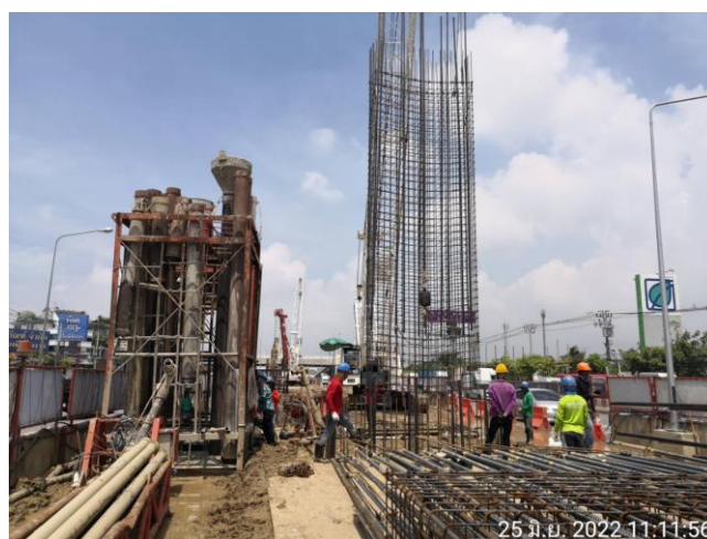
MLP01-11 งานติดตั้งโครงเหล็กเสริม
