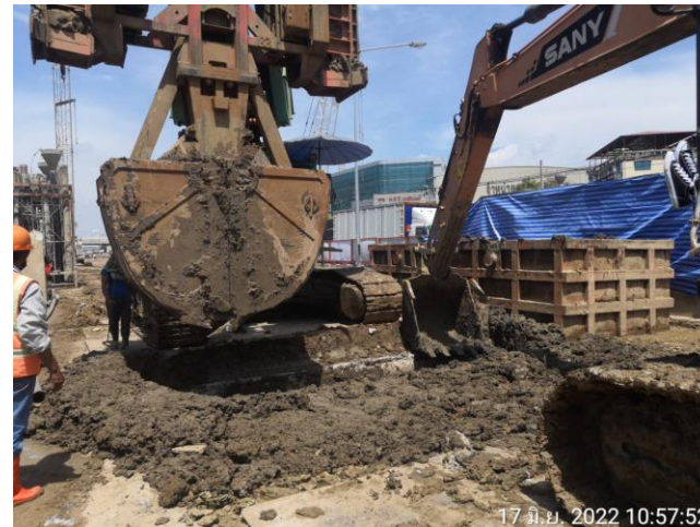
MLP01-15 งานเจาะเสาเข็ม Barrette Pile
