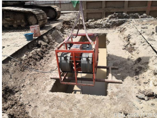
MLP01-13 งาน Drilling monitoring
