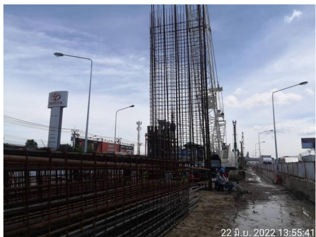
MLP01-15 งานติดตั้งโครงเหล็กเสริม
