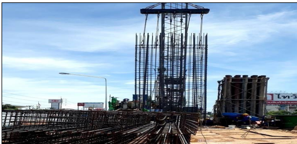
งานเจาะเสาเข็ม Barrette Pile MLP05-03C-BP3
