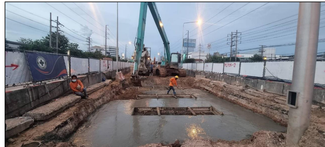
งานหล่อ Guide wall MLP05-12C
