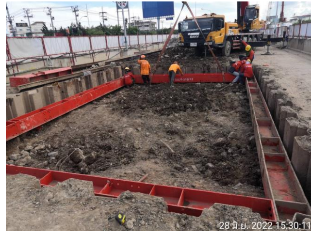
MLP01-05 ติดตั้ง Bracing
