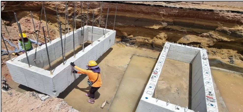
งานหล่อ Guide wall MLP05-14C
