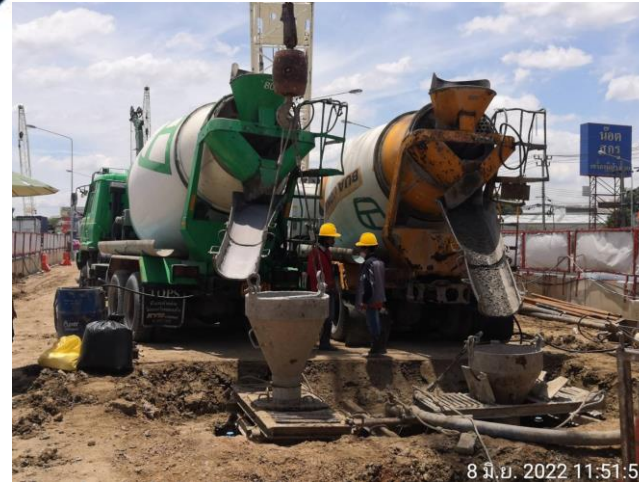
MLP01-03 งานเทคอนกรีต Barrette Pile
