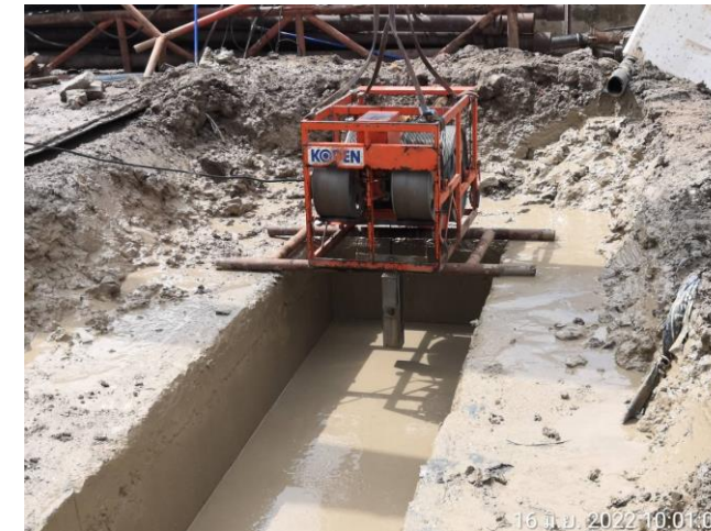
MLP01-03 งาน Drilling monitoring
