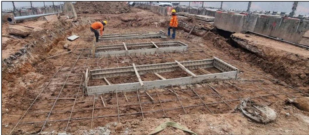
งานหล่อ Guide wall MLP04-25C
