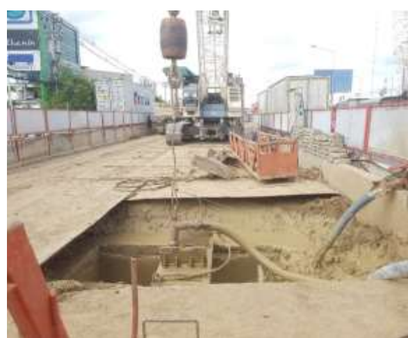
MLP01-07L ทำความสะอาดหลุมเจาะ (De-sanding)
