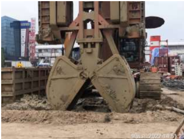
MLP01-24งานเจาะเสาเข็ม Barrette Pile
