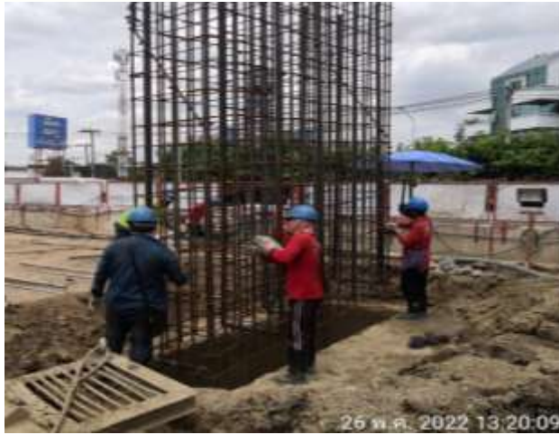
MLP01-03 งานติดตั้งโครงเหล็กเสริม
