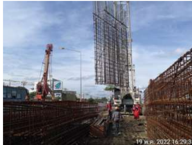
MLP01-03 งานติดตั้งโครงเหล็กเสริม
