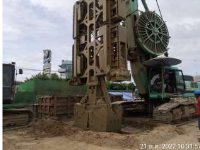
MLP01-05 งานเจาะเสาเข็ม Barrette Pile
