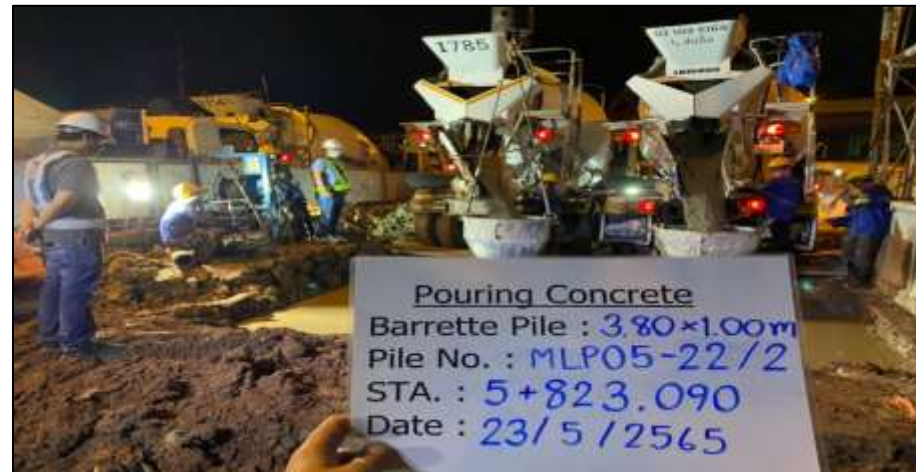
งานเจาะเสาเข็ม Barrette Pile MLP05-22C
