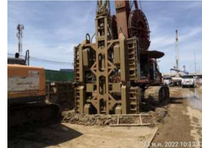
MLP01-09 งานเจาะเสาเข็ม Barrette Pile
