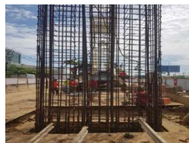
MLP01-07L งานติดตั้งโครงเหล็กเสริม
