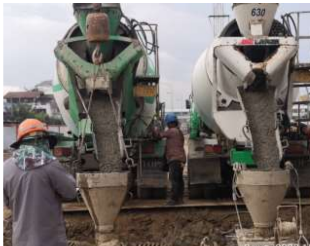
MLP01-20 งานเทคอนกรีต Barrette Pile
