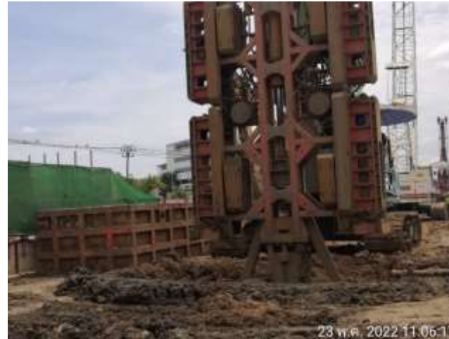
MLP01-03 งานเจาะเสาเข็ม Barrette Pile
