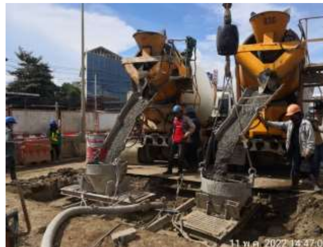
MLP01-24 งานเทคอนกรีต Barrette Pile
