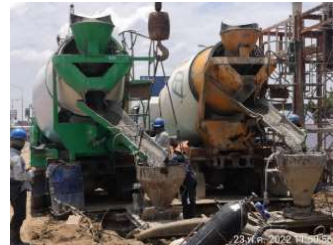
MLP01-05 งานเทคอนกรีต Barrette Pile
