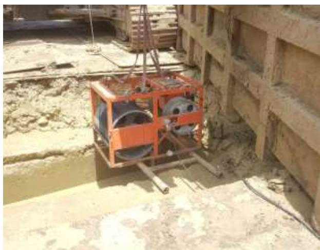
MLP01-05L งาน Drilling monitoring
