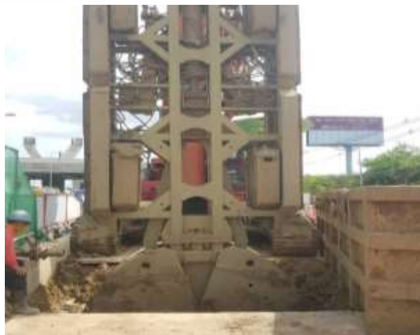
MLP01-05L งานเจาะเสาเข็ม Barrette Pile
