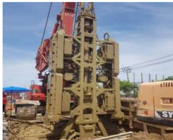
MLP01-07L งานเจาะเสาเข็ม Barrette Pile
