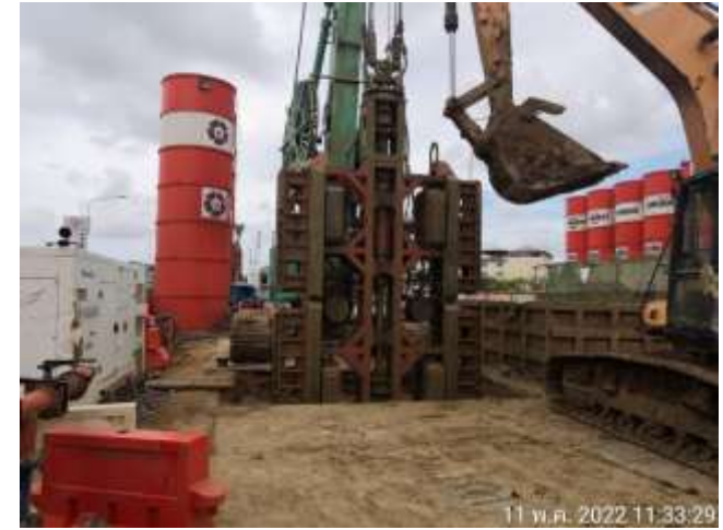
MLP01-18 งานเจาะเสาเข็ม Barrette Pile
