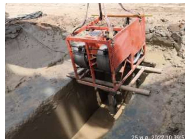
MLP01-07L งาน Drilling monitoring
