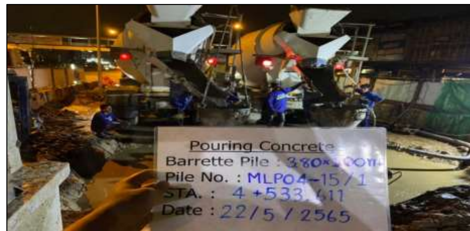
งานเจาะเสาเข็ม Barrette Pile MLP04-15C-BP4
