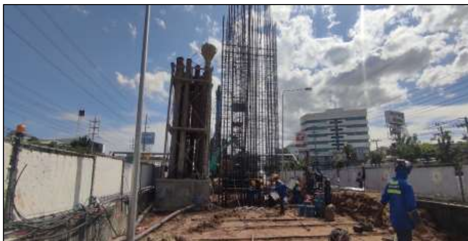
งานเจาะเสาเข็ม Barrette Pile MLP05-22C
