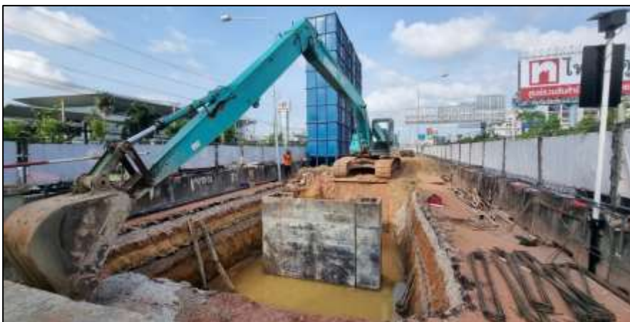
งานหล่อ Guide wall MLP05-01
