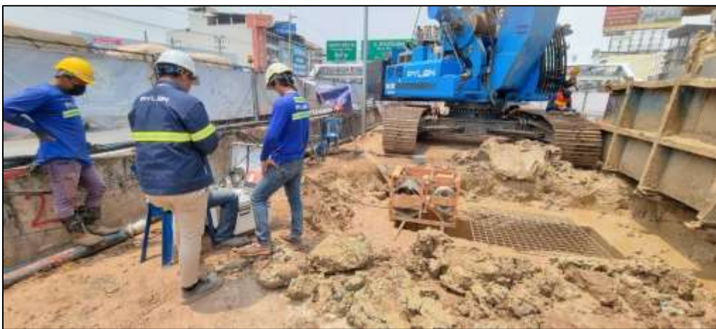
งานเจาะเสาเข็ม Barrette Pile MLP4-23 (1)
