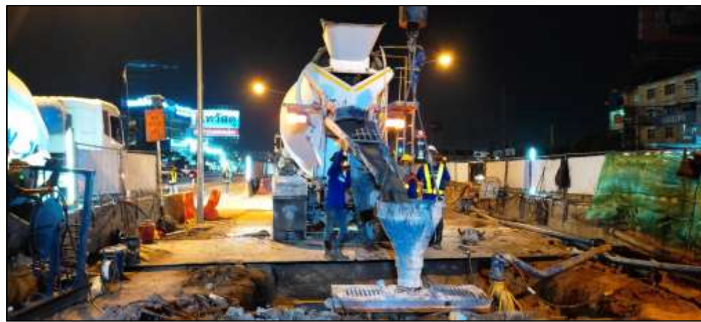
งานเจาะเสาเข็ม Barrette Pile MLP4-23 (1)
