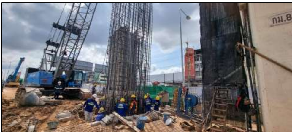
งานเจาะเสาเข็ม Barrette Pile MLP04-19 (1)
