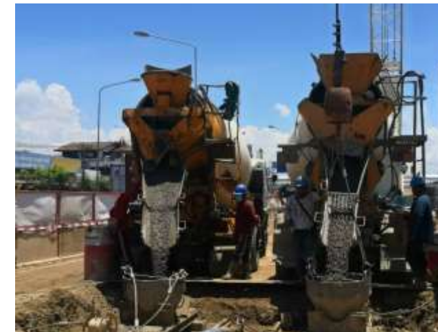
MLPO1-22 งานเทคอนกรีต Barrette Pile
