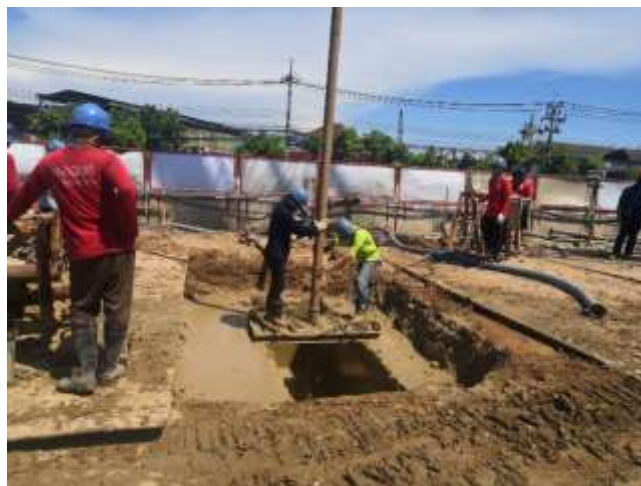
MLP01-16 ทำความสะอาดหลุมเจาะ (De-sanding)
