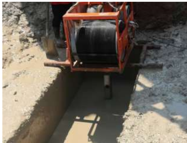
MLP01-18 งาน Drilling monitoring
