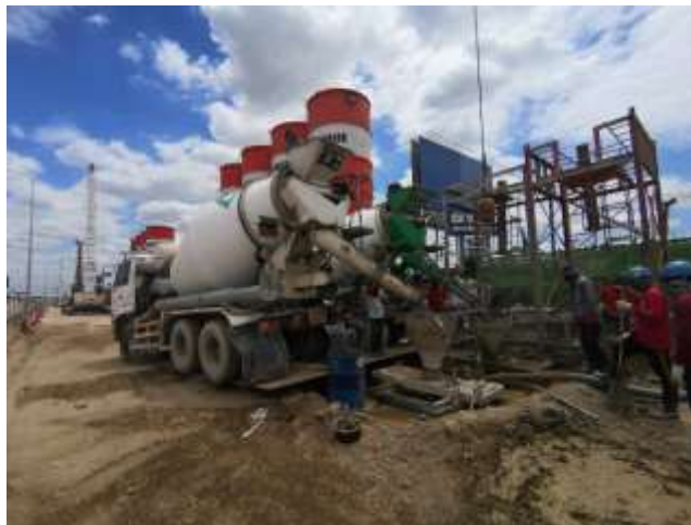
MLPO1-17 งานเทคอนกรีต Barrette Pile
