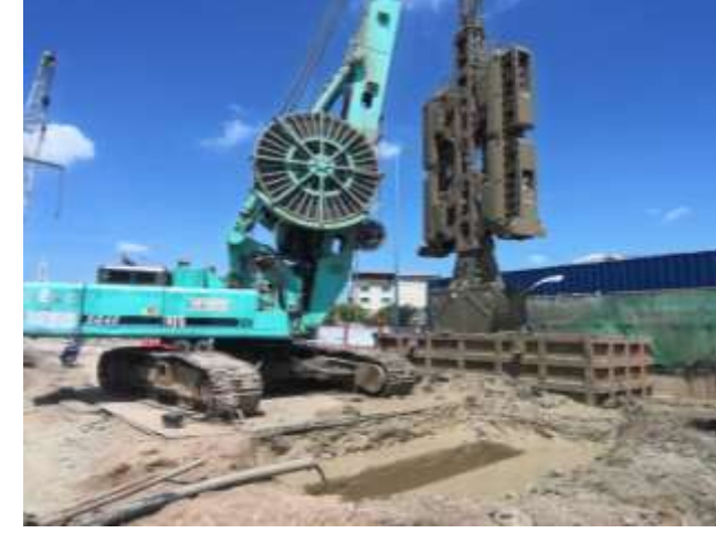
MLP01-16 งานเจาะเสาเข็ม Barrette Pile
