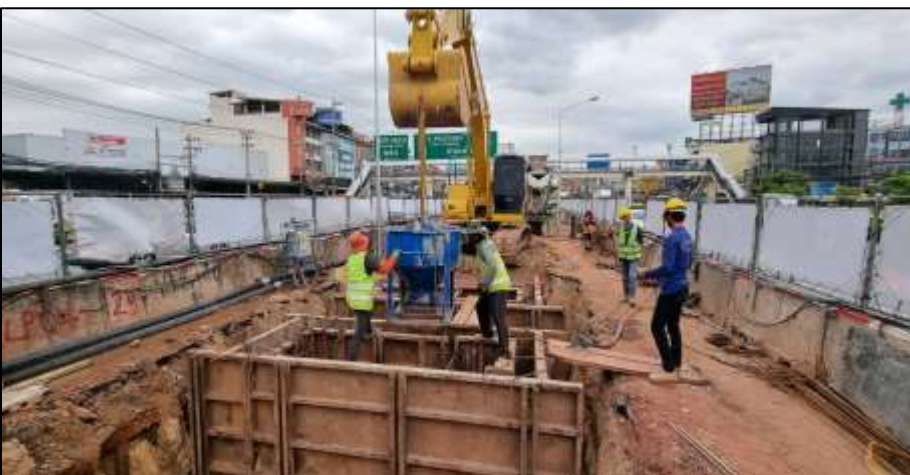
งานหล่อ Guide wall MLP04-23
