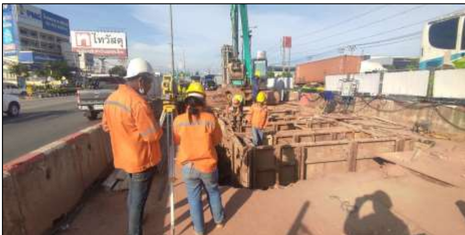
งานหล่อ Guide wall MLP04-27
