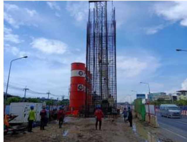
MLP01-18งานติดตั้งโครงเหล็กเสริม
