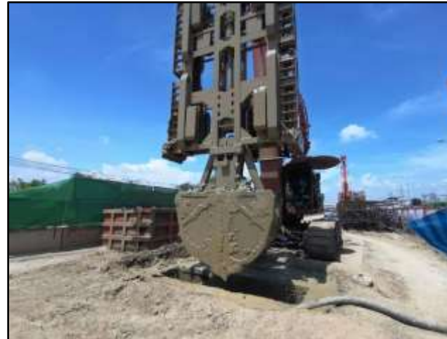
MLP01-19 งานเจาะเสาเข็ม Barrette Pile
