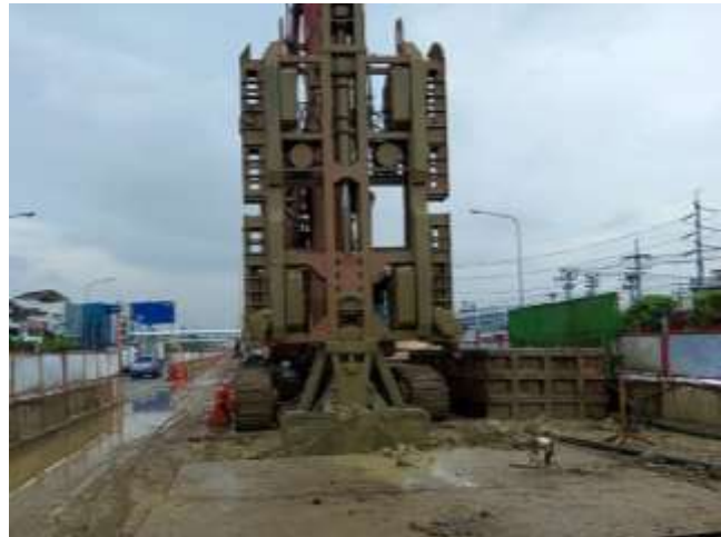
MLP01-21งานเจาะเสาเข็ม Barrette Pile
