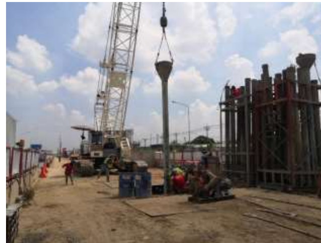
MLPO1-04 ติดตั้ง tremie pipe
