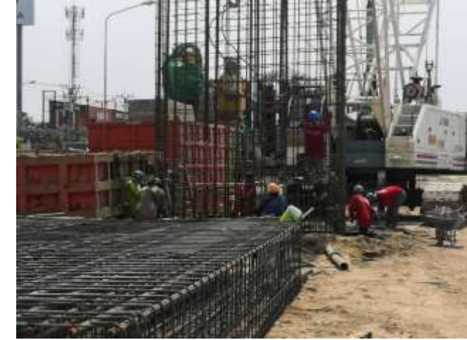
MLP01-19 งานติดตั้งโครงเหล็กเสริม
