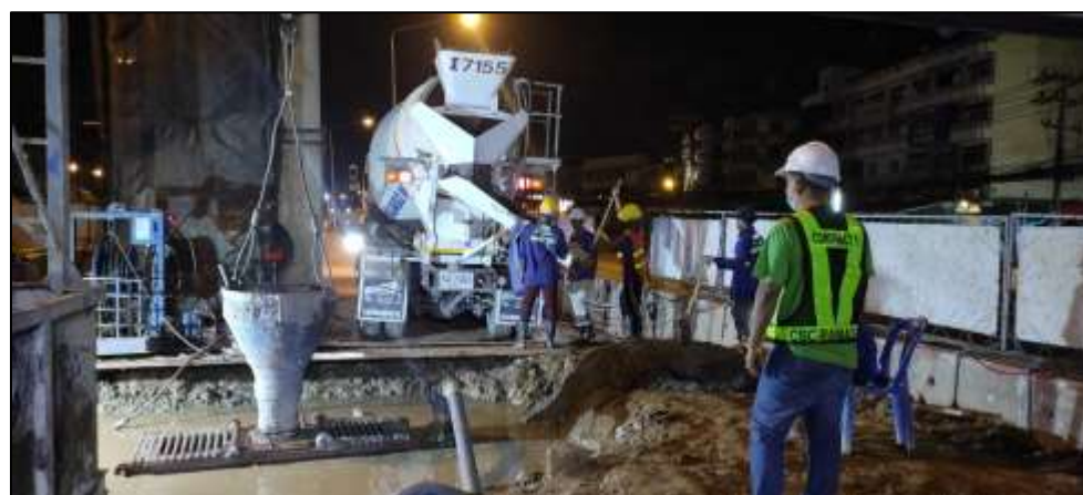
งานเจาะเสาเข็ม Barrette Pile MLP04-19 (1)
