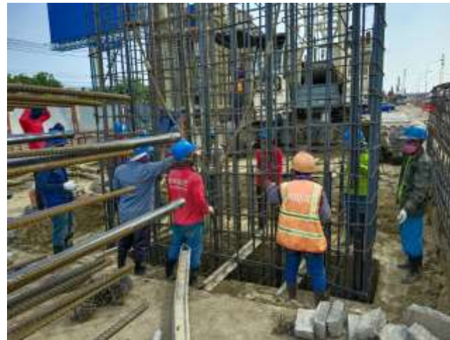
MLP01-20 งานติดตั้งโครงเหล็กเสริม
