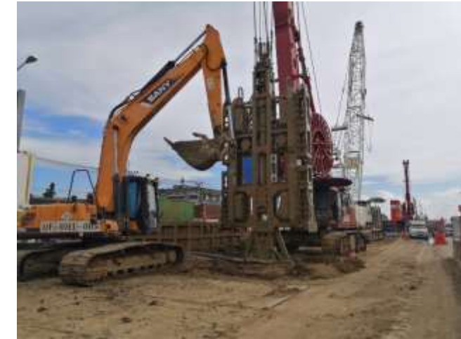
MLP01-22 งานเจาะเสาเข็ม Barrette Pile
