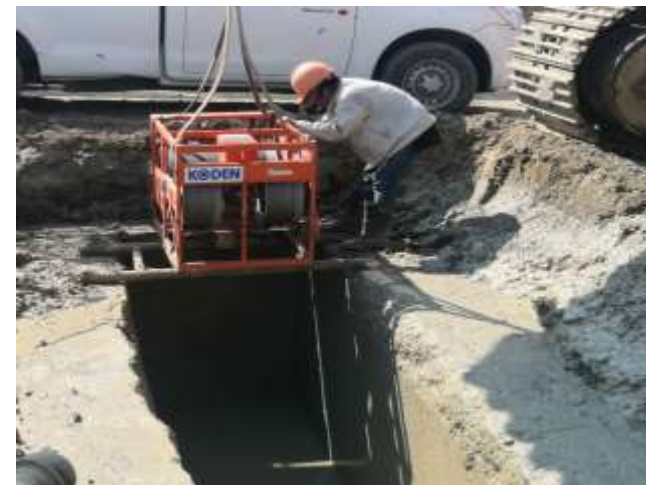
MLP01-21 งาน Drilling monitoring
