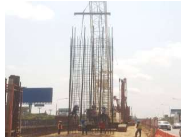
MLP01-24 งานติดตั้งโครงเหล็กเสริม
