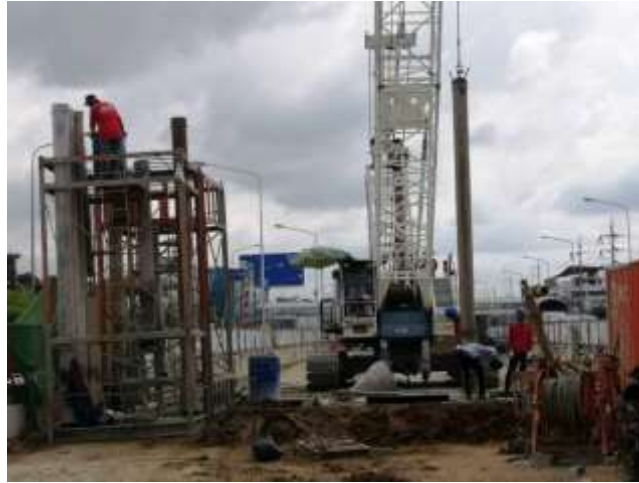
MLPO1-09 ติดตั้ง tremie pipe
