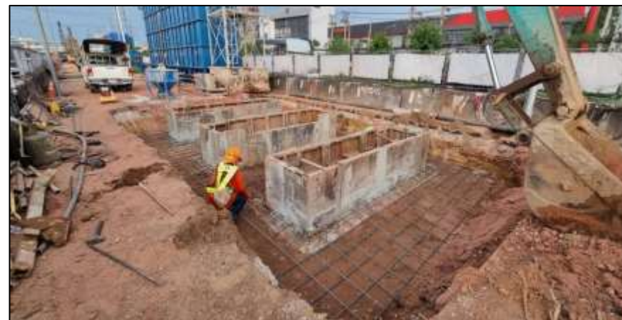
งานหล่อ Guide wall MLP05-01
