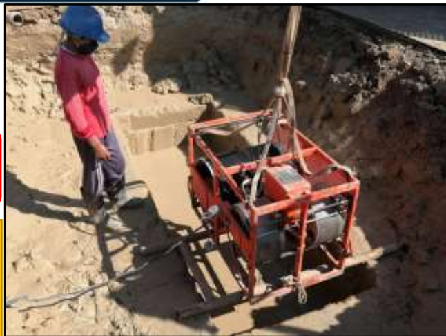
MLP01-04 งาน Drilling monitoring
