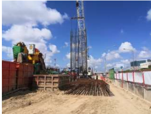
MLP01-16 งานติดตั้งโครงเหล็กเสริม
