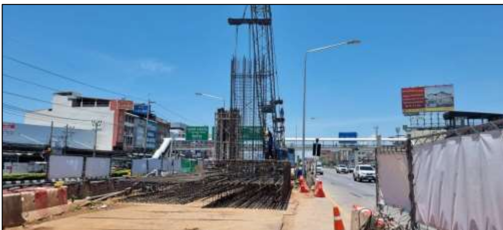
งานเจาะเสาเข็ม Barrette Pile MLP4-23 (2)
