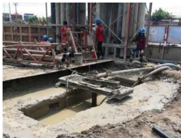
MLP01-19 ทำความสะอาดหลุมเจาะ (De-sanding)
