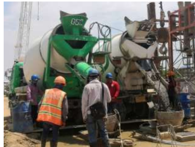
MLPO1-19 งานเทคอนกรีต Barrette Pile
