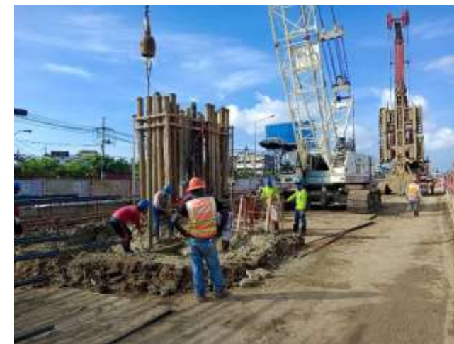
MLP01-23 ทำความสะอาดหลุมเจาะ (De-sanding)
