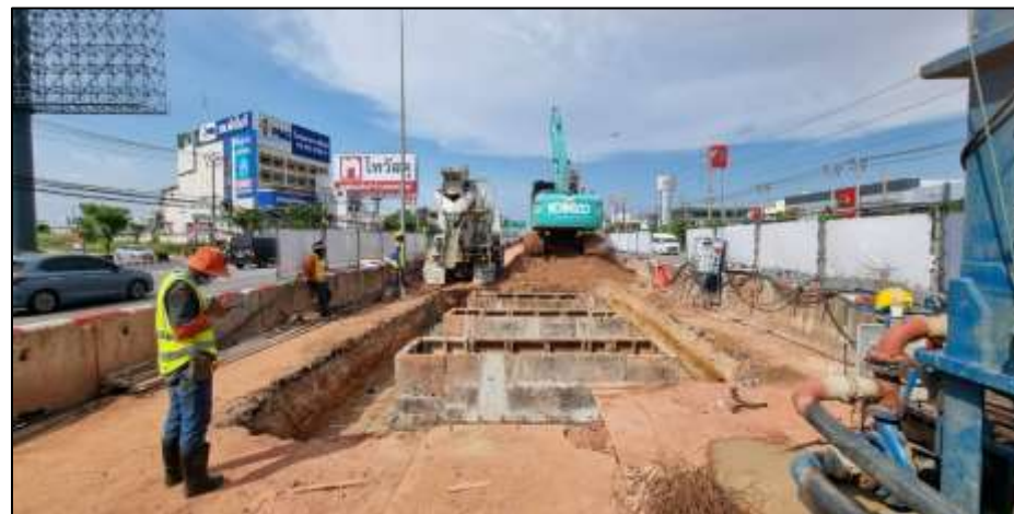
งานหล่อ Guide wall MLP04-27
