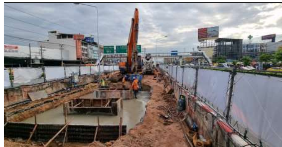
งานหล่อ Guide wall MLP04-23
