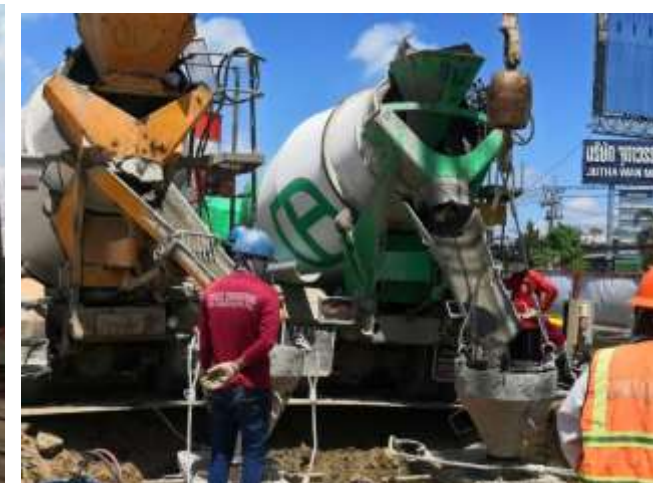
MLPO1-16 งานเทคอนกรีต Barrette Pile
