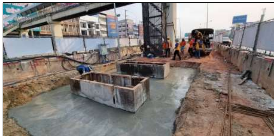
งานหล่อ Guide wall MLP04-19
