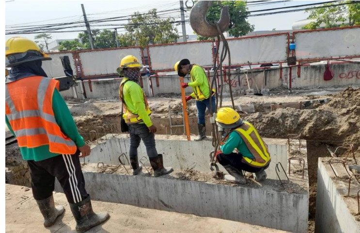
MLP02-13L งานติดตั้ง Guide Wall
