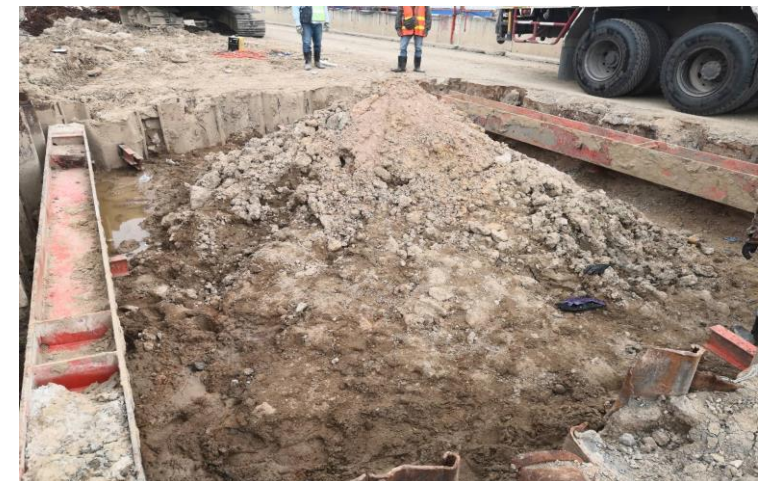
MLP01-23L งานติดตั้ง Bracing Footing
