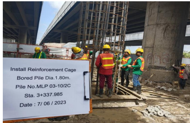
MLP03-10/2C งานติดตั้งเหล็กเสริม Bored Pile
