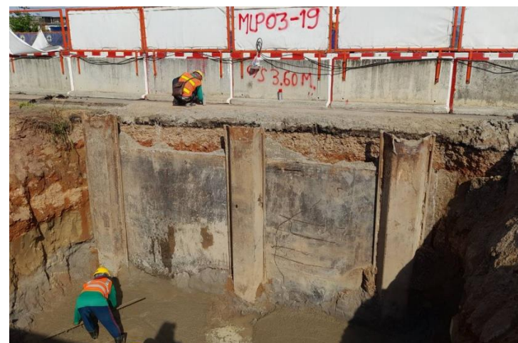
MLP03-19L งานเทคอนกรีต Lean Guide Wall
