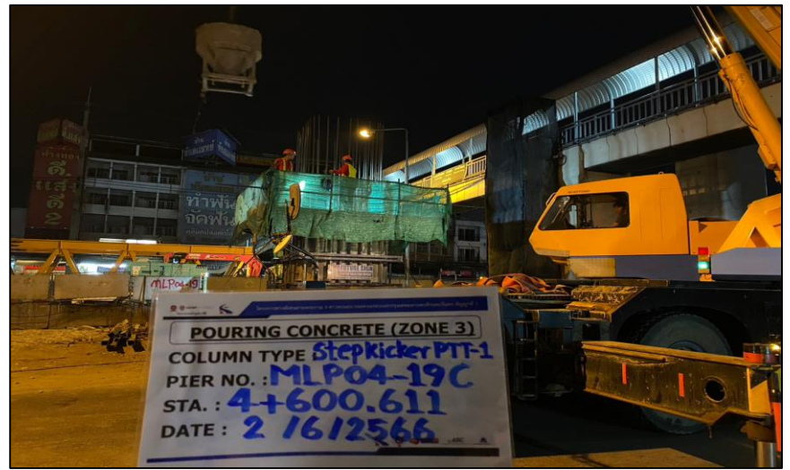
Pouring Concrete Column Pier Type PTT-1 Step 1 MLP04-19C
