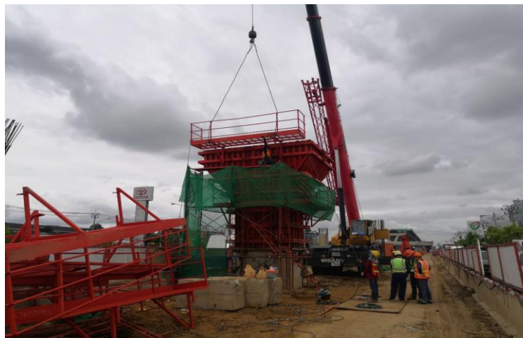
RON1-21 งานติดตั้ง Formwork Column S5
