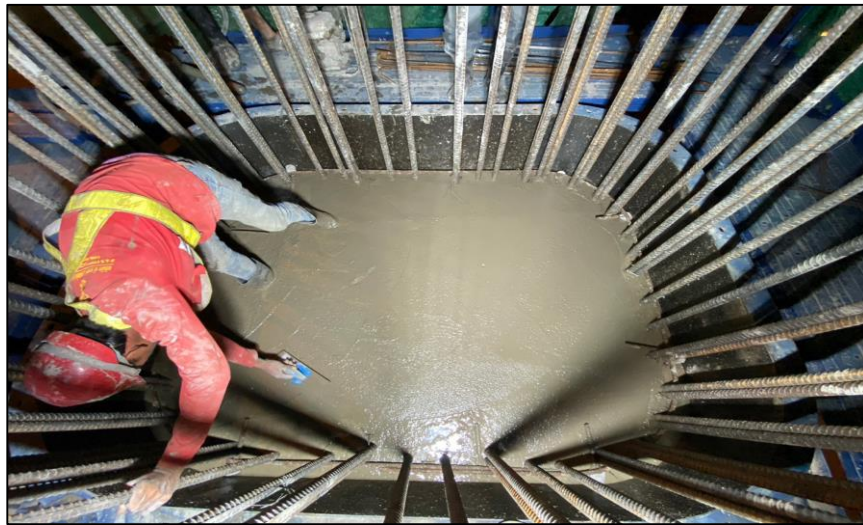
Pouring Concrete Column Pier Type PTT-1 Step 1 MLP04-19C
