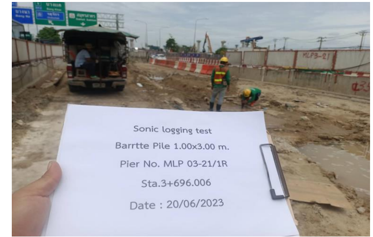
MLP02-21/1R งาน Sonic logging test Barrette Pile
