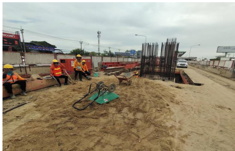
MLP01-11C งาน Backfill sand Footing
