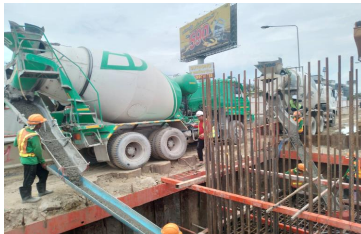
MLP01-31C งานเทคอนกรีต Footing
