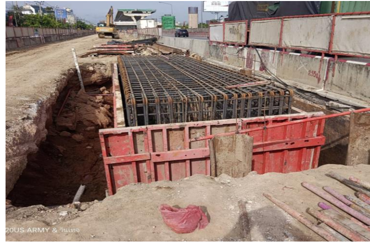
MLP01-14R งานติดตั้ง Formwork Footing
