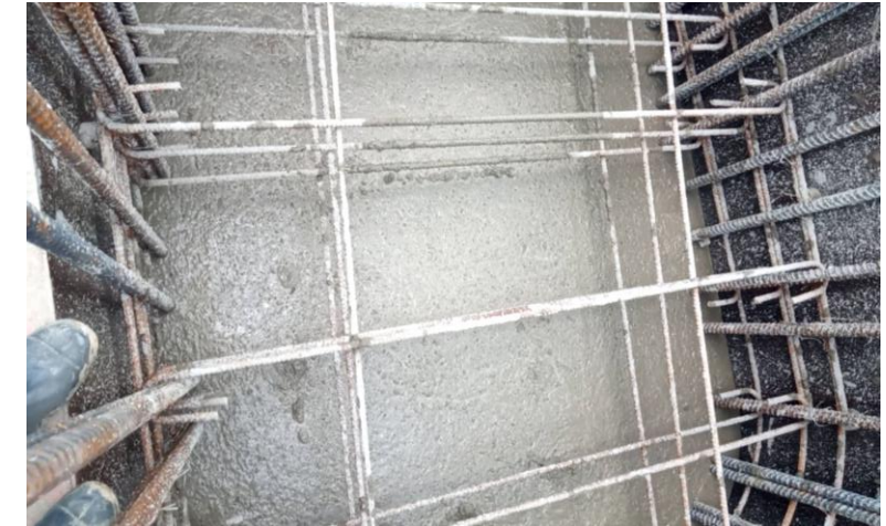
MLP01-06C งานเทคอนกรีต Column PTT-1 Step2
