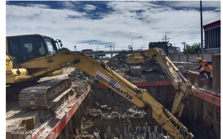
MLP02-03C งาน Excavation Footing
