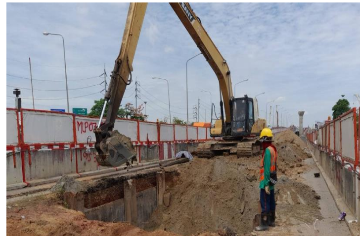
MLP03-19L งาน Excavation Guide Wall
