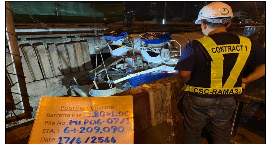
Pouring concrete Barrette pile MLP06-07C/1
