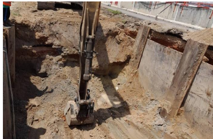
MLP03-18L งาน Excavation Guide Wall
