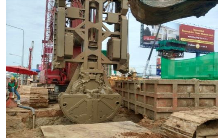
MLP02-26/3C งานเจาะเสาเข็ม Barrette Pile
