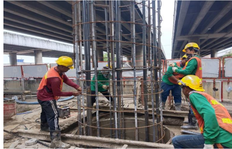
MLP03-10/1C งานติดตั้งเหล็กเสริม Bored Pile
