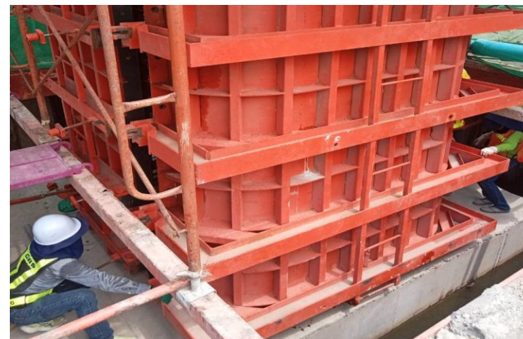
RON1-22 งานติดตั้ง Formwork Column S5
