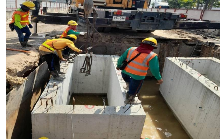
MLP02-14L งานติดตั้ง Guide Wall
