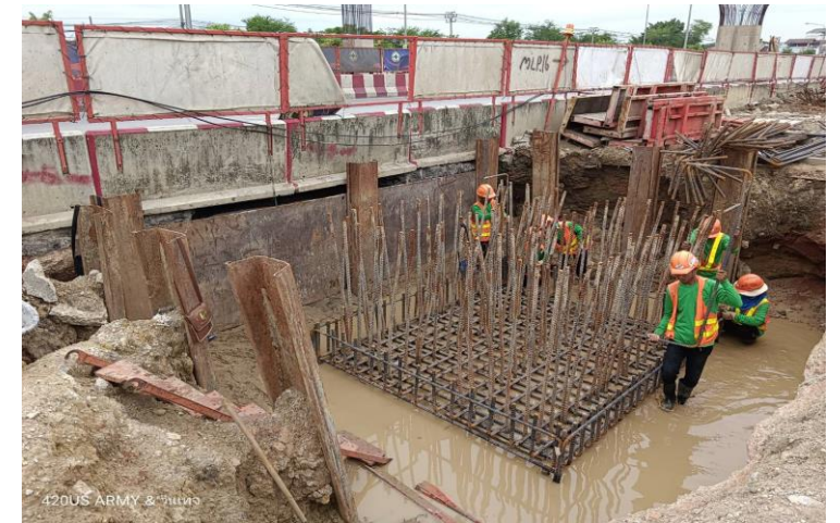
MLP01-15R งานติดตั้งเหล็กเสริม Footing
