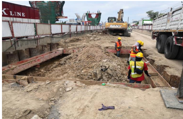
MLP01-23L งานติดตั้ง Bracing Footing
