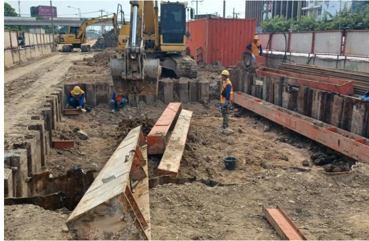
MLP02-03C งานติดตั้ง Bracing Footing
