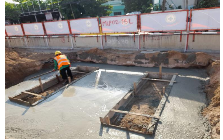
MLP02-15L งานเทคอนกรีต Top Slab Guide Wall
