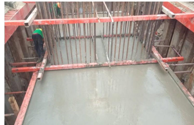
MLP01-31C งานเทคอนกรีต Footing
