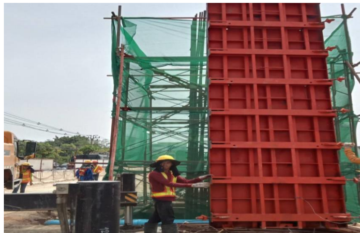
RON1-22 งานติดตั้ง Formwork Column S5
