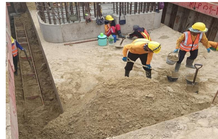
MLP01-11C งาน Backfill sand Footing
