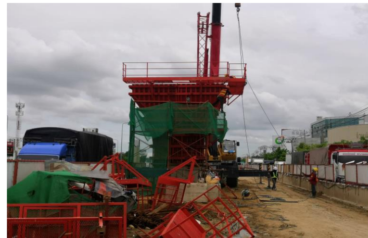
RON1-21 งานติดตั้ง Formwork Column S5
