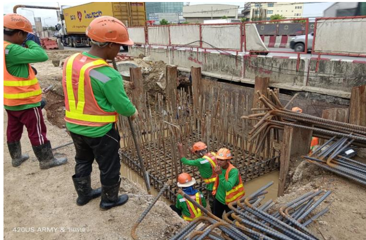
MLP01-15R งานติดตั้งเหล็กเสริม Footing
