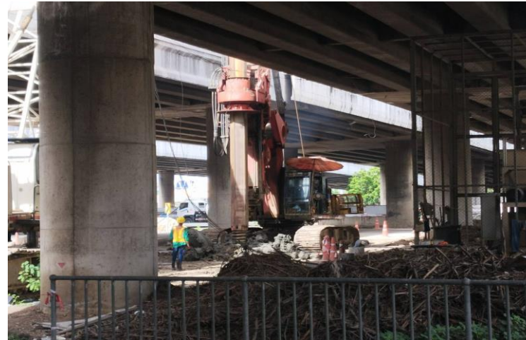
MLP03-10/1C งานเจาะเสาเข็ม Bored Pile
