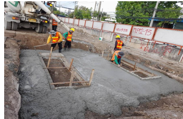
MLP02-13R งานเทคอนกรีต Top Slab Guide Wall
