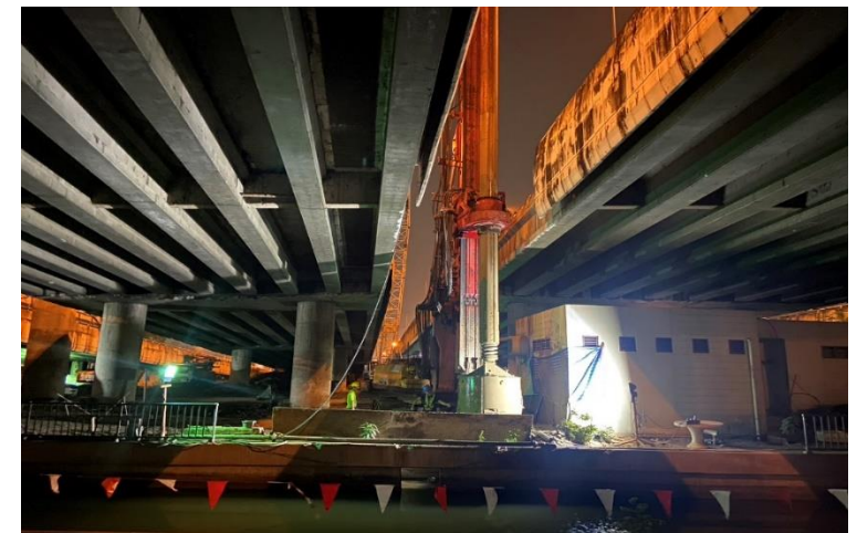
MLP03-12/1C งานเจาะเสาเข็ม Bored Pile
