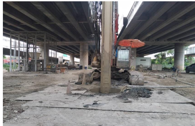
MLP03-10/2C งานเจาะเสาเข็ม Bored Pile
