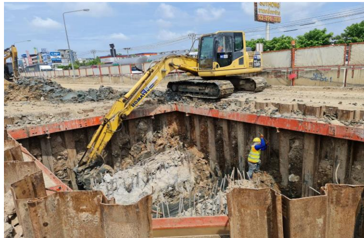
MLP02-01C งาน Excavation Footing
