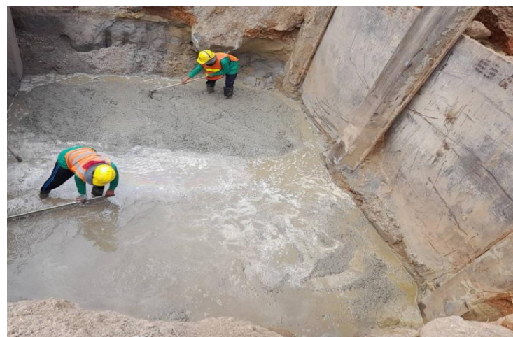
MLP03-18L งานเทคอนกรีต Lean Guide Wall
