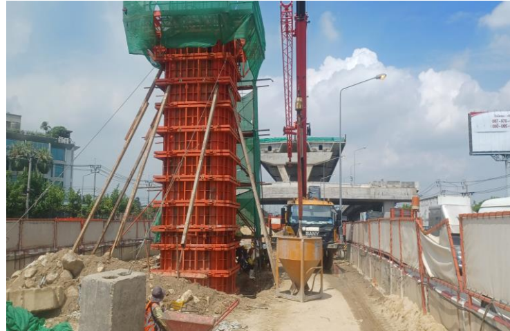
MLP01-06C งานเทคอนกรีต Column PTT-1 Step2
