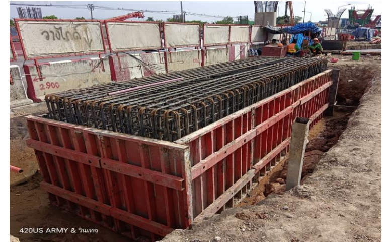
MLP01-14R งานติดตั้ง Formwork Footing
