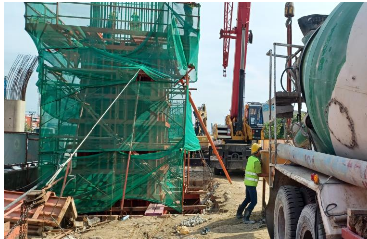
RON1-22 งานเทคอนกรีต Column S5 Step1
