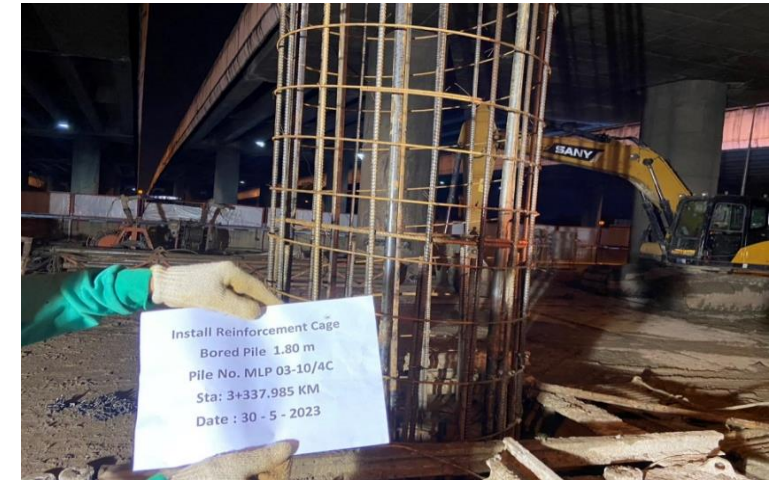
MLP03-10/4C งานติดตั้งเหล็กเสริม Bored Pile
