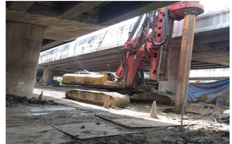
MLP03-10/3C งานเจาะเสาเข็ม Bored Pile
