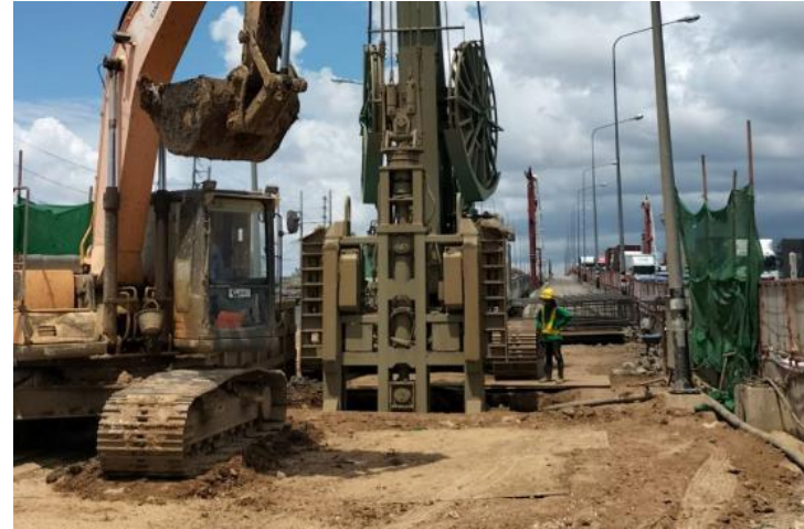
MLP03-22/1R งานเจาะเสาเข็ม Barrette Pile
