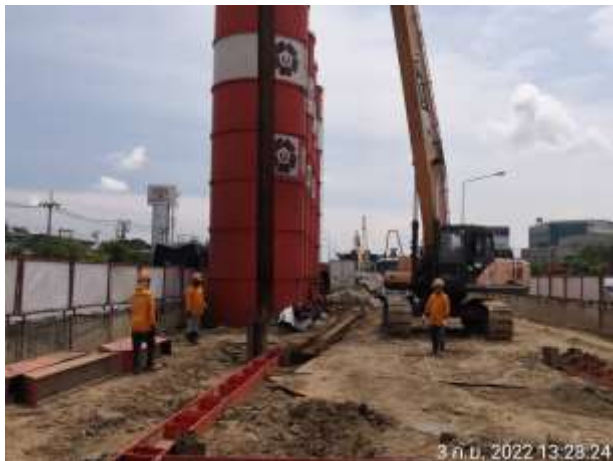
MLP01-18 งานปัก Sheet Pile และ ติดตั้ง Bracing
