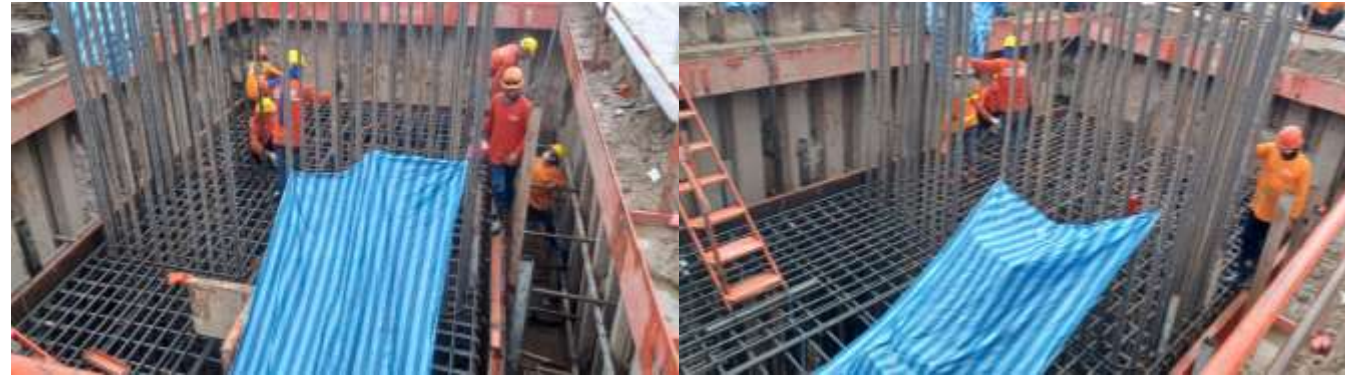
MLP01-23 งานเหล็กเสริมฐานราก
