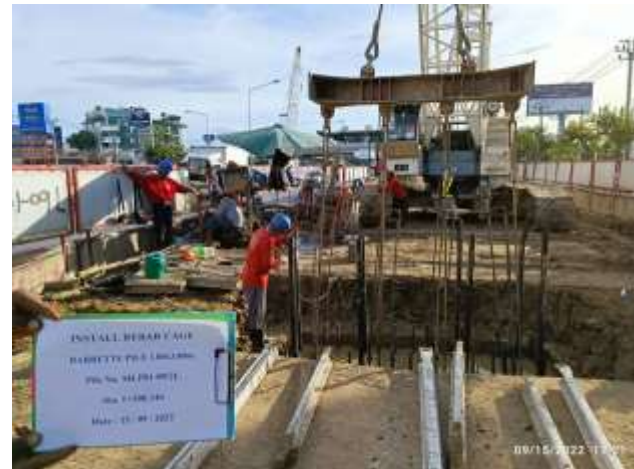
MLP01-09 งานติดตั้งโครงเหล็กเสริม
