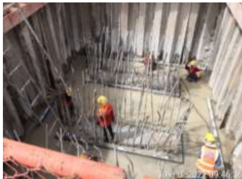
MLP01-18 ตัดเหล็ก Dowel
