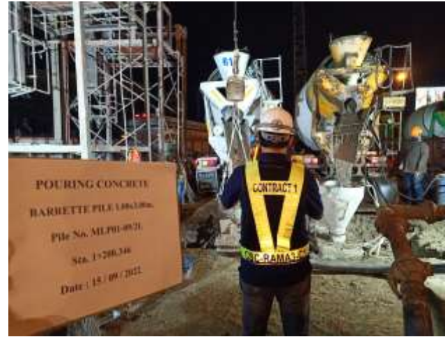
MLP01-09 งานเทคอนกรีต Barrette Pile
