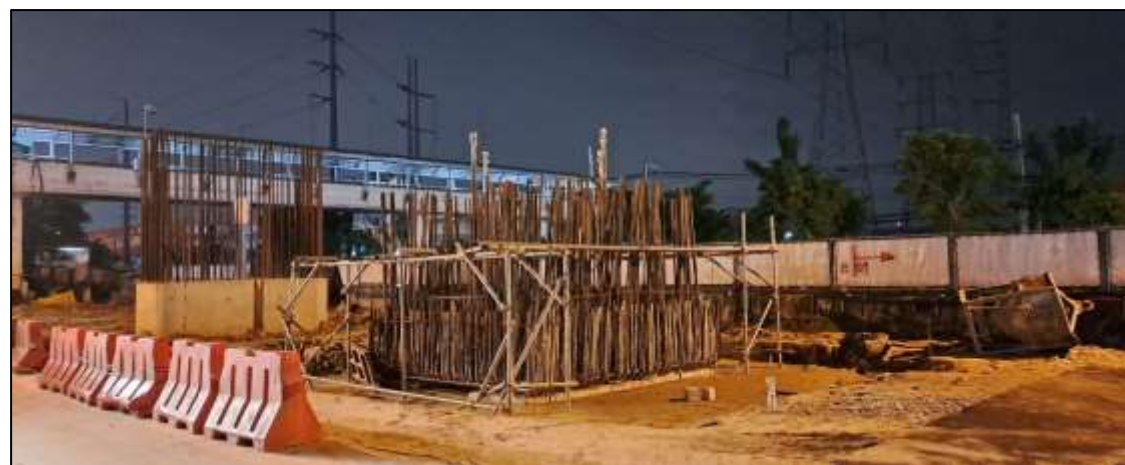
Install Rebar 2F3.80x1.00 m. EGAT#1
