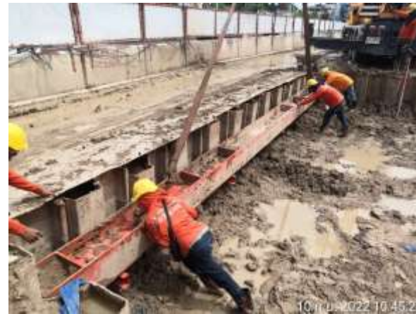
MLP01-18 งานปัก Sheet Pile และ ติดตั้ง Bracing
