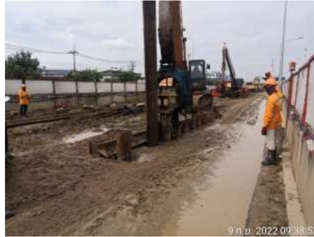
MLP01-17 งานปัก Sheet Pile และ ติดตั้ง Bracing
