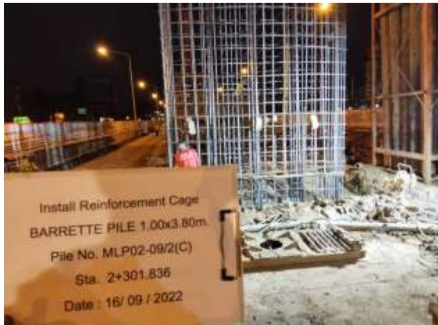
MLP02-09 งานติดตั้งโครงเหล็กเสริม
