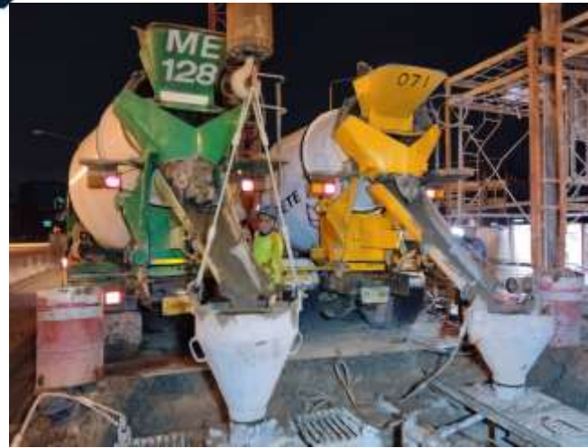
MLP02-07 งานเทคอนกรีต Barrette Pile
