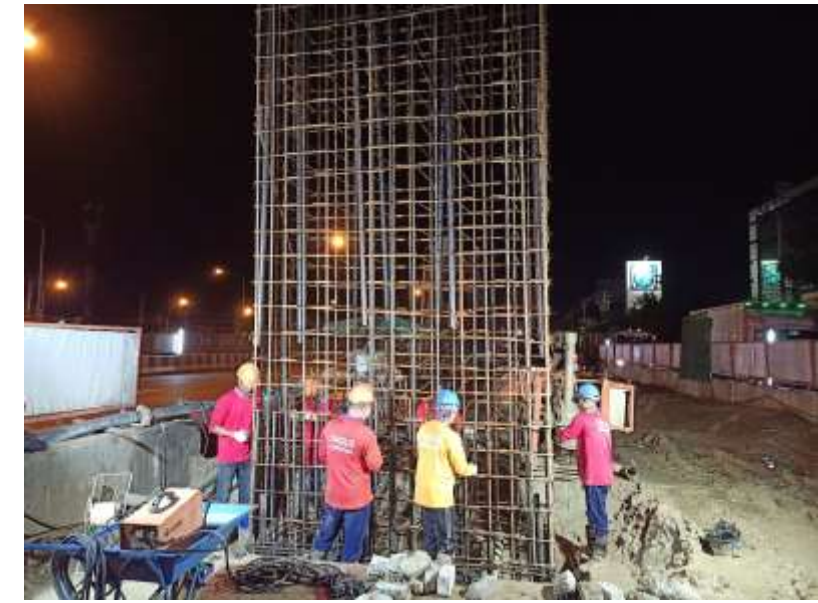
MLP01-13 งานติดตั้งโครงเหล็กเสริม
