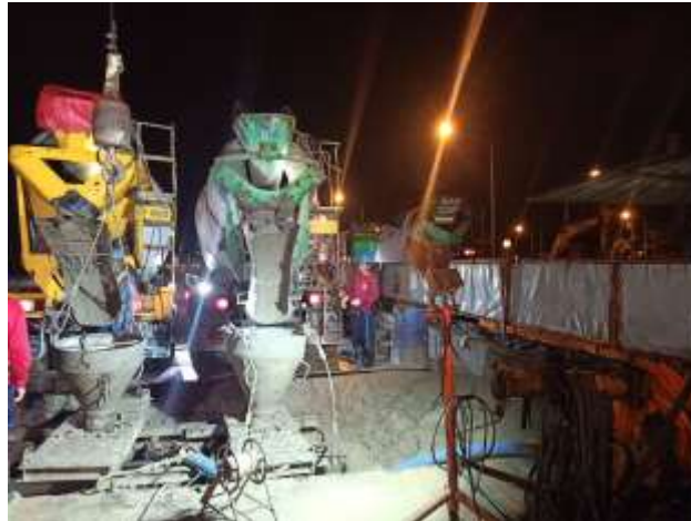
MLP01-10 งานเทคอนกรีต Barrette Pile
