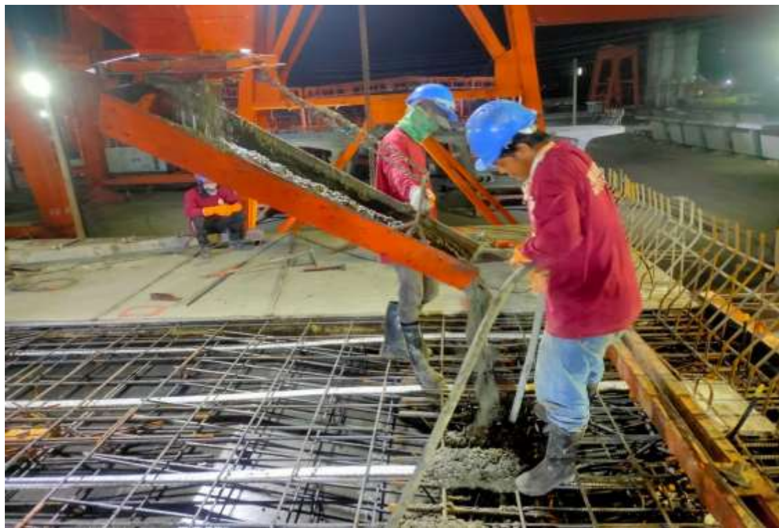
งานเทคอนกรีต Mould A8 : ROF1-08/4-V1-S
