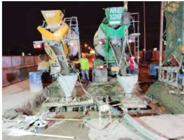
MLP01-28 งานเทคอนกรีต Barrette Pile
