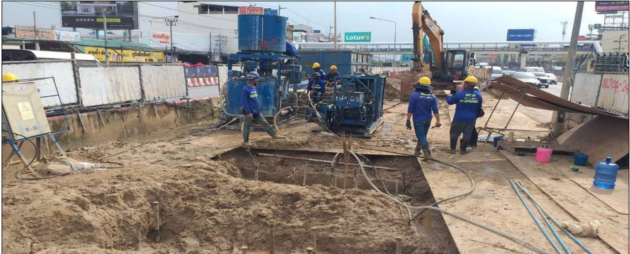
Toe grout Barrette ขนาด 3.80x1.00 m. MLP04-25C
