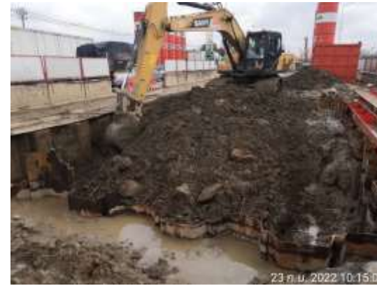
MLP01-15 งานปัก Sheet Pile และ ติดตั้ง Bracing
