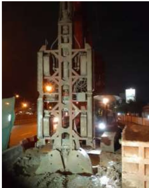
MLP01-13 งานเจาะเสาเข็ม Barrette Pile
