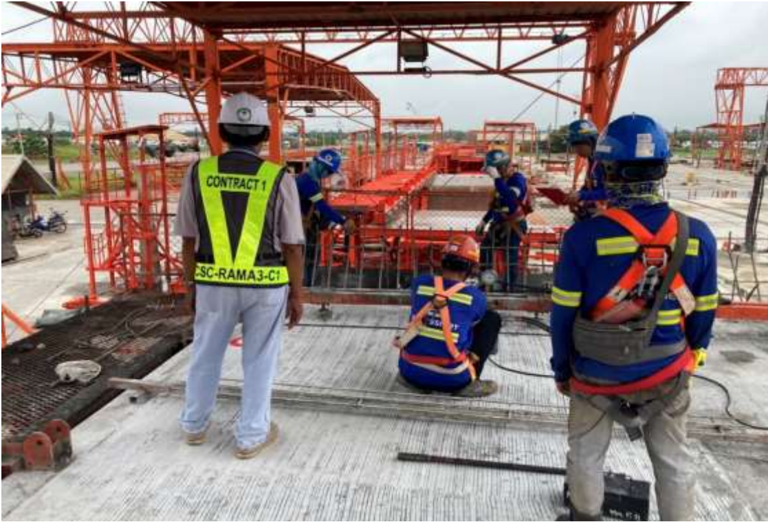
งาน Stressing Transverse Tendon Stage1 Mould A6 : RON1-23/5-V1-S
