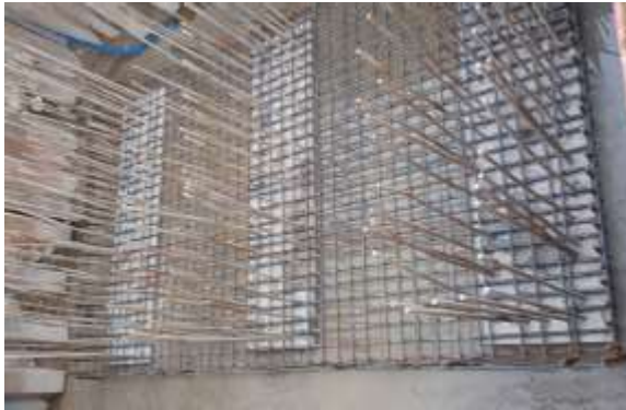
MLP01-23 งานเหล็กเสริมฐานราก
