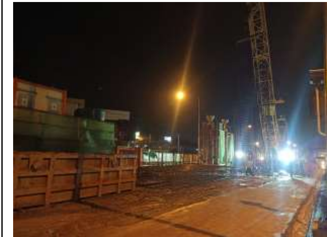
MLP01-31 งานติดตั้งโครงเหล็กเสริม
