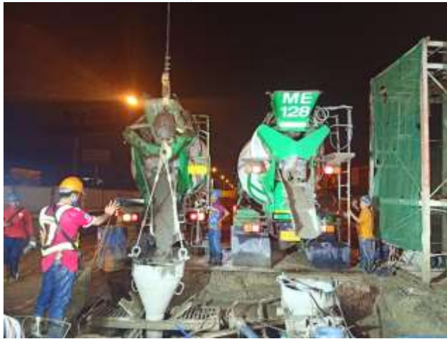
MLP01-30 งานเทคอนกรีต Barrette Pile
