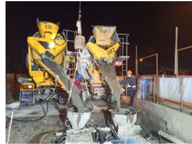
MLP01-14 งานเทคอนกรีต Barrette Pile
