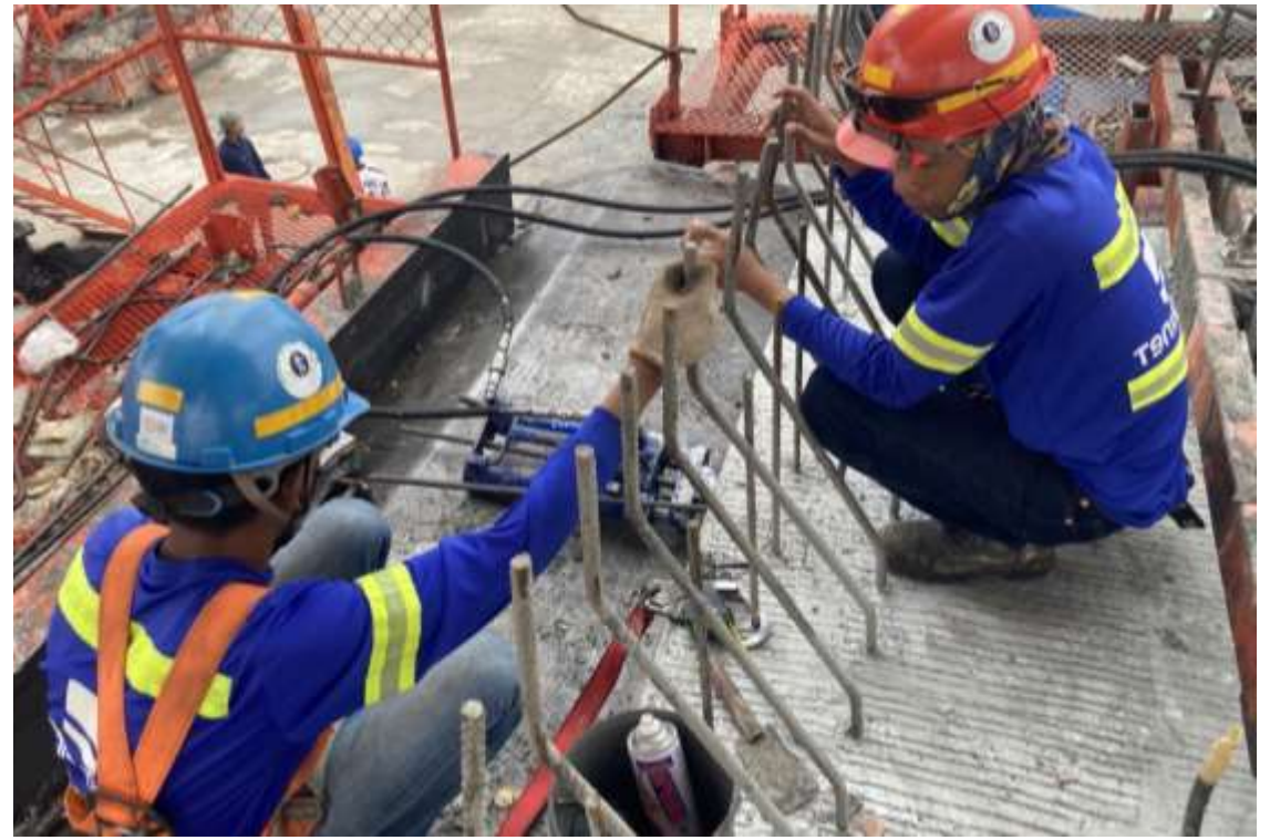
งาน Stressing Transverse Tendon Stage1 Mould A8 : ROF2-06/9-V1-S
