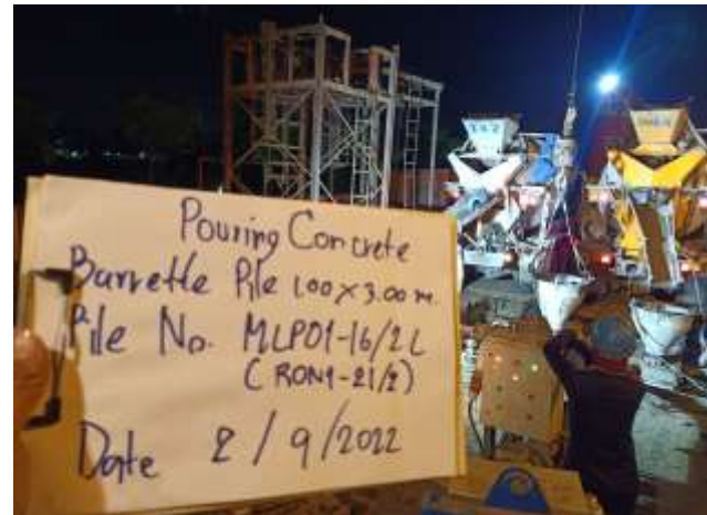
MLP01-16 งานเทคอนกรีต Barrette Pile
