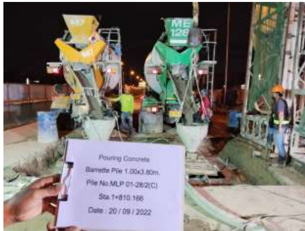
MLP01-28 งานเทคอนกรีต Barrette Pile
