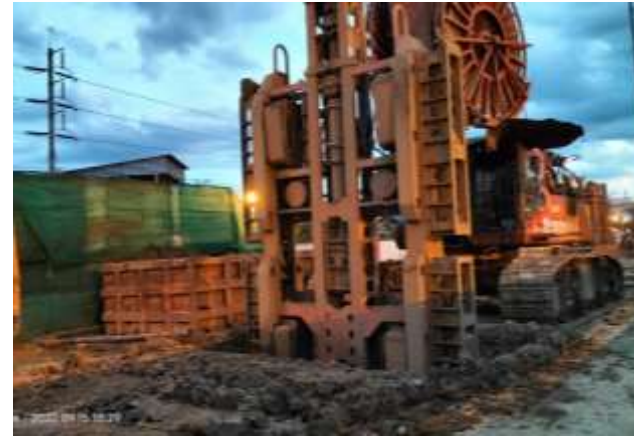
MLP02-10 งานเจาะเสาเข็ม Barrette Pile
