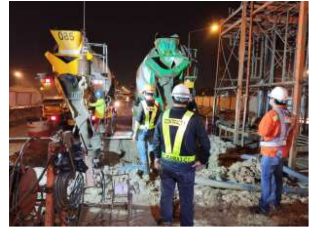
MLP02-08 งานเทคอนกรีต Barrette Pile
