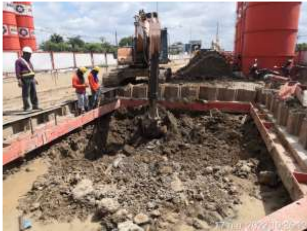
MLP01-17 งานปัก Sheet Pile และ ติดตั้ง Bracing
