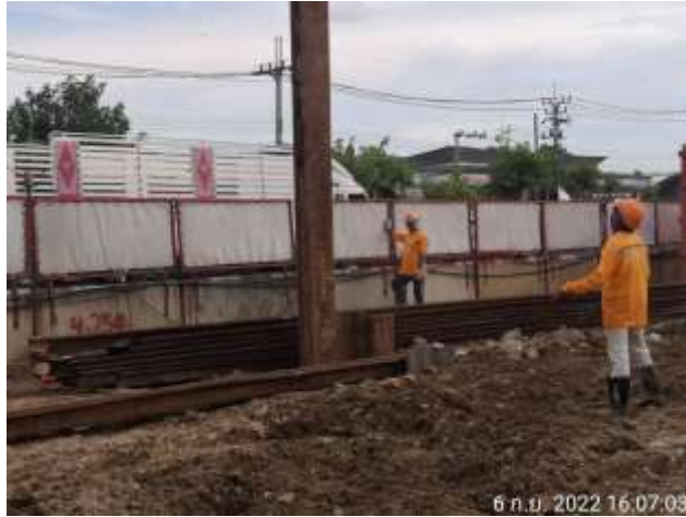
MLP01-17 งานปัก Sheet Pile และ ติดตั้ง Bracing
