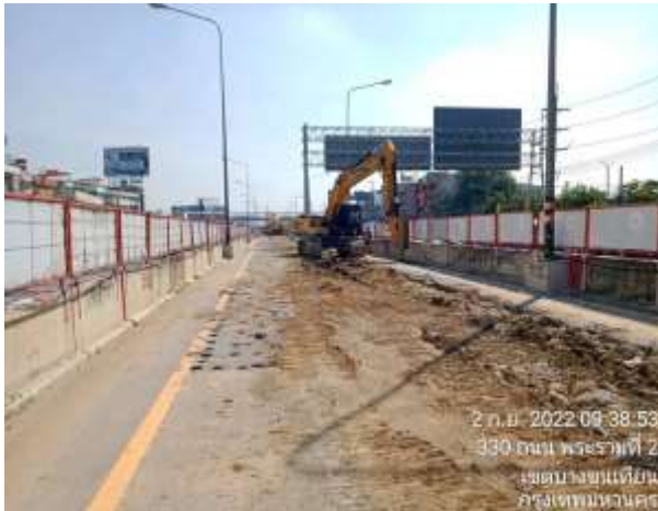
MLP04 - 08 สกัด Asphalt เตรียมพื้นที่
