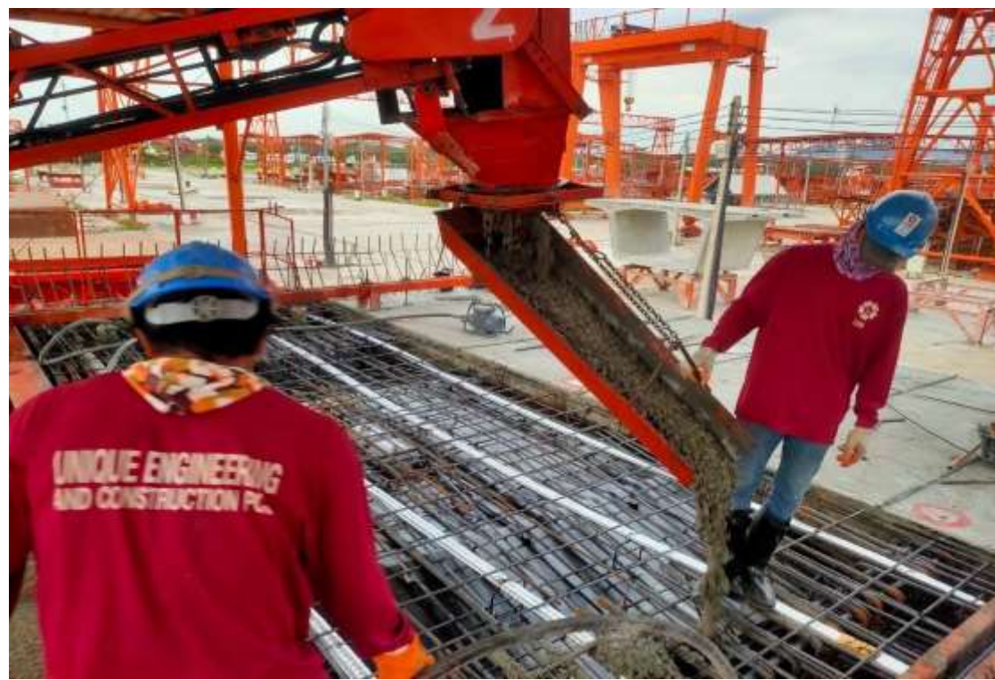
งานเทคอนกรีต Mould A6 : ROF1-23/5-V1-S
