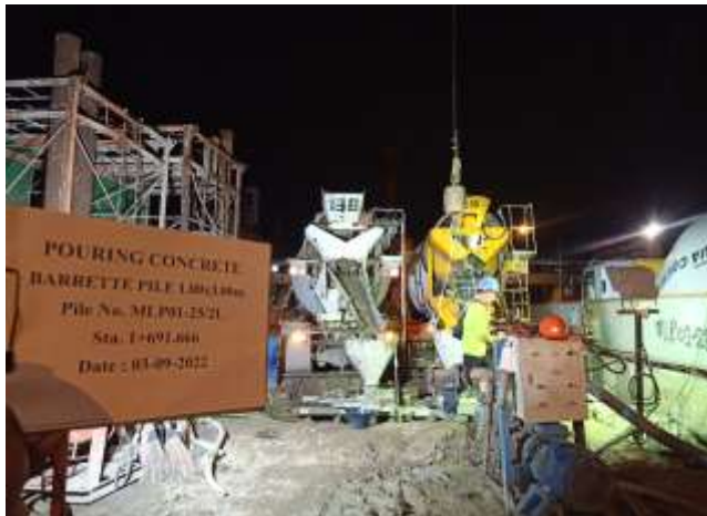
MLP01-25 งานเทคอนกรีต Barrette Pile
