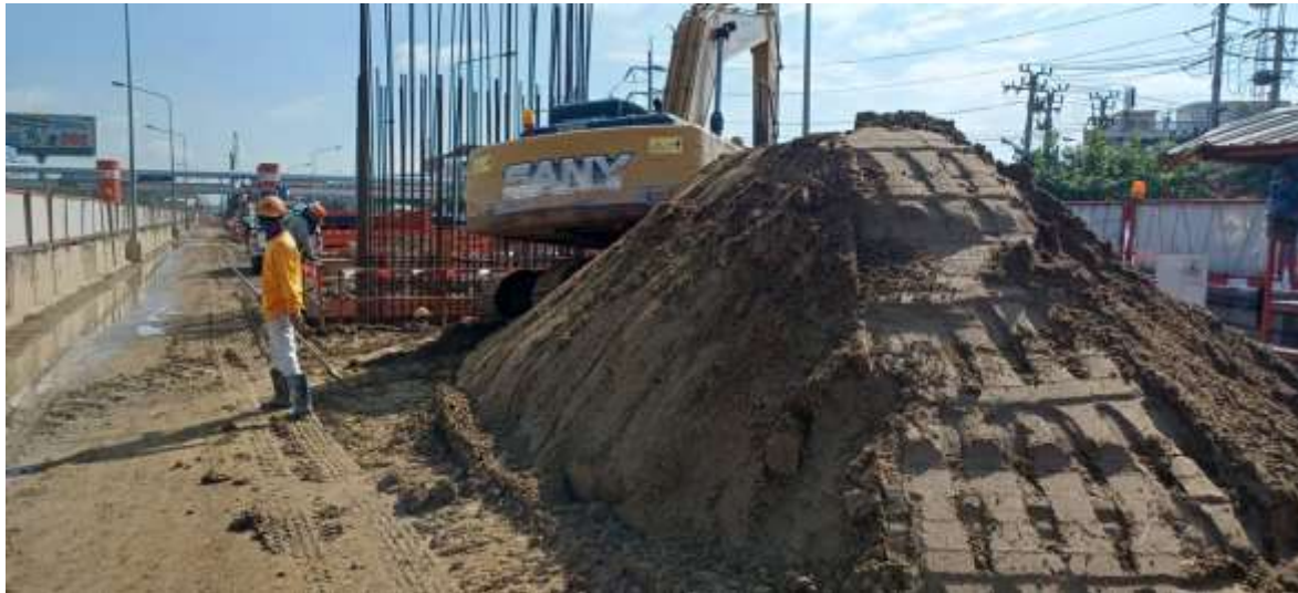
MLP01-22 งาน Backfill
