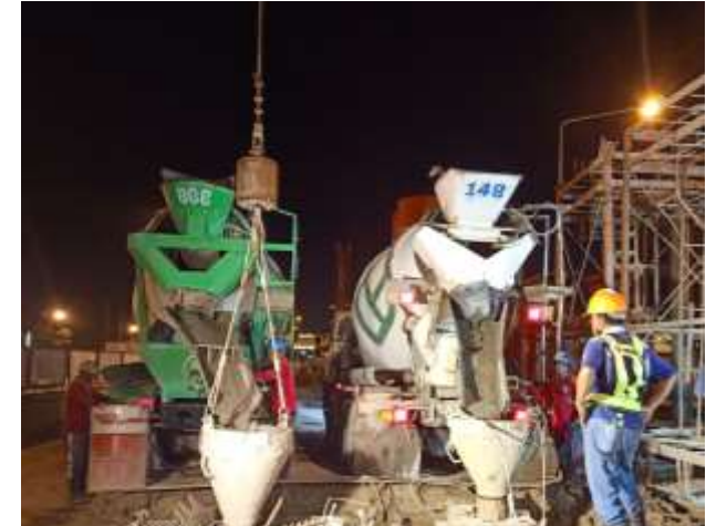
MLP02-03 งานเทคอนกรีต Barrette Pile
