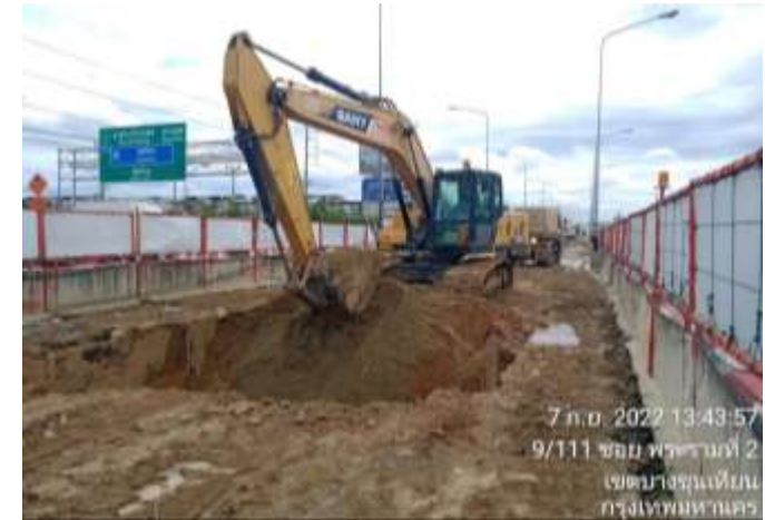
MLP04 - 01 ขุดดิน เตรียมงาน Guild wall
