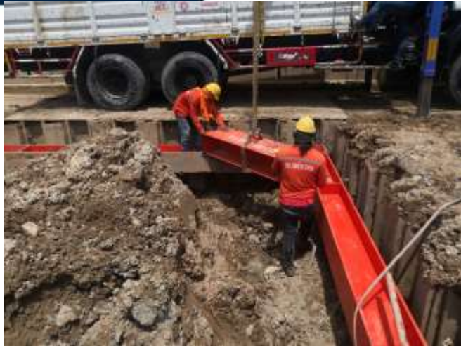
MLP01-14 งานปัก Sheet Pile และ ติดตั้ง Bracing
