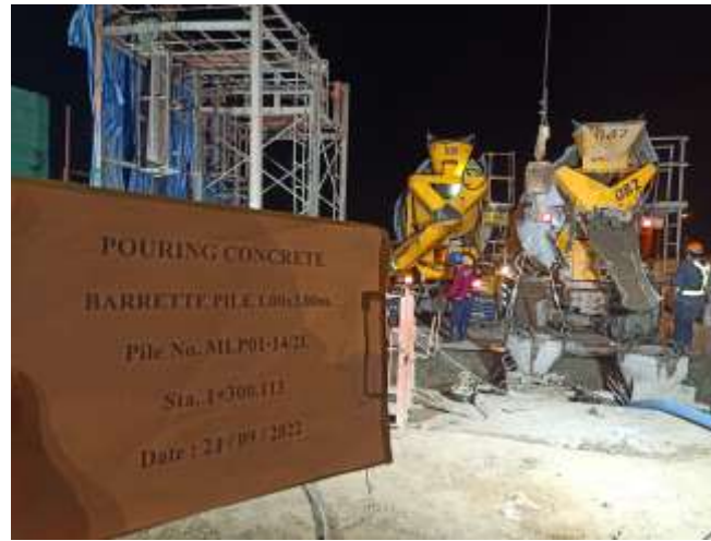
MLP01-14 งานเทคอนกรีต Barrette Pile
