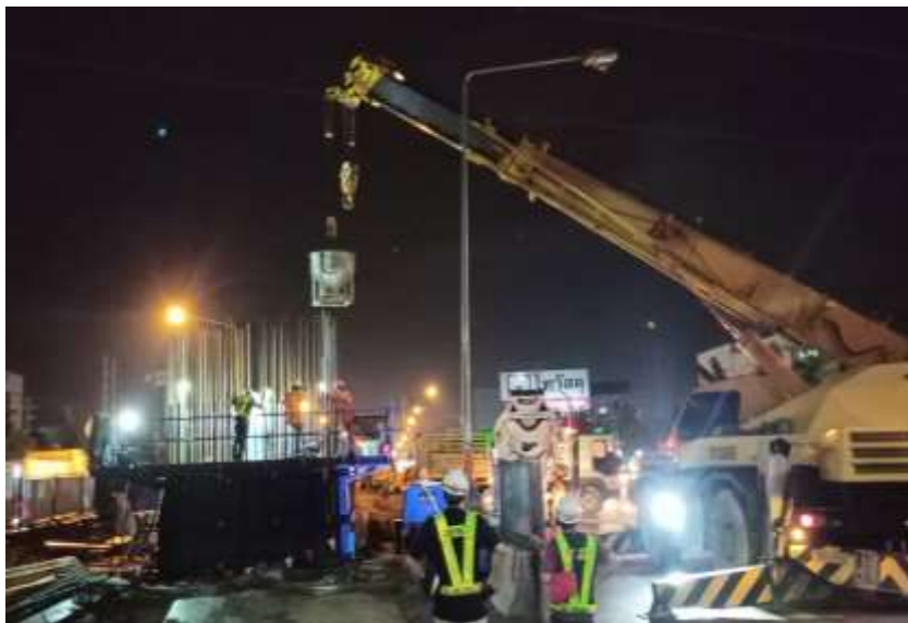
Pouring Concrete Column Step 1: Y-5 บริเวณ MLP05-06C
