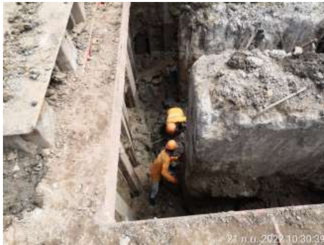
MLP01-14 งานปัก Sheet Pile และ ติดตั้ง Bracing
