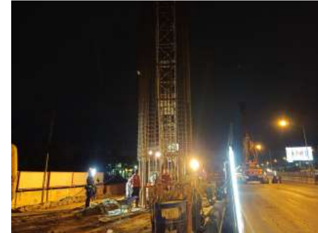
MLP01-14 งานติดตั้งโครงเหล็กเสริม
