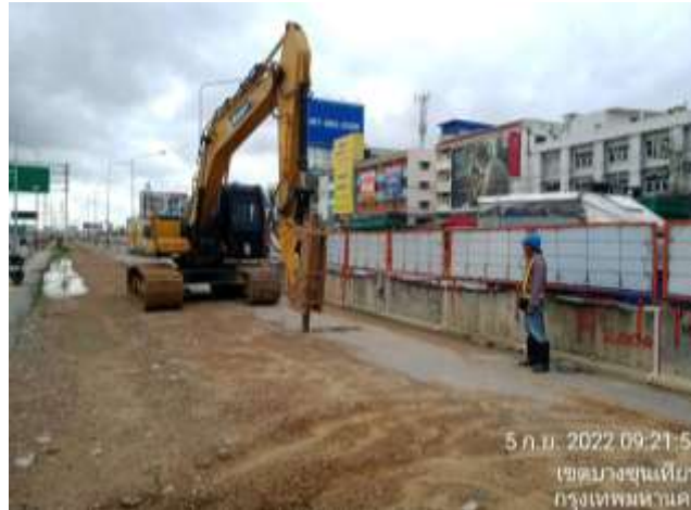
MLP04 - 13 สกัด Asphalt เตรียมพื้นที่
