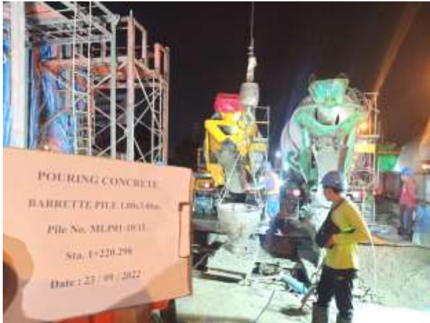
MLP01-10 งานเทคอนกรีต Barrette Pile
