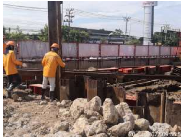
MLP01-16 งานปัก Sheet Pile และ ติดตั้ง Bracing
