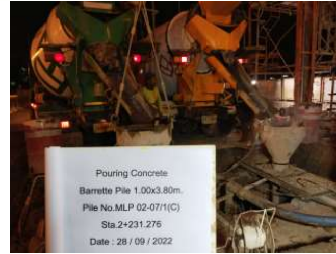
MLP02-07 งานเทคอนกรีต Barrette Pile
