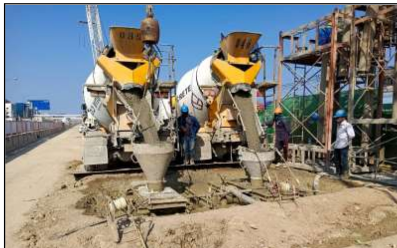
MLP01-19 เทคอนกรีตเสาเข็ม
