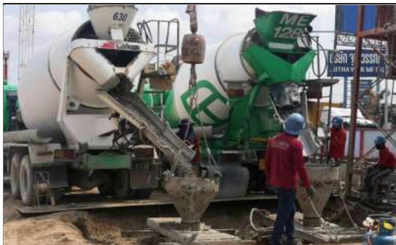
MLP01-16 เทคอนกรีตเสาเข็ม
