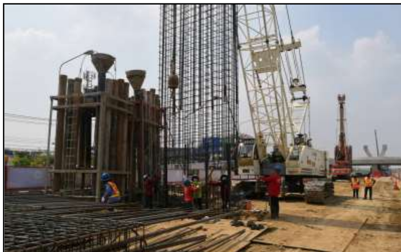
MLP01-10 ลงเหล็กเสาเข็ม
