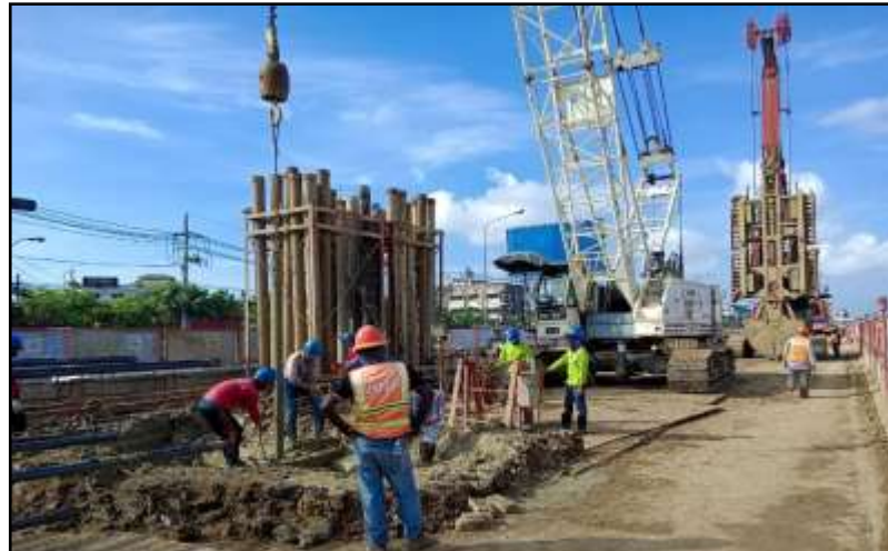
MLP01-23 ทำความสะอาด เตรียมลงเหล็กเสาเข็ม
