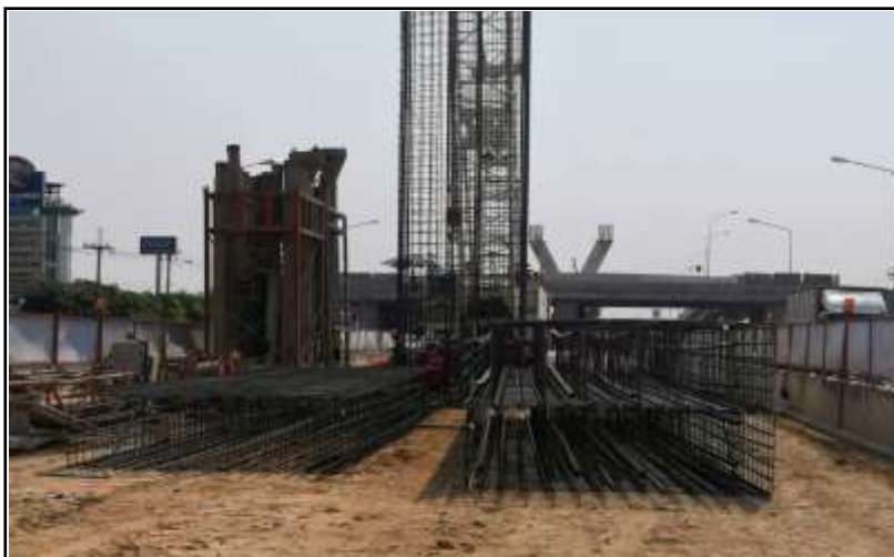
MLP01-08 ลงเหล็ก เตรียมเทคอนกรีต
