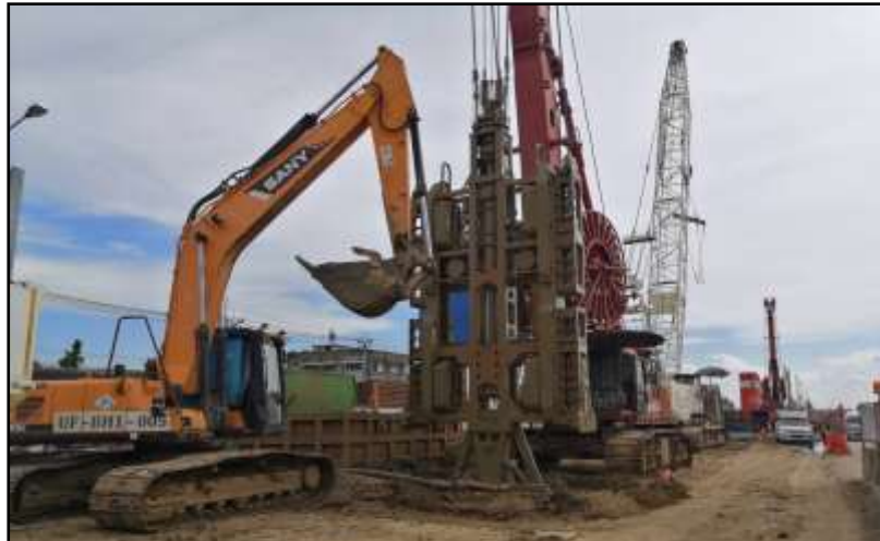
MLP01-22 ขุดเจาะเสาเข็ม
