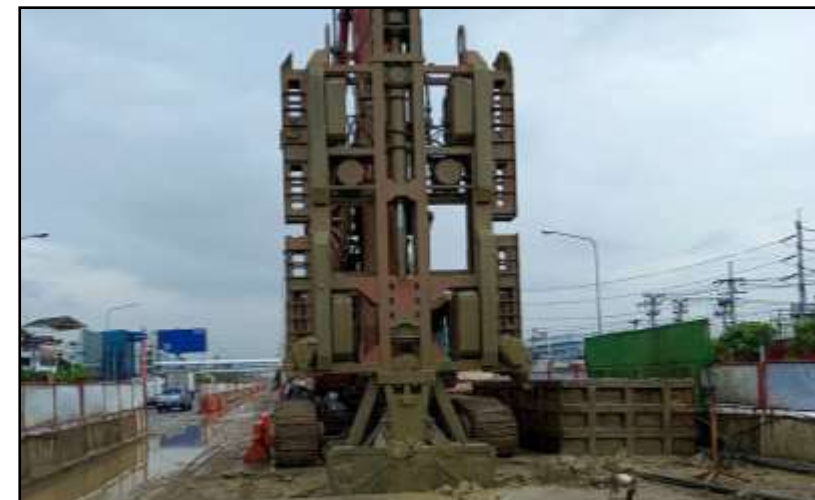
MLP01-21 ขุดเจาะเสาเข็ม
