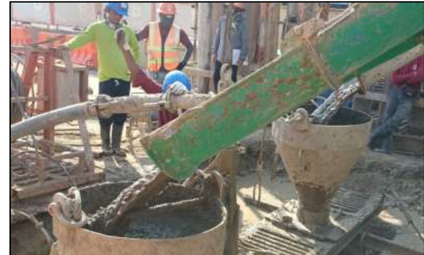
MLP01-25/3(C) เทคอนกรีต Barrette Pile
