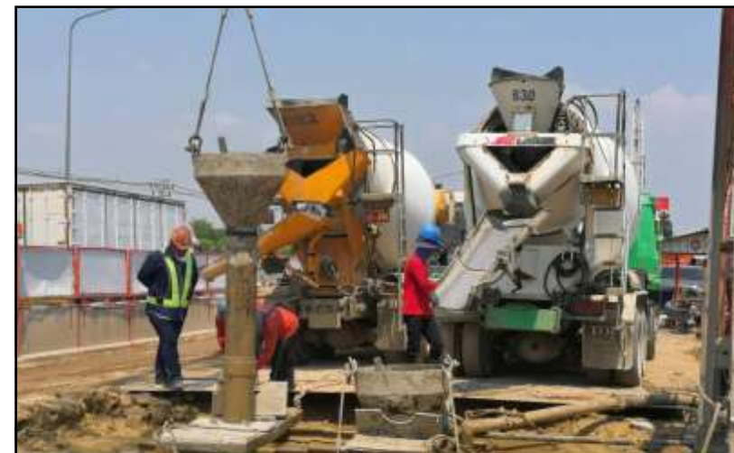
MLP01-12 เทคอนกรีต Barrette Pile
